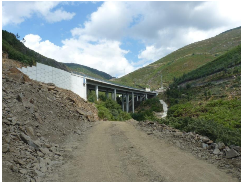
Figura 11. Pormenor do viaduto 9
