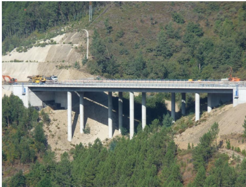
Figura 5. Pormenor do viaduto 6
