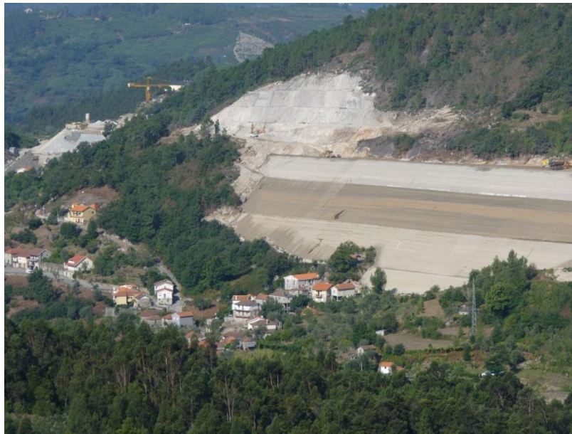
Figura 4. Pormenor do talude, onde se localiza o ponto EH4 J
