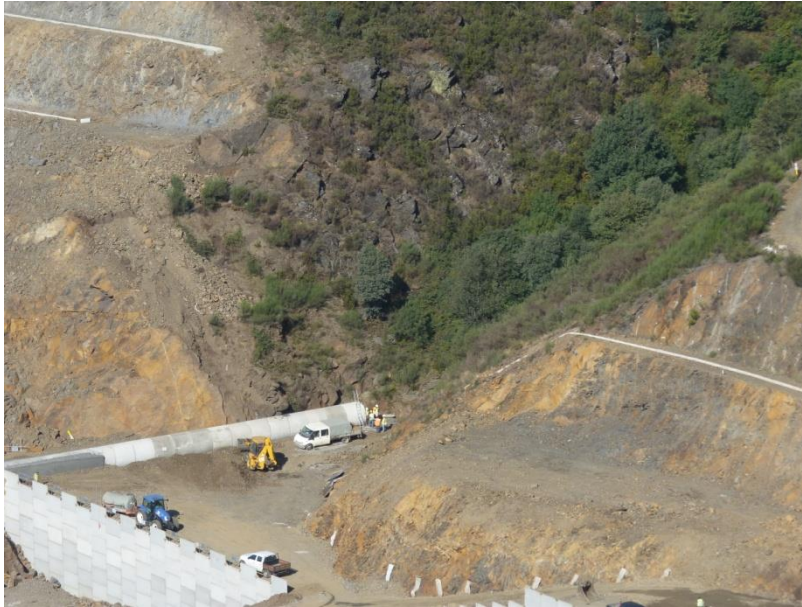
Figura 9. Pormenor do ponto EH11, a montante
