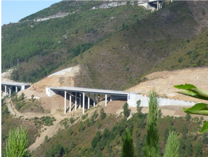
Figura 6. Pormenor do viaduto 7
