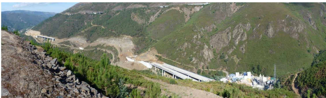
Figura 3. Panorâmica da obra
