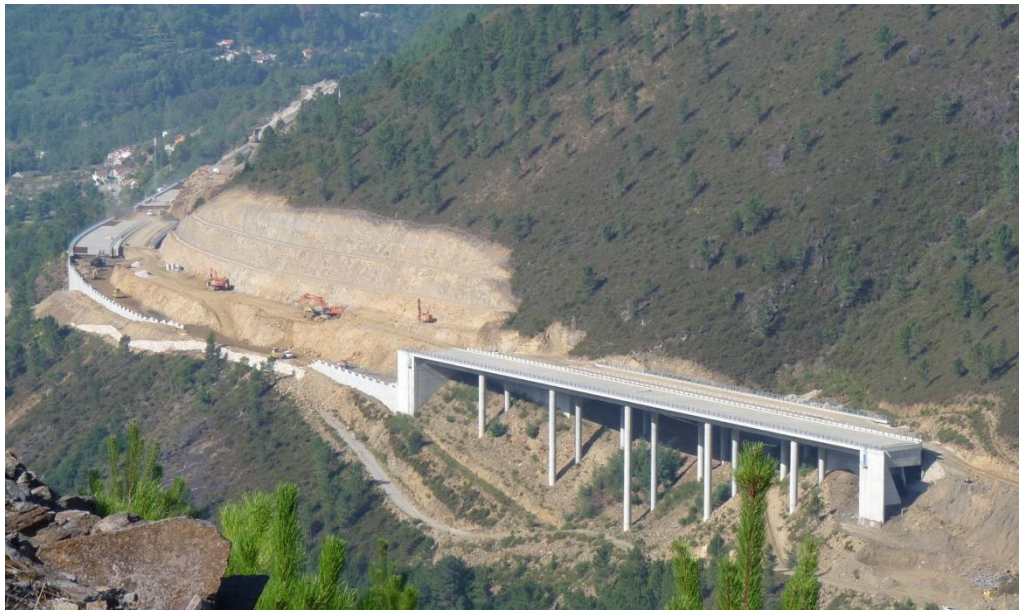
Figura 7. Pormenor do viaduto 8
