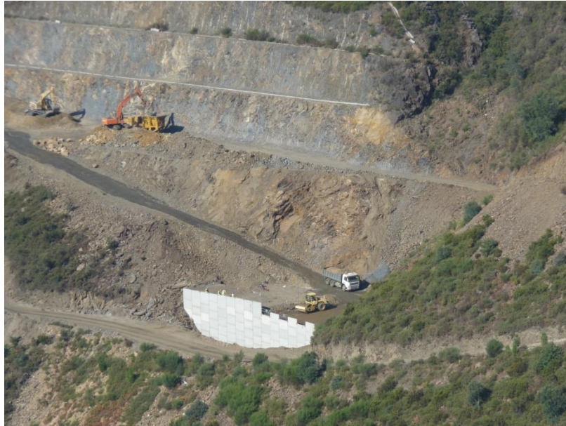
Figura 8. Pormenor do ponto EH10, a montante
