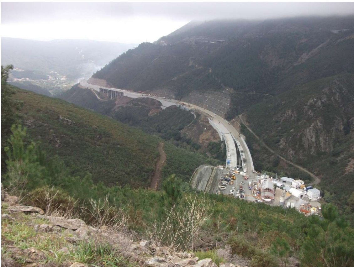
Figura 3. Panorâmica da obra
