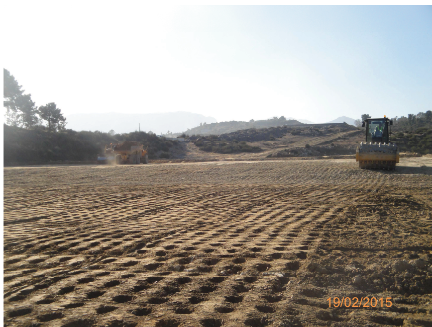
Registo Fotográfico 2 – Trabalhos de Aterro junto ao Pk 26+600
