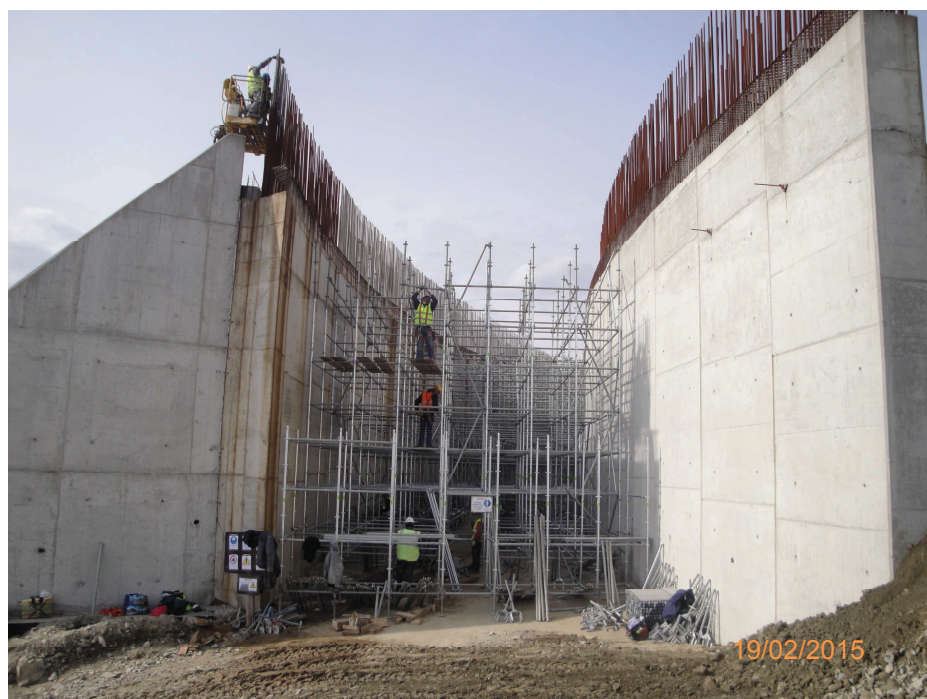
Registo Fotográfico 6 – Trabalhos em Obras de Arte (PI8)
