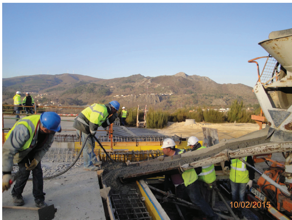
Registo Fotográfico 5 – Trabalhos em Obras de Arte (PI9A)
