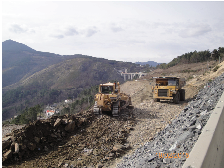
Registo Fotográfico 1 – Trabalhos de Escavação (Pk 21+500)
