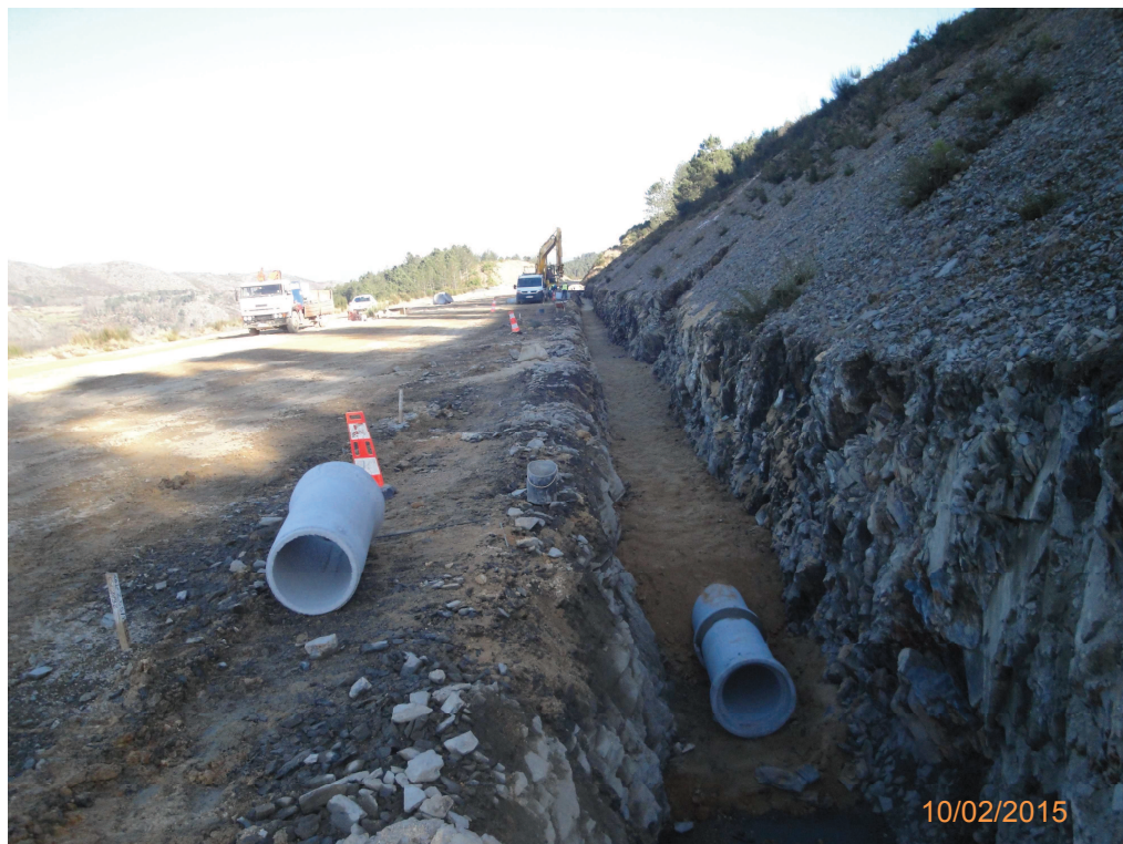
Registo Fotográfico 3 – Trabalhos de Drenagens (colector) junto ao Pk 21+100
