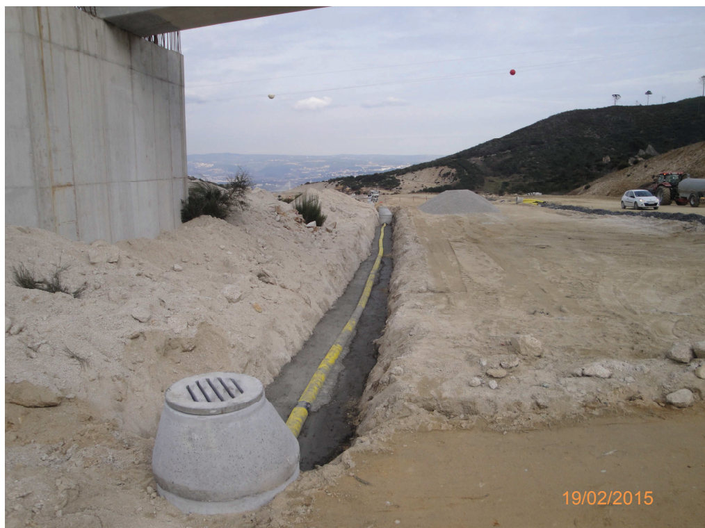
Registo Fotográfico 4 – Trabalhos de Drenagens (drenos) junto ao Pk 26+930
