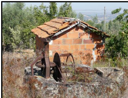
Poço n.º 1 do Lanço IP2 – Vale Benfeito / Junqueira
