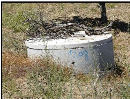
Poço n.º 4 do Lanço IP2 – Vale Benfeito / Junqueira
