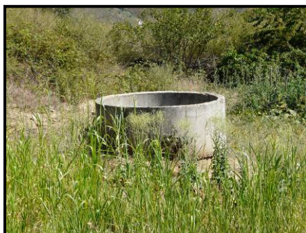
Poço n.º 8 do Lanço IP2 – Vale Benfeito / Junqueira
