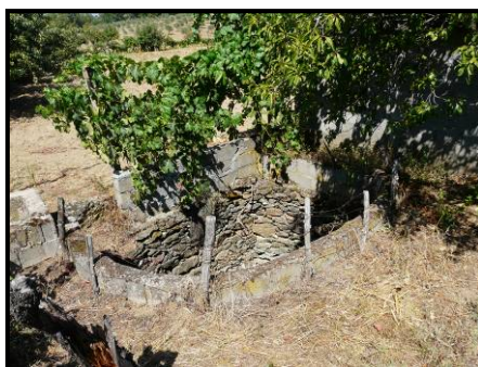
Poço n.º 7 do Lanço IP2 – Vale Benfeito / Junqueira
