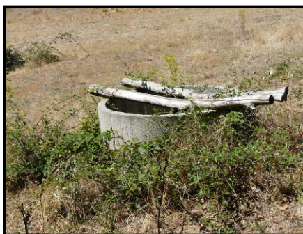
Poço n.º 6 do Lanço IP2 – Vale Benfeito / Junqueira
