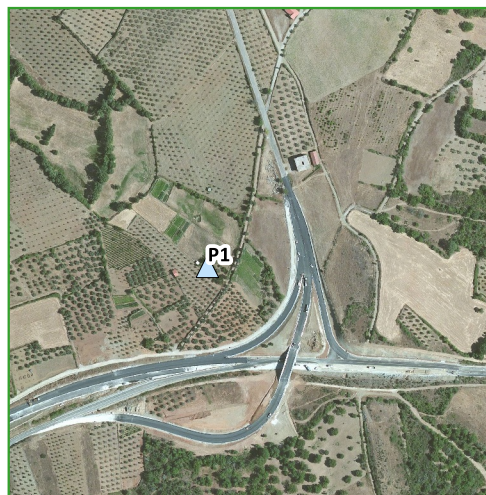
P1 - Poço ao km 0+364
