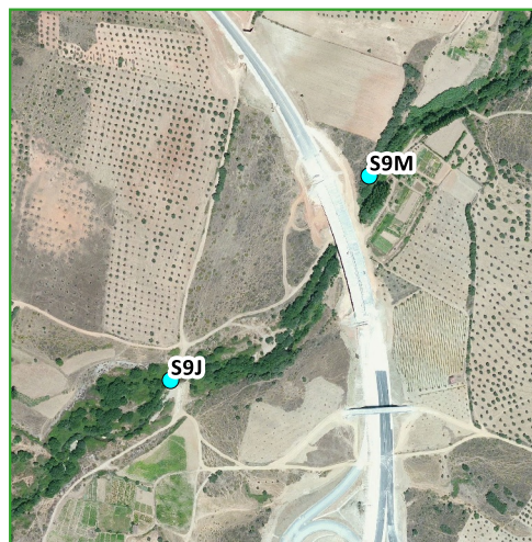
S9 - Ribeira da Vilariça, Viaduto 6
