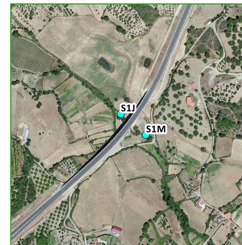
S1 - Ribeiro do Vale Pereiro - Viaduto 1
