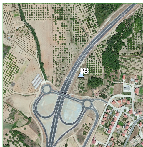
P3 - Poço ao km 2+636
