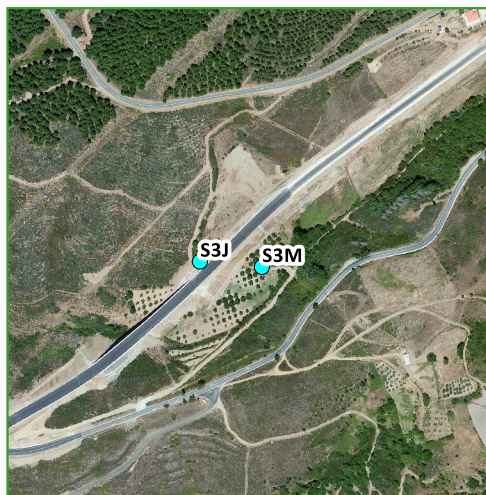
S3 - Ribeira do Mouco, Viaduto 1.1
