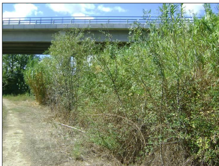
Figura 16 - Ribeira da Laça, a jusante da travessia, localizado ao km 22+750.
