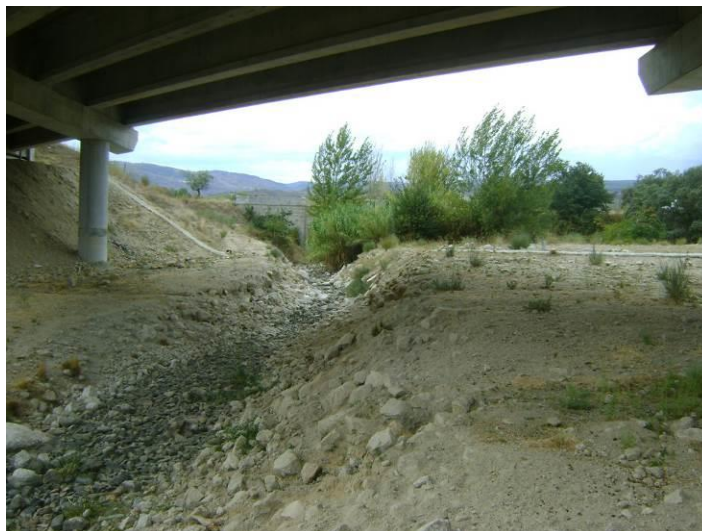
Figura 19 - Ribeira de S. Martinho, a montante da travessia, localizado ao km 26+750.
