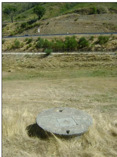
Figura 27 - Poço localizado ao km 4+137 do lado direito da via
