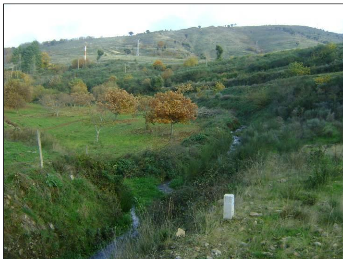
Figura 5 - Ribeira do Mouco, a montante da travessia, localizado ao km 5+250.
