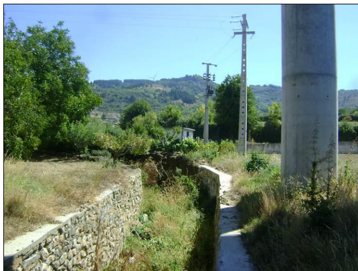
Figura 1 - Ribeiro do Vale Pereiro, a montante da travessia, localizado ao km 1+900.
