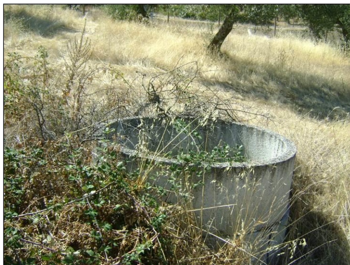
Figura 29 - Poço localizado ao km 19+641 do lado esquerdo da via
