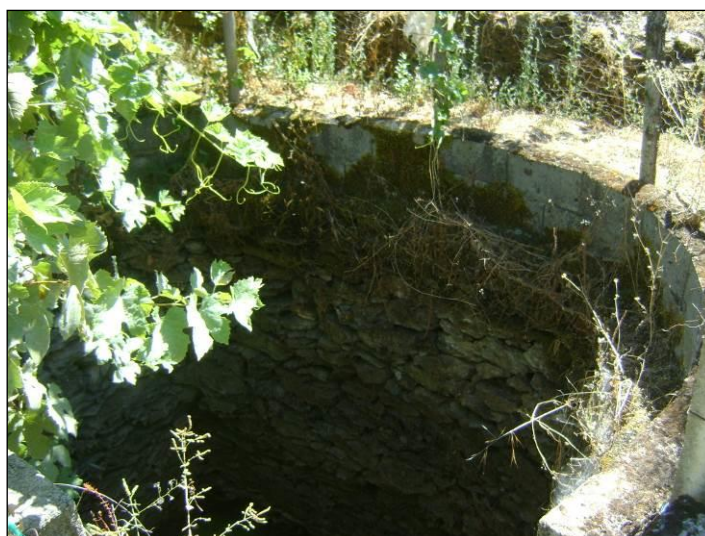
Figura 28 - Poço localizado ao km 8+887 do lado esquerdo da via
