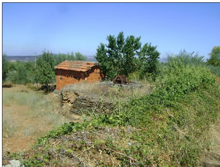
Figura 23 - Poço localizado ao km 0+364 do lado direito da via.
