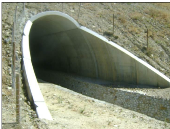
Figura 4 - Ribeira da Valsada, a jusante da travessia, localizado ao km 3+628.
