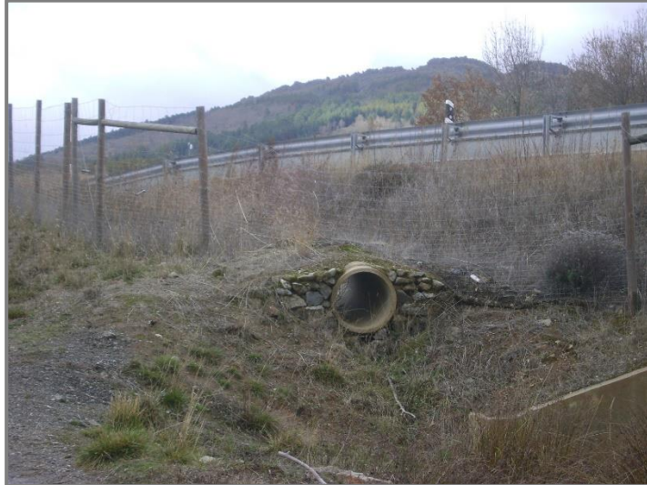
Figura 18 – Ponto na Caixa de Visita, ao PK 9+450.
