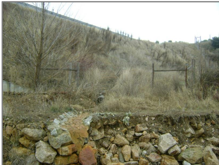
Figura 19 – Ponto na Caixa de Visita, ao PK 35+860.
