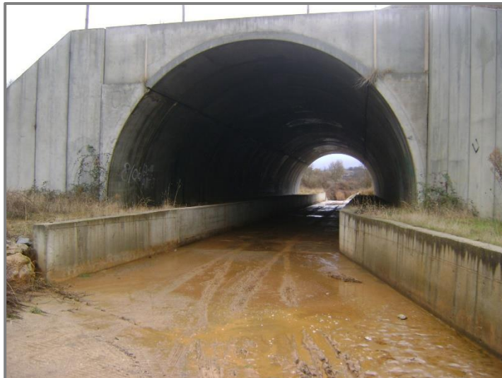
Figura 16 – Ponto de monitorização a montante da PH (35.2) – Ribeira das Duas Igrejas, ao km 35+840.
