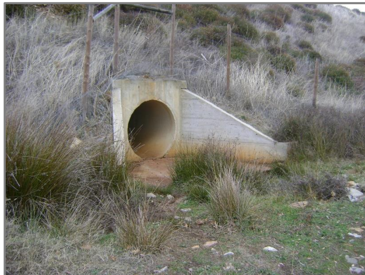
Figura 5 – Ponto de monitorização a jusante da PH (7.3) – Ribeira das Devesas, ao km 7+940
