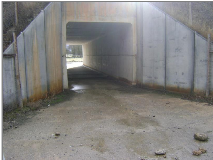
Figura 14 – Ponto de monitorização a montante da PH (33.1) – Ribeira do Rodilhão, ao km 33+015.
