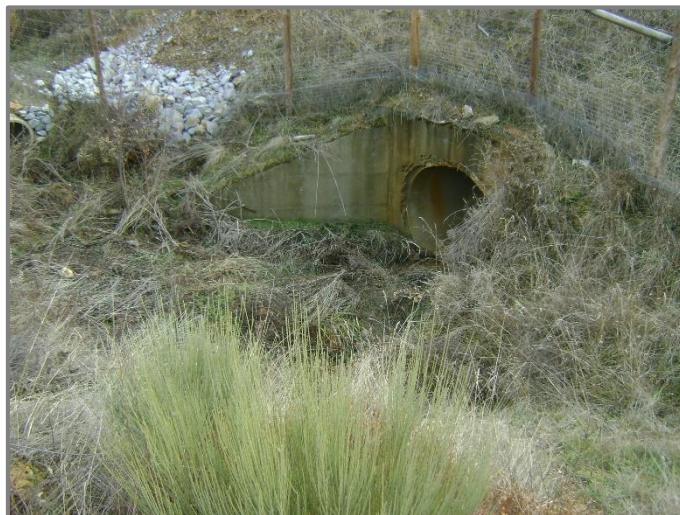
Figura 2 – Ponto de monitorização a montante da PH (1.1), cerca do km 1+200.
