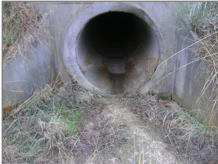
Figura 13 – Ponto de monitorização a jusante da PH (28.3) – Ribeira do Vale Palheiros, ao km 28+608
