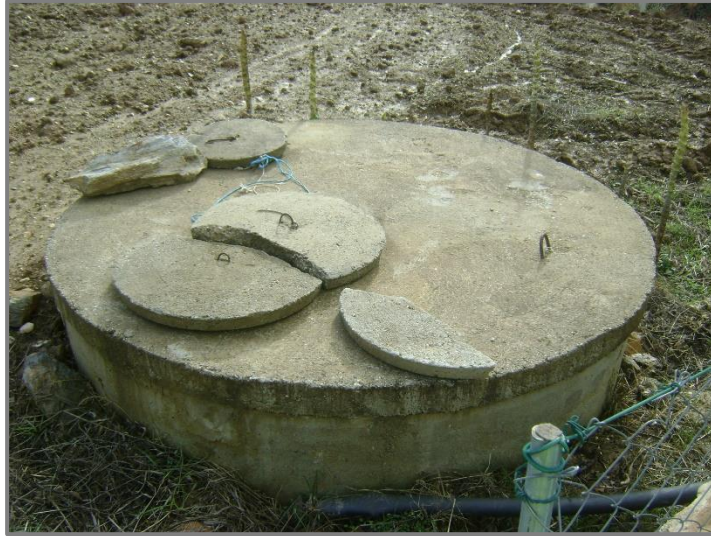
Figura 22 – Ponto de monitorização (P4) localizado ao km 1+700 do lado direito da via.
