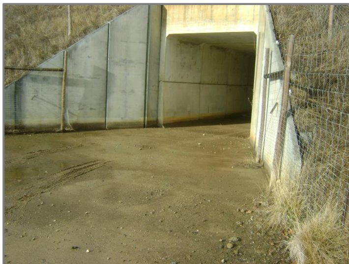
Figura 15 – Ponto de monitorização a jusante da PH (33.1) – Ribeira do Rodilhão, ao km 33+015.
