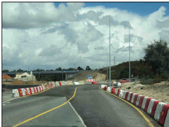
Fotografia 15 – Sinalização temporária – ER378
