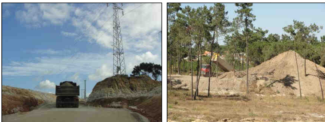
Fotografias 18 e 19 – Transporte de terras para armazenamento nos depósitos temporários
