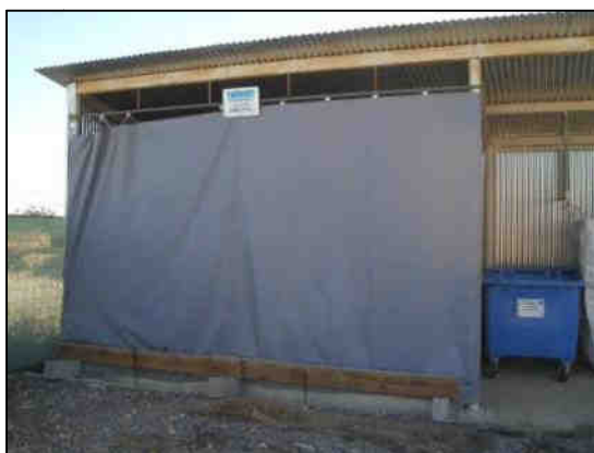
Fotografia 5 – Vista geral do parque de produtos/resíduos perigosos
