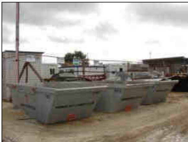
Fotografia 14 – Exemplo dos contentores colocados no estaleiro para recolha selectiva de resíduos
