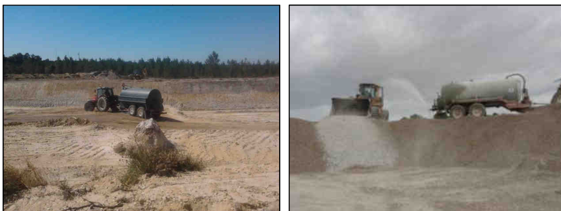
Fotografias 2 e 3 – Humidificação das camadas de aterros com recurso a joppers
