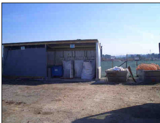
Fotografia 10 – Vista geral do parque de produtos/resíduos perigosos e do parque de resíduos não perigosos
