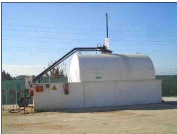
Fotografia 7 – Reservatório de combustível
