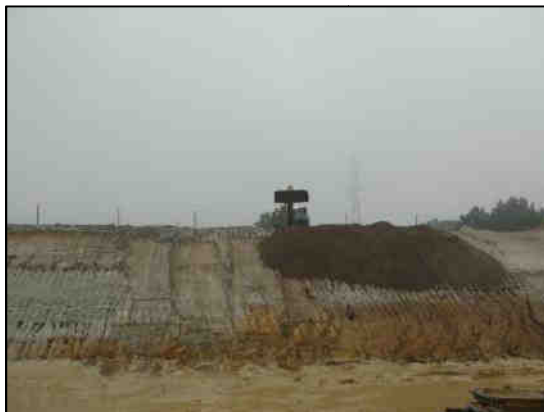
Fotografias 20 e 21 – Reutilização das terras armazenadas nos depósitos temporários: reaproveitamento dos solos na execução de aterros e revestimento de taludes com terra vegetal
