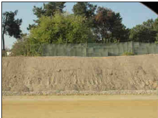
Fotografias 20 e 21 – Reutilização das terras armazenadas nos depósitos temporários: reaproveitamento dos solos na execução de aterros e revestimento de taludes com terra vegetal
