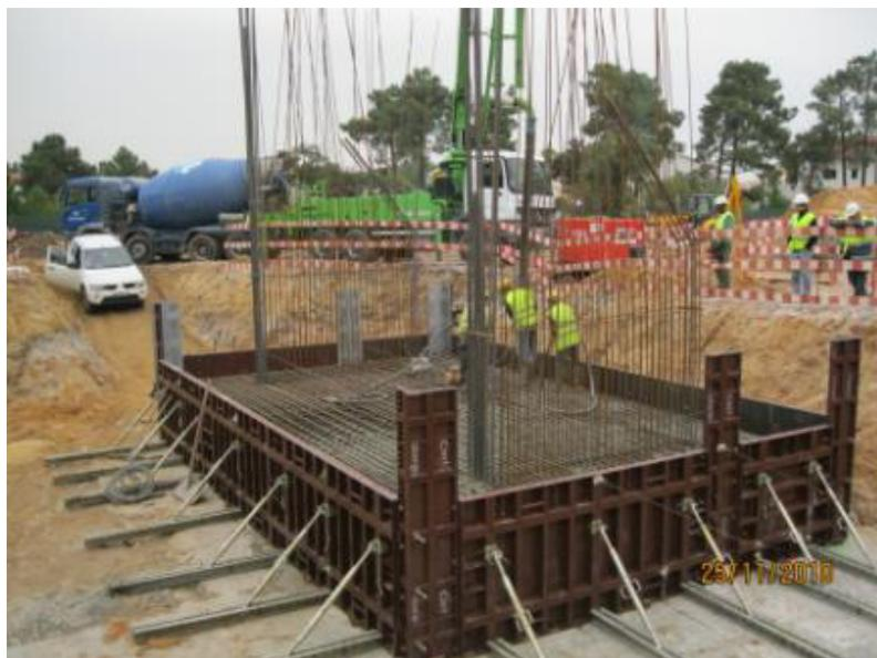
**Foto nº 1** – Betonagem de Sapata.
