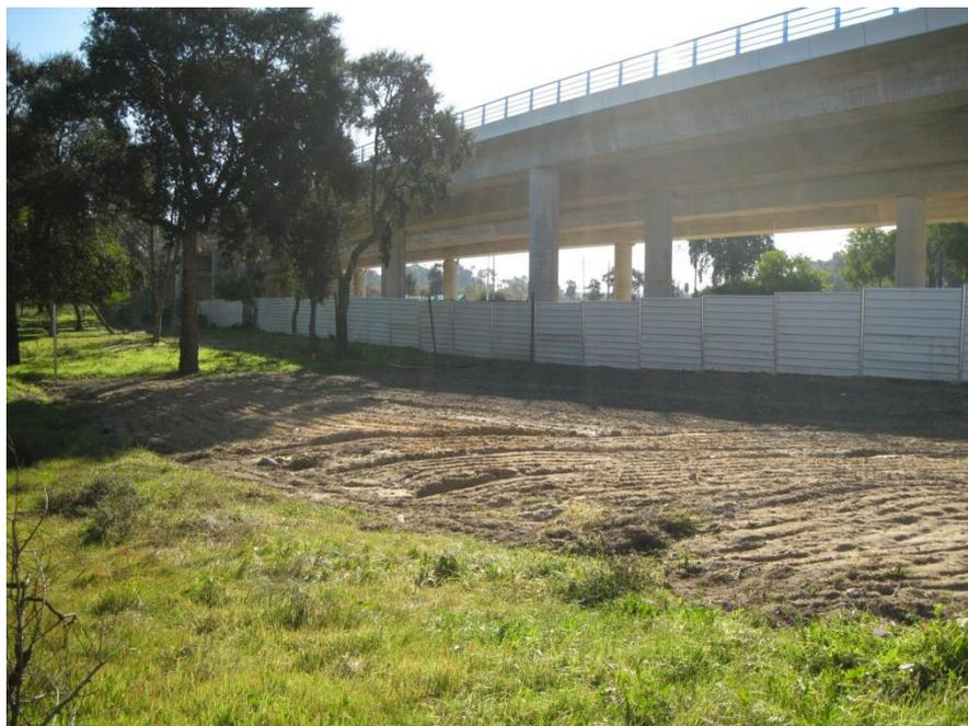
**Foto nº 4** – limpeza do terreno afeto às infraestruturas de apoio para a construção do Viaduto de Belverde.
