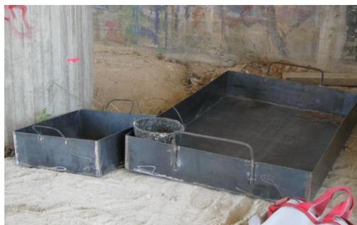
Foto nº 6 – Bacias de contenção de derrames e para armazenamento de produtos químicos nas frentes de trabalho.
