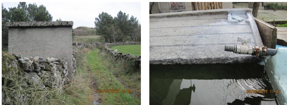
Figura 3 – PA VNIII_059, Foto do local da nascente e do local de medição
