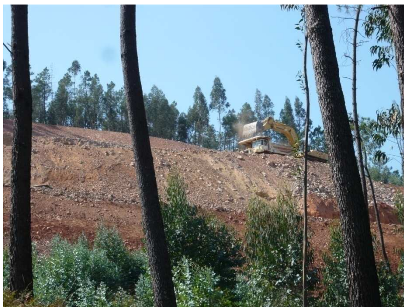
Figura 4.4 – Trabalhos de movimentação de terras nas imediações do ponto de amostragem T2.1.
