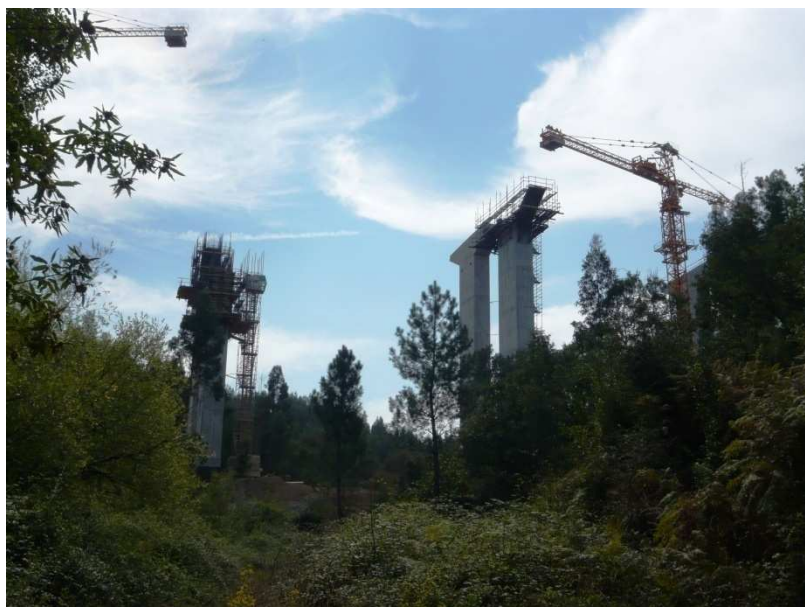
Figura 4.2 – Trabalhos na envolvente do ponto de amostragem T1.2.
