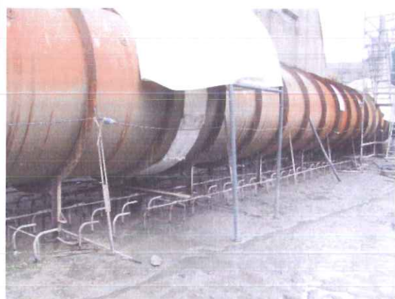
Figura 10 – Montagem da Descarga de Fundo
