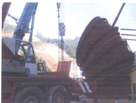
Figura 7 – Montagem do Draft Tube
