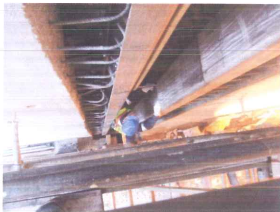
Figura 5 – Montagem Carris da Comporta Ensecadeira da Restituição
