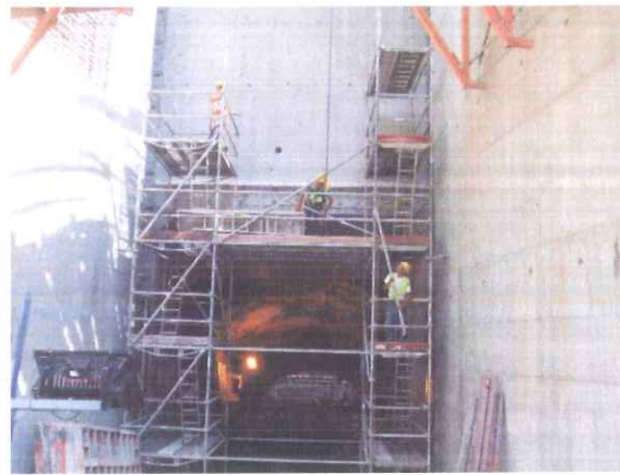
Figura 4 – Montagem Comporta Ensecadeira da Restituição
