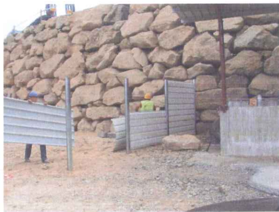
Figura 3 – Montagem Estaleiro Social
