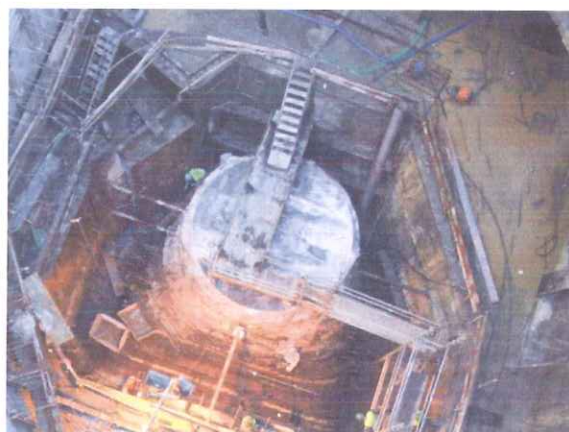
Figura 8 – Montagem do Draft Tube
