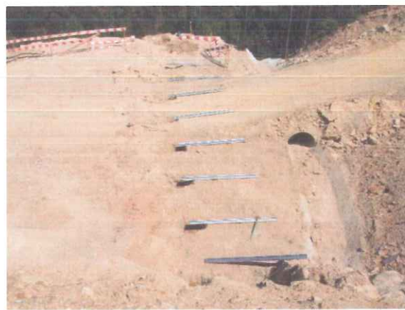
Figura 2 – Montagem Estaleiro Social
