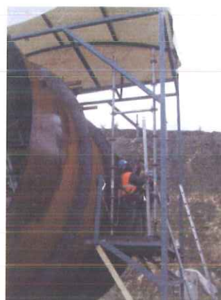
Figura 6 – Pré-Fabrico da Blindagem da Galeria de Adução
