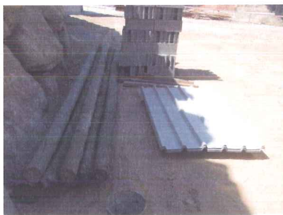
Figura 1 – Montagem Estaleiro Social
