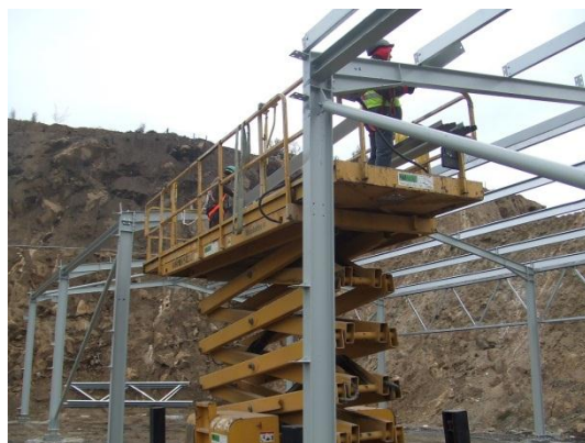
Figura 10 – Montagem Pavilhão Industrial
