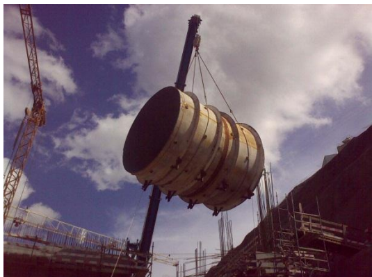
Figura 5 – Colocação das Virolas na Galeria de Adução
