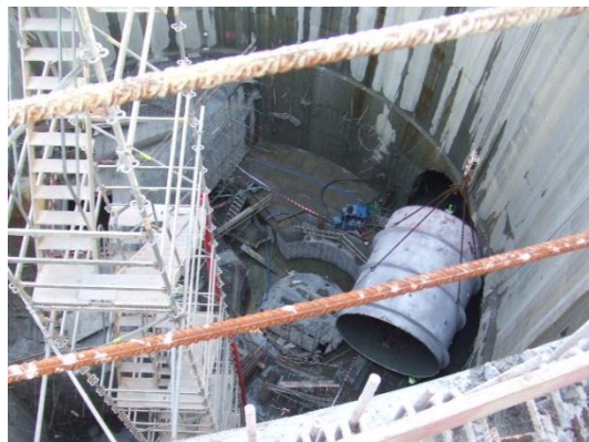
Figura 6 – Colocação das Virolas na Galeria de Adução
