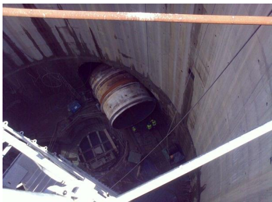
Figura 7 – Colocação das Virolas na Galeria de Adução
