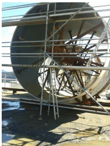
Figura 1 – Pré-Fabrico das Virolas da Blindagem da Galeria de Adução
