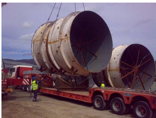
Figura 3 – Transporte das Virolas da Blindagem da Galeria de Adução
