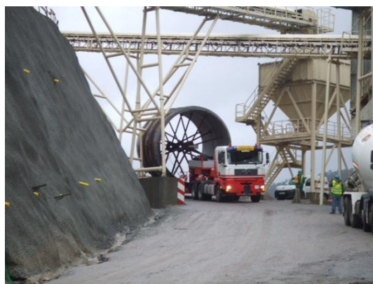
Figura 4 – Transporte das Virolas da Blindagem da Galeria de Adução
