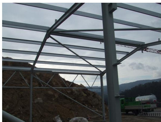
Figura 12 – Montagem Pavilhão Industrial
