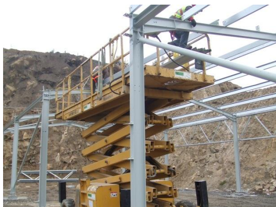
Figura 11 – Montagem Pavilhão Industrial
