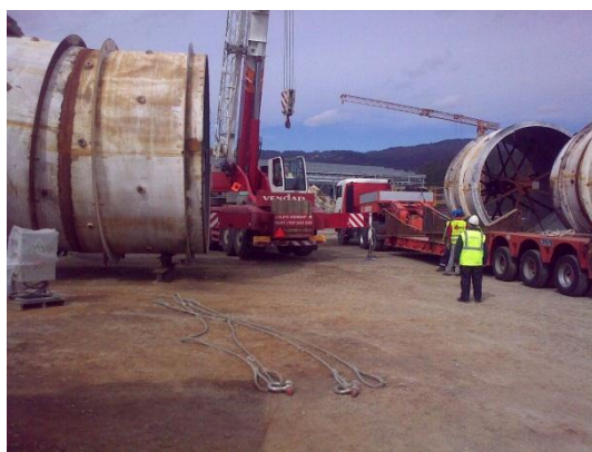
Figura 2 – Transporte das Virolas da Blindagem da Galeria de Adução
