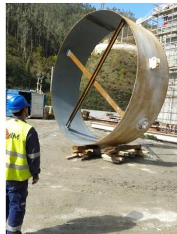
**Figura 6** – Descarga das peças da Caixa Espiral
