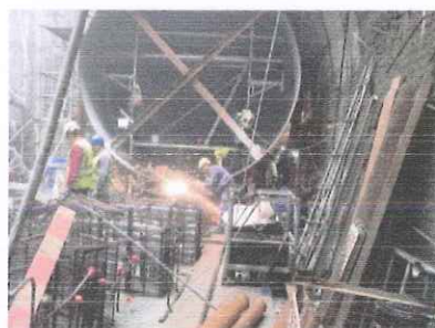
Figura 4 □ Montagem das Virolas da Blindagem da Galeria de Adução (Escalão de Ribeiradio)
