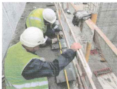
Figura 1 □ Montagem do Caminho de Rolamento da Ponte Rolante (Escalão de Ribeiradio)
