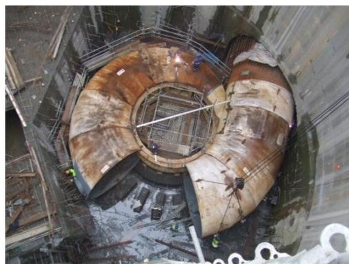
**Figura 4** – Montagem da Caixa Espiral (Escalão de
