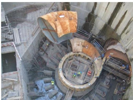
**Figura 3** – Montagem da Caixa Espiral (Escalão de
