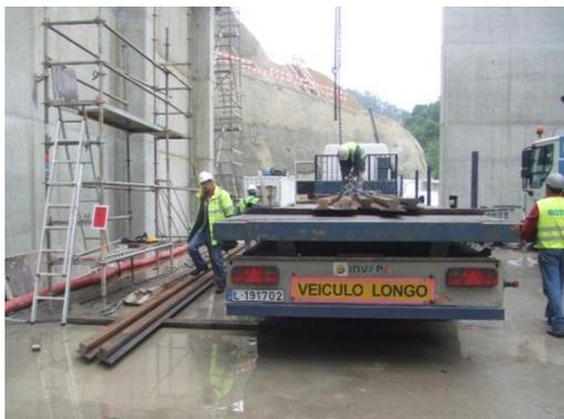
**Figura 5** – Montagem do Caminho de Rolamento da Ponte Rolante (Escalão de Ribeiradio)
