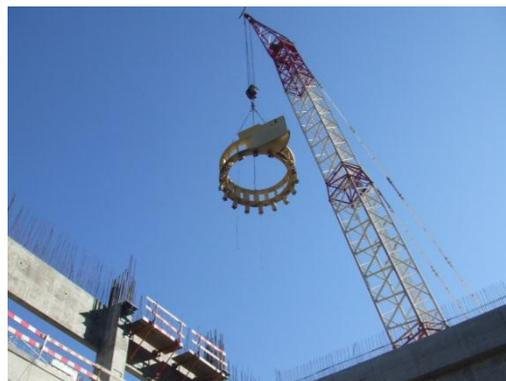
**Figura 2** – Montagem da Caixa Espiral (Escalão de
