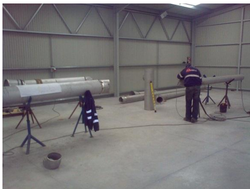
Figura 1 – Trabalhos de Pré-Fabrico em Estaleiro (Escalão de Ribeiradio)
