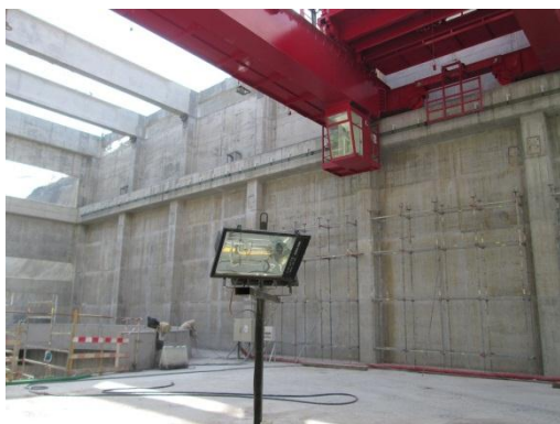
Figura 3 – Montagem da Ponte Rolante (Escalão de Ribeiradio)
