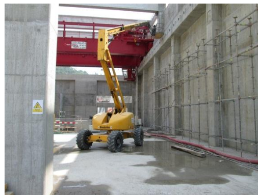
Figura 2 – Montagem da Ponte Rolante (Escalão de Ribeiradio)
