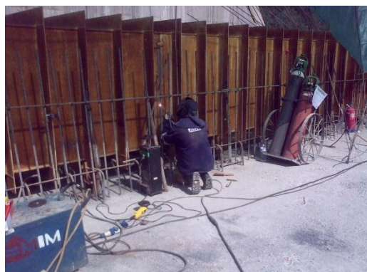
Figura 5 – Montagem da Descarga de Fundo (Escalão de Ermida)
