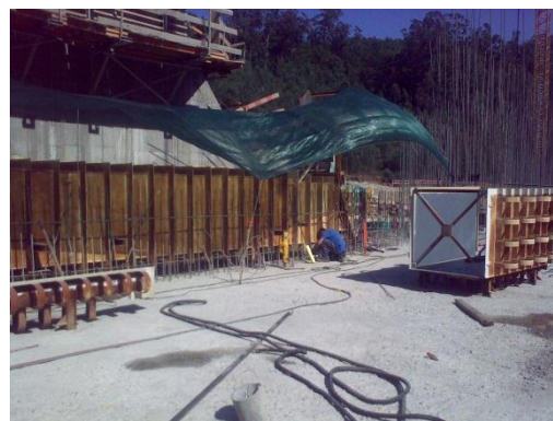
Figura 4 – Montagem da Descarga de Fundo (Escalão de Ermida)
