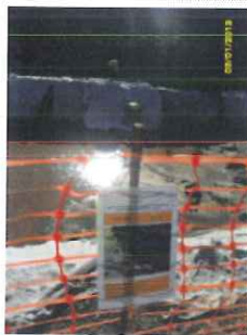
Figura 26 - Identificação de cabouco de secagem de lamas
