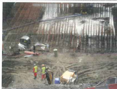
Figura 36 - Colocação de contentores destinados a RSU nas frentes de obra
