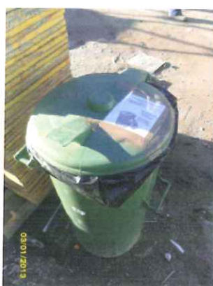
Figura 37 - Contentores de RSU nas frentes de obra
