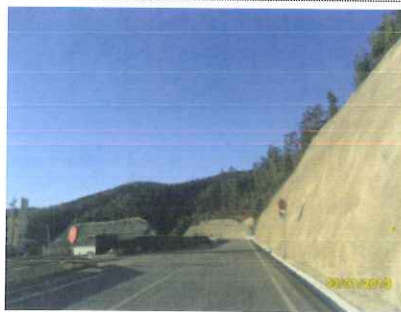
Figura 22 - Limpeza das entradas de obra (Ermida)
