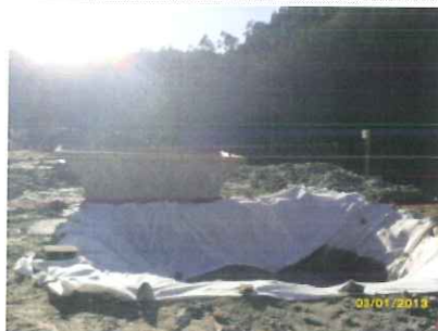
Figura 28 - Colocação de geotêxtil
