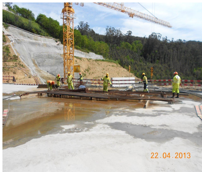
Foto 2.3.6 – Ermida – MD - Estaleiro - Lavagem de Armaduras para Aplicação no Bloco 5.
