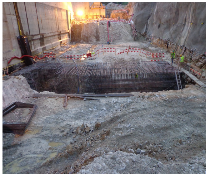
Foto 2.3.2 – Ribeiradio – Trabalhos na Bacia de Dissipação (Falha).
