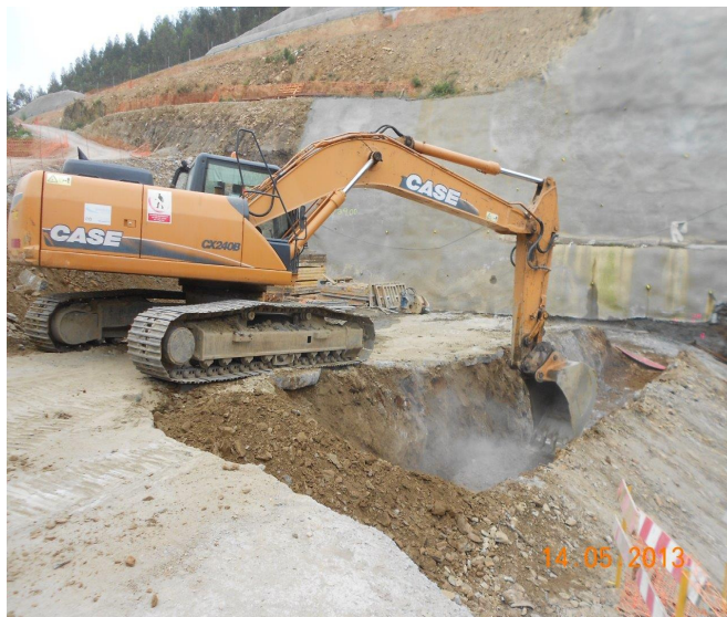
Foto 2.3.18 – Ermida - Restituição – Abertura da Fundação da Recrava.
