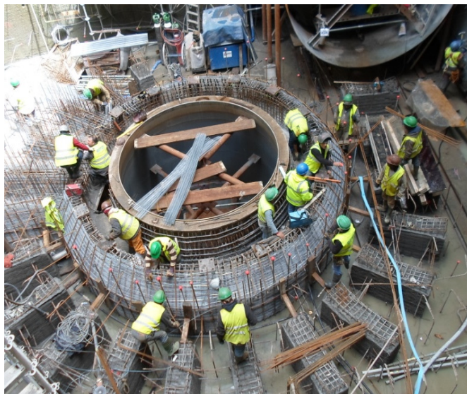
Foto 2.3.17 – Ribeiradio – MD - Poço da Central Hidroelétrica - Posicionamento das Placas para Selagem do Antedistribuidor.
