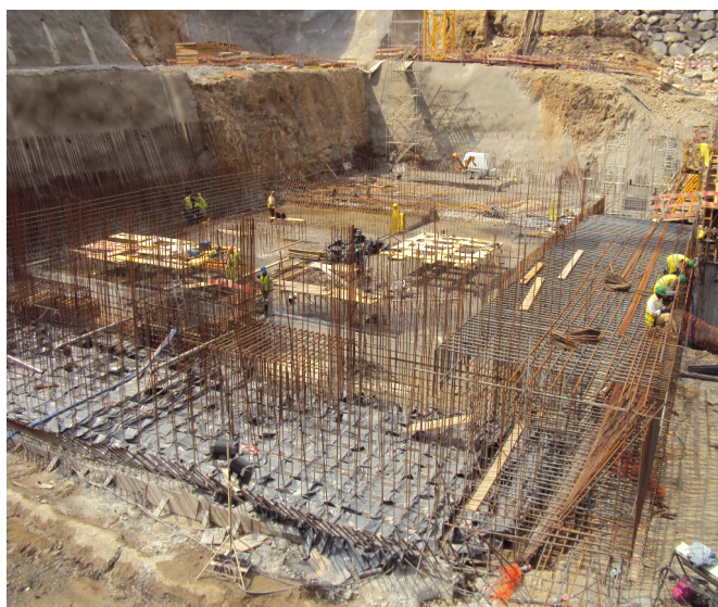
Foto 2.3.11 – Ermida – MD – Trabalhos na Central Hidroelétrica.
