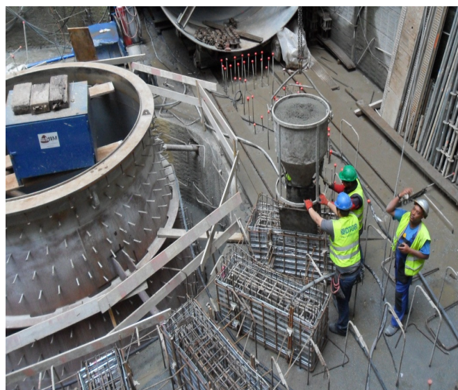
Foto 2.3.4 – Ribeiradio – ME - Central Hidroelétrica - Betonagem dos Plintos.
