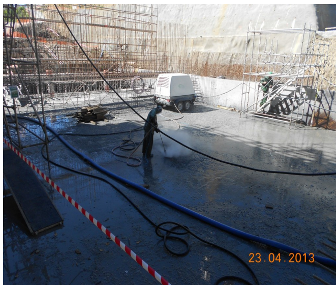
Foto 2.3.9 – Ermida - Barragem - Bloco 5 - Hidrodemolição.
