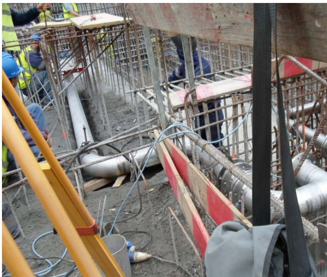
Foto 2.3.13 - Ermida - MD - Central Hidroelétrica - Montagem da Tubagem de Esvaziamento do Circuito Hidráulico.
