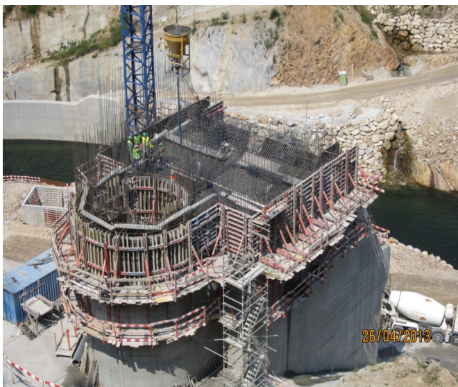
Foto 2.3.1 – Ribeiradio – ME - Tomada de Água - Betonagem do Fuste (Fase 4).
