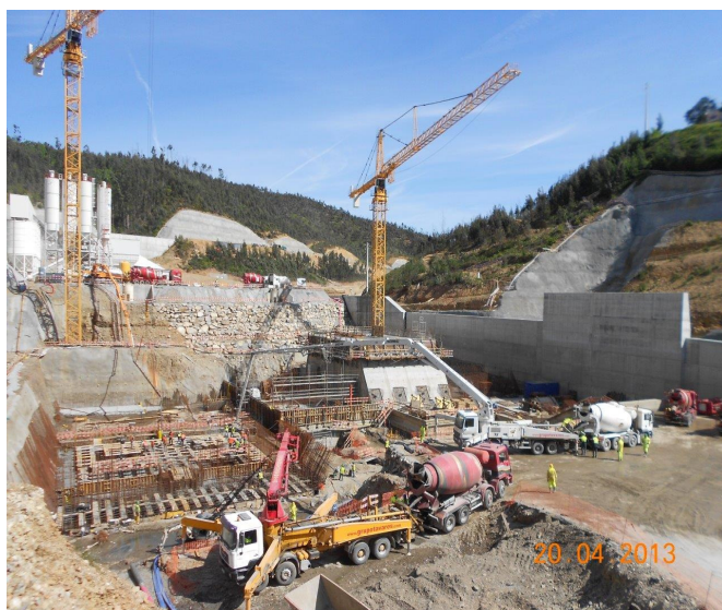
Foto 2.3.7 – Ermida – MD - Central Hidroelétrica - Betonagem da Laje de Fundo.
