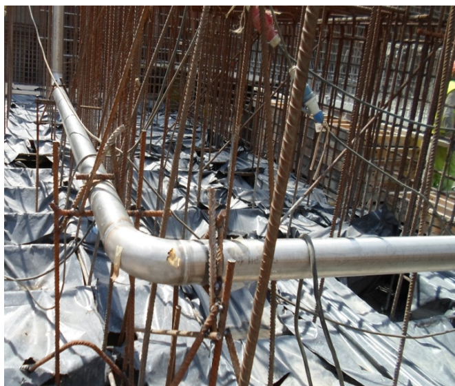
Foto 2.3.5 – Ermida – MD - Central Hidroelétrica - Montagem da Tubagem de Esvaziamento das Conduitas dos Grupos.
