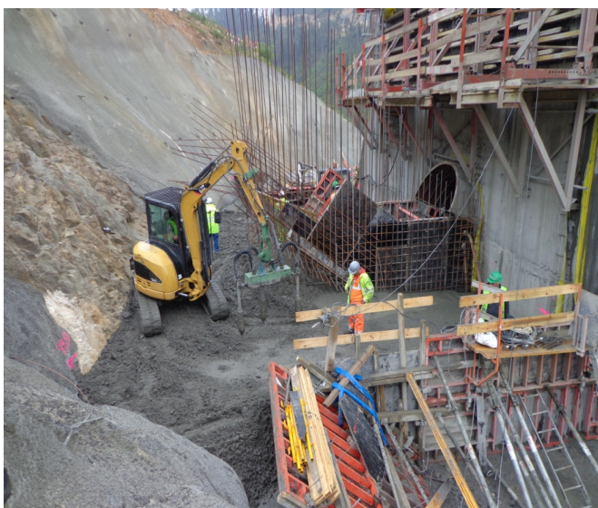
Foto 2.3.15 - Ribeiradio - Barragem - Bloco 14 - Betonagem.
