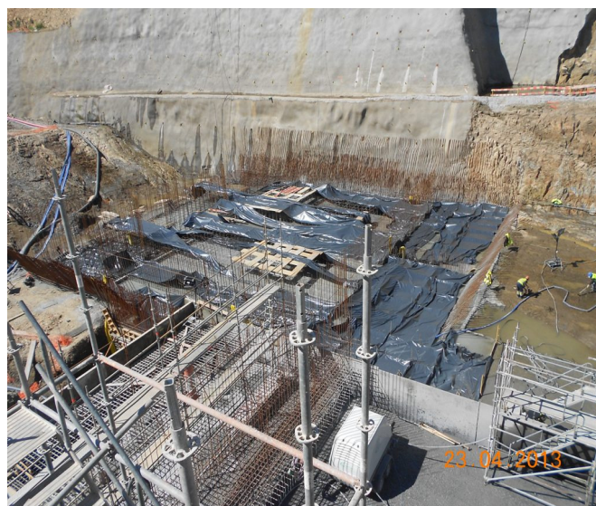
Foto 2.3.8 – Ermida – Retirada de água e material lenhoso da zona de trabalhos.
