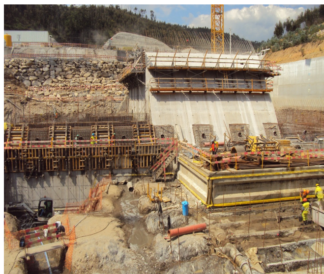
Foto 2.3.12 – Ermida – Trabalhos na Barragem.
