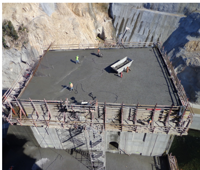
Foto 2.3.3 – Ribeiradio – Betonagem do Bloco 8.
