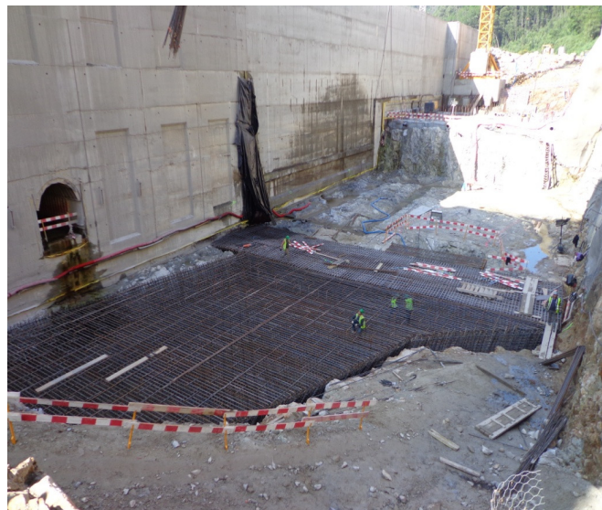
Foto 2.3.14 - Ribeiradio - Barragem - Blocos 6 e 7 - Recrava.
