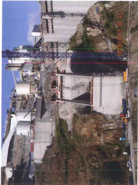
Figura 12 - Tomada de Água
