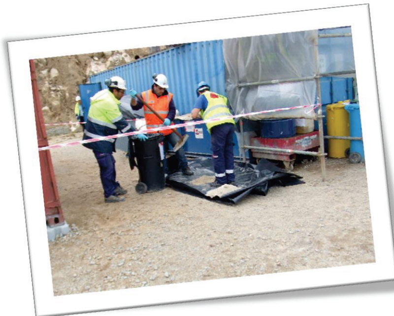
Figura 3 - Recolha dos resíduos para o recipiente devidamente rotulado com a ajuda de três colaboradores.
