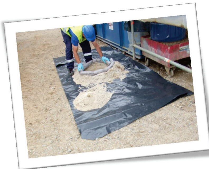
Figura 1 - Detecção do derrame por parte do colaborador. Após colocar os EPI's adequados (luvas), aplica de imediato o produto hidrófugo sobre o gasóleo derramado.
