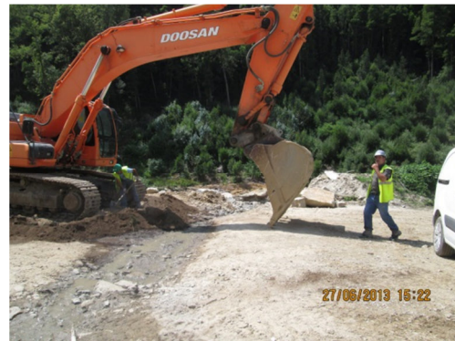
Figura 14 - O encarregado desloca-se ao local afim de verificar o ponto de situação.
