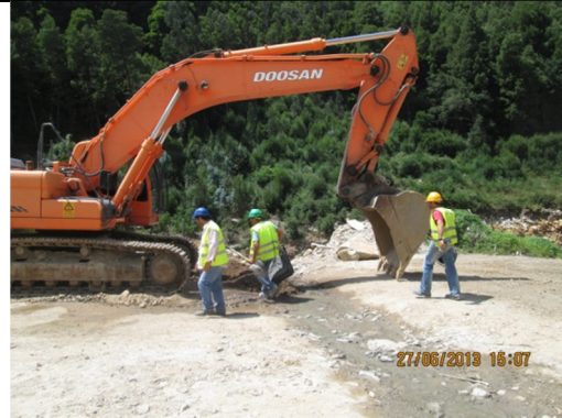
Figura 8 - Colocação de um plástico com as pontas sobreelevadas (presas ao próprio equipamento) por baixo da máquina.
