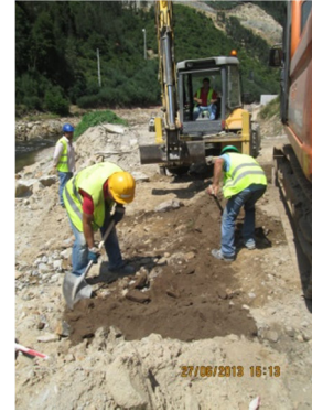
Figura 12 - Limpeza manual do solo contaminado.
