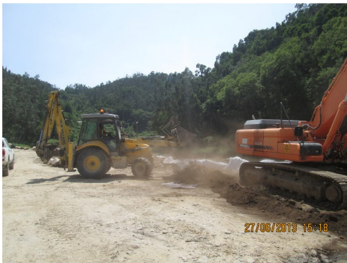
Figura 13 - Colocação de material absorvente em redor da máquina.
