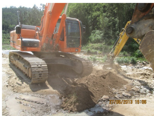
Figura 6 - Contenção junto de uma linha de água afluyente e da margem do rio.
