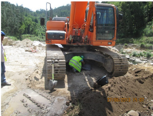
Figura 9 - Colocação de um plástico com as pontas sobreelevadas por baixo da máquina.
