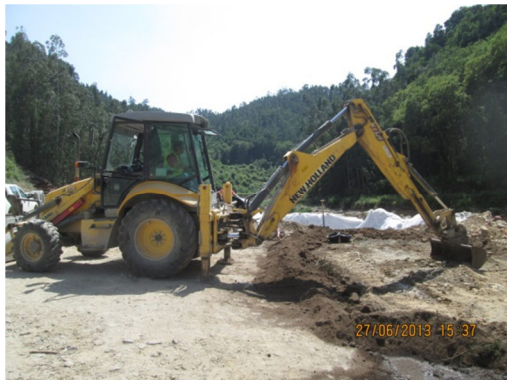
Figura 17 - Saneamento do local contaminado
