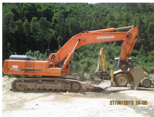
Figura 5 - A retroescavadora chega ao local do sinistro e inicia a contenção.
