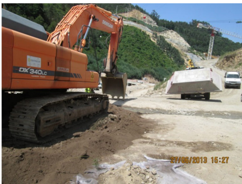
Figura 15 - Contentor para acondicionamento dos solos contaminados
