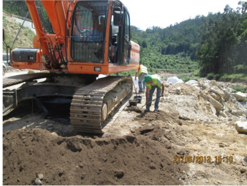
Figura 11 - Início da limpeza manual do solo contaminado.
