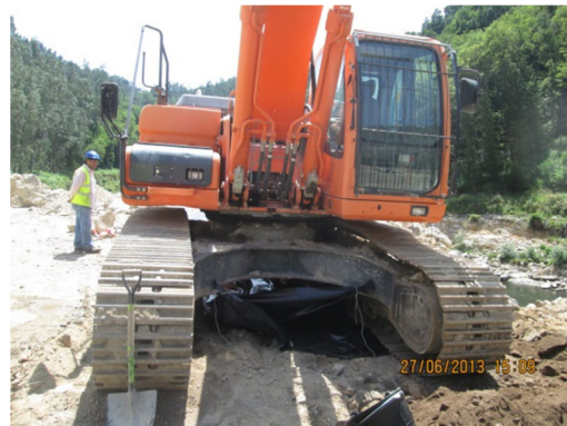
Figura 10 - Plástico com as pontas sobreelevadas por baixo da máquina.
