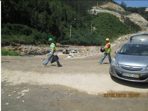
Figura 7 - Chegada da equipa de apoio.
