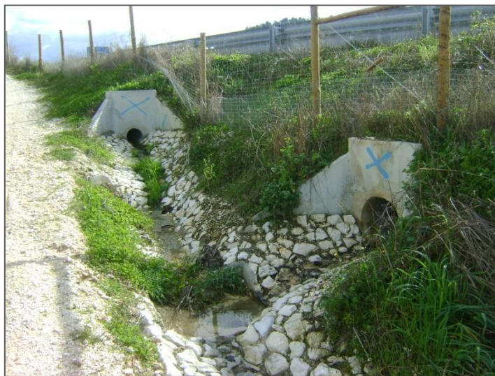
Figura 3.12 – Ponto de descarga das águas de escorrência da via localizado ao km 12+275
