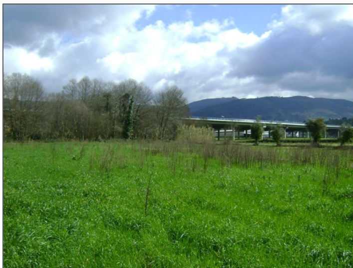
Figura 3.2 – Ponto de recolha de águas superficiais – Viaduto sobre o Rio Cabra – Jusante
