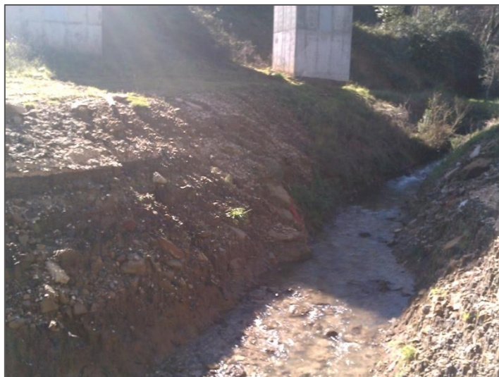
Figura 3.10 – Ponto de recolha de águas superficiais – Viaduto sobre a Ribeira da Flor – Jusante
