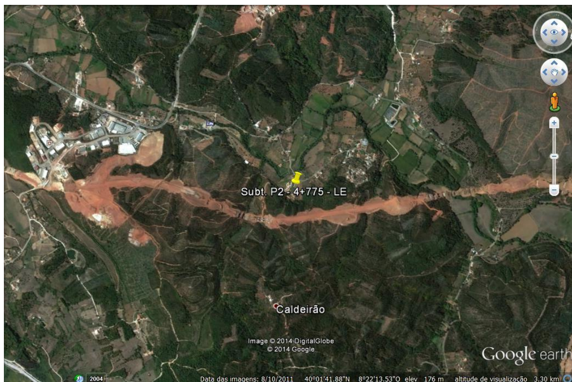
Figura AI.8 – Ponto de recolha das águas subterrâneas Poço ao km 4+775, do lado esquerdo da via.
