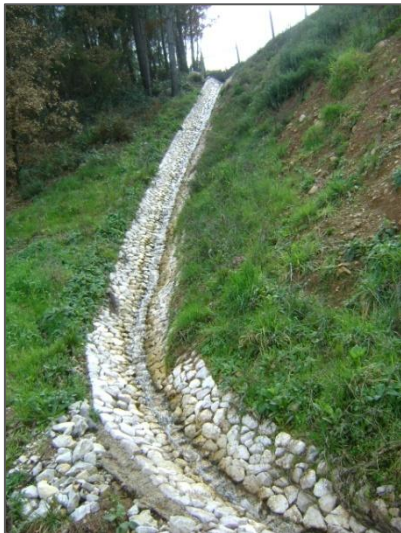
Figura 3.11 – Ponto de descarga das águas de escorrência da via localizado ao km 2+200
