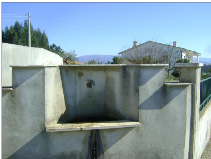
Figura 3.17 – Ponto de recolha de águas subterrâneas P5, ao Km 15+500.
