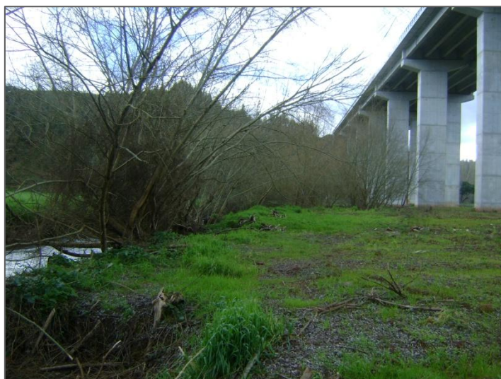
Figura 3.4 – Ponto de recolha de águas superficiais – Viaduto sobre o Rio Corvo – Jusante
