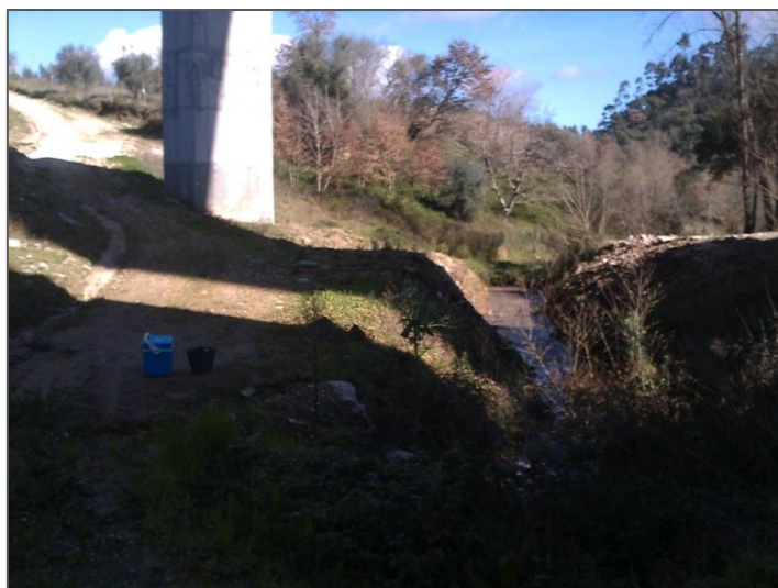
Figura 3.9 – Ponto de recolha de águas superficiais – Viaduto sobre a Ribeira da Flor – Montante
