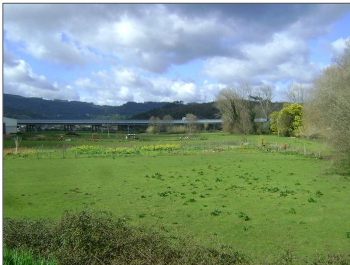
Figura 3.1 – Ponto de recolha de águas superficiais – Viaduto sobre o Rio Cabra – Montante
