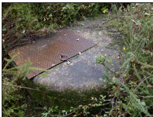
Figura 3.1 – Ponto de recolha P1 – Poço
