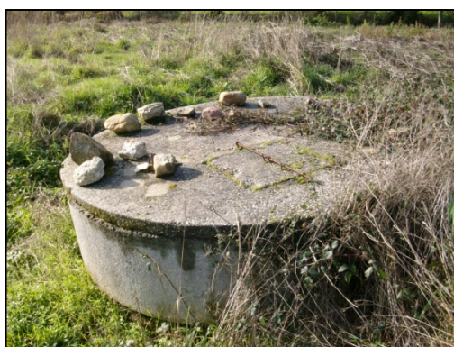
Figura 3.6 – Ponto de recolha P6 – Poço
