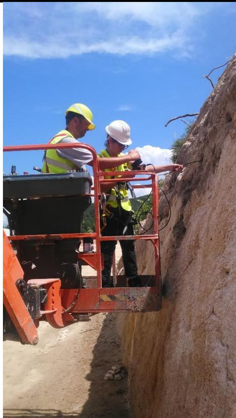
**Figura 4 –** Execução dos trabalhos. Tal como referido o interior dos ninhos foi inspecionado com recurso a uma câmara de endoscopia.
