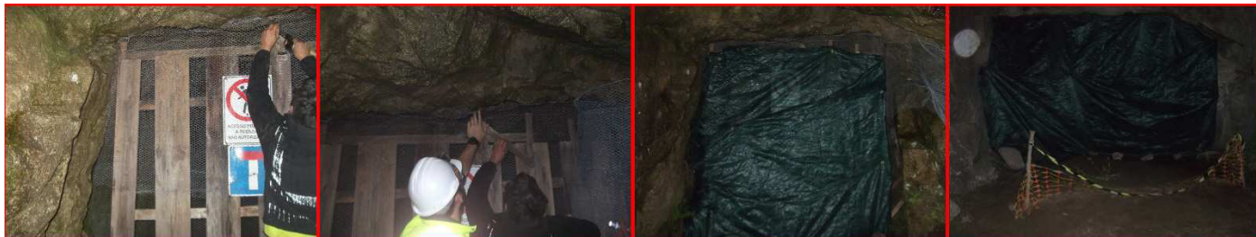
Figura 2: Sequência dos trabalhos de selagem das galerias de sondagem nas margens esquerda e direita de Daivões. Seguindo as Imagens da esquerda para a direita verificamos a colocação da rede de galinheiro seguido da rede de ensombramento.
