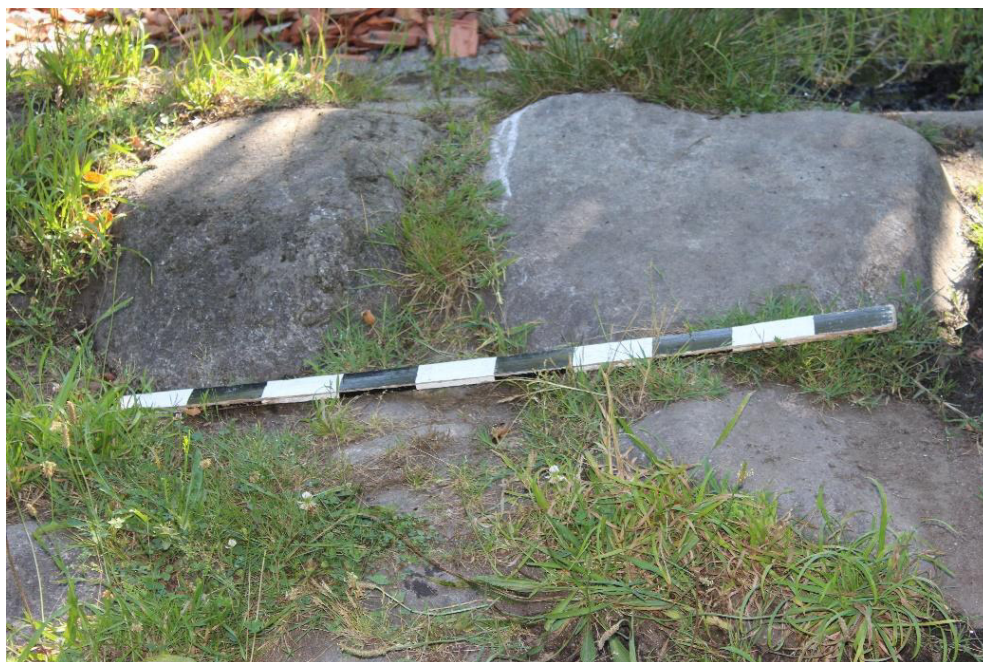
SET| Pormenor de lajeado original.
