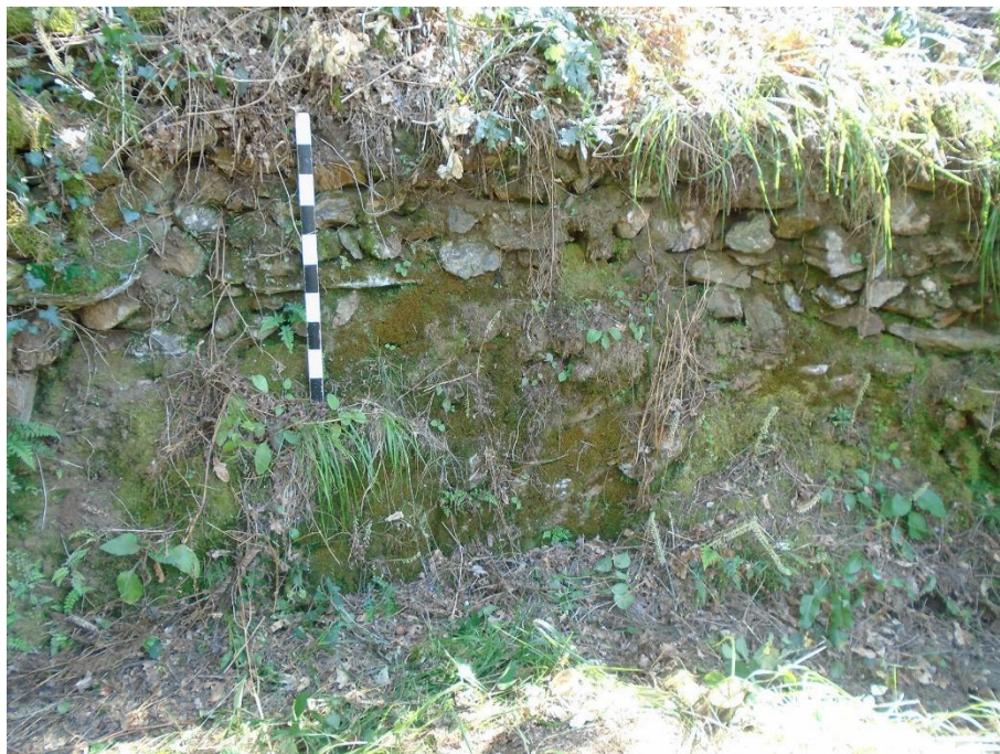
SET| Pormenor de um socalco (nucleo de montante) que aproveita o afloramento na sua construção.
