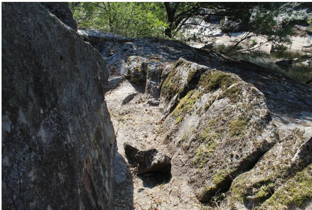
SET| Pormenor de um troço murado.
