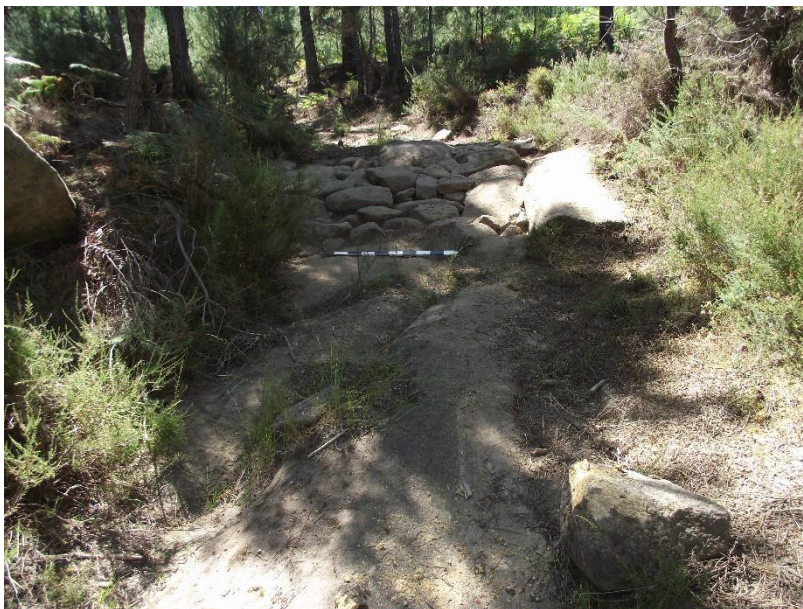
SET| Troço sobre o afloramento granítico afeiçoado, seguido de troço lajeado.
