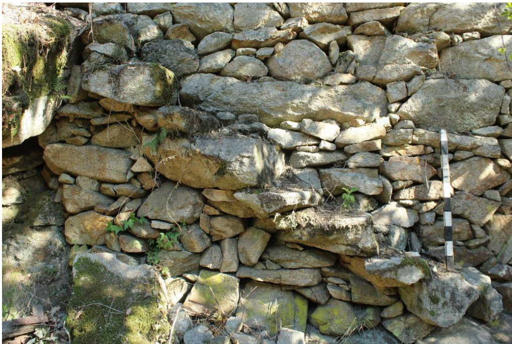
SET| Pormenor das escadas embutidas no Muro 2
