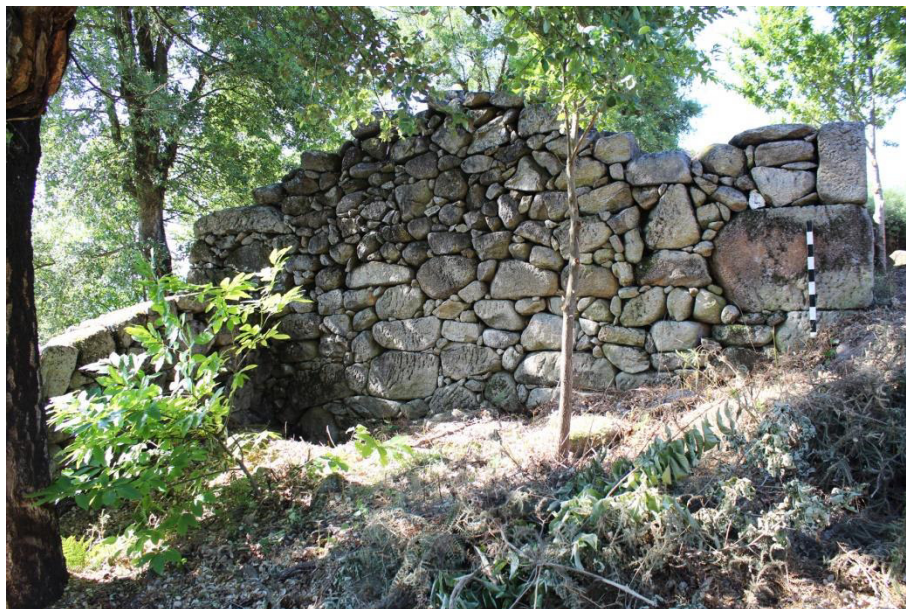
SET| Vista do alçado exterior Sul e muro de divisão de propriedade, vista de Sul.
