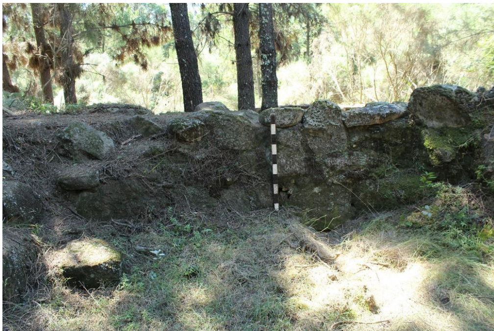
SET| Pormenor do muro de sustentação da água.
