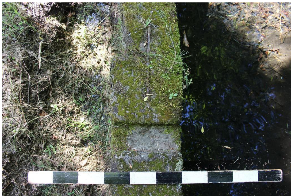
SET| Pormenor de um entalhe para escoamento de água.
