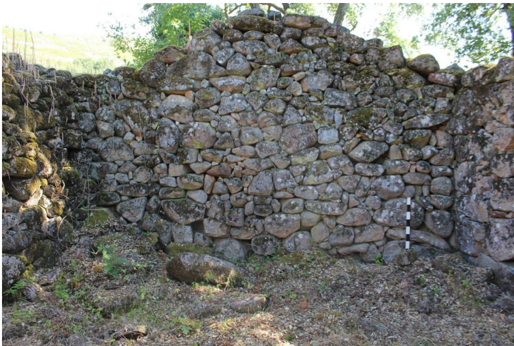
SET| Vista do alçado interior Sul, vista de Norte.
