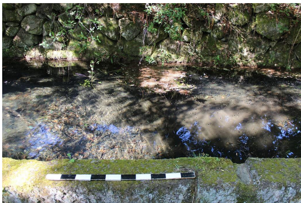
SET| Pormenor do interior do tanque e do socalco que cobre o alçado sul.
