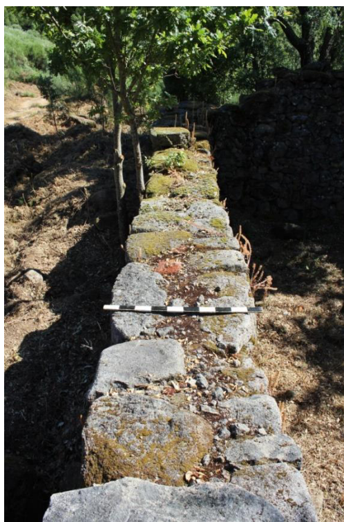
SET| Pormenor do duplo paramento e enchimento do muro do alçado Este, vista de Norte.
