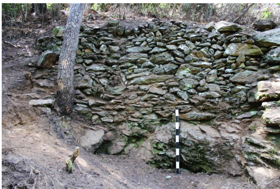
SET| Vista do alçado interior Oeste , vista de Este.
