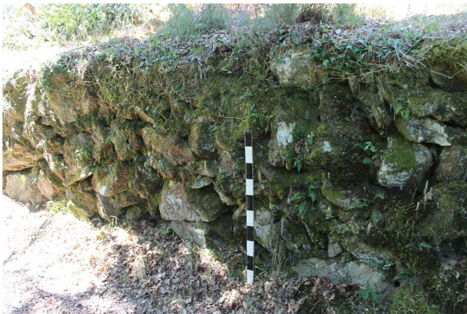
SET| Muro de sustentação de socalco.
