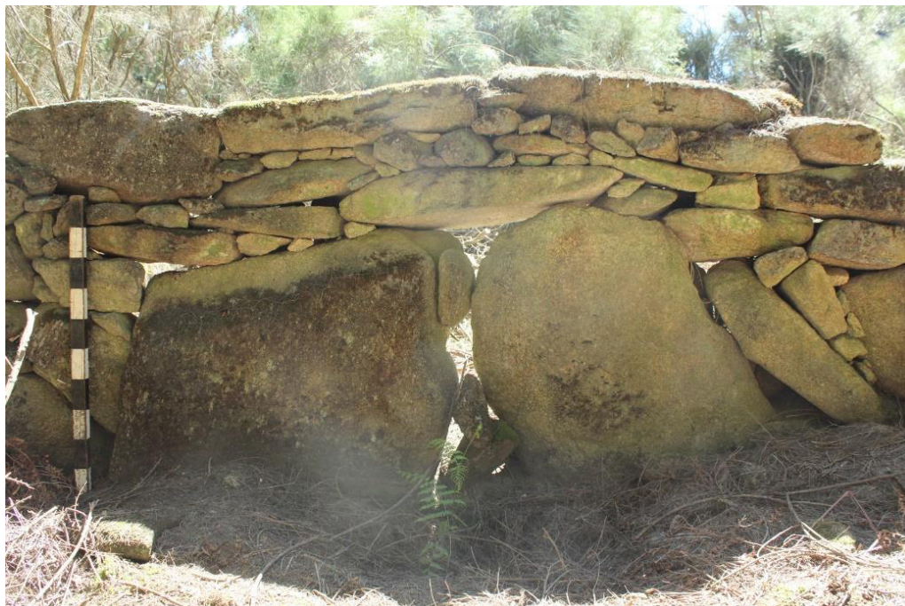
SET| Face externa do muro no troço Este
