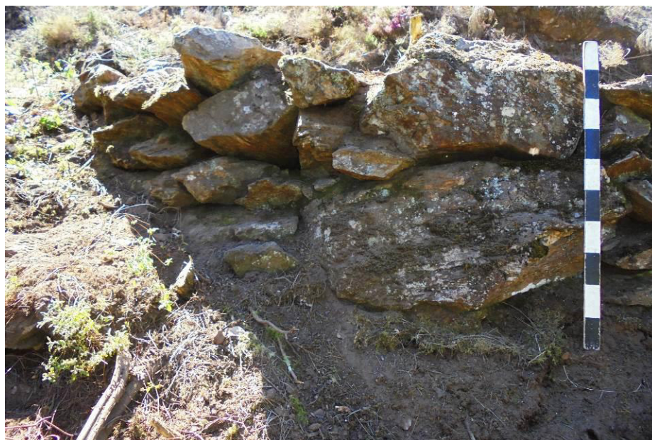
SET - Vista do muro de sustentação do caminho (1º tramo), a partir de este
