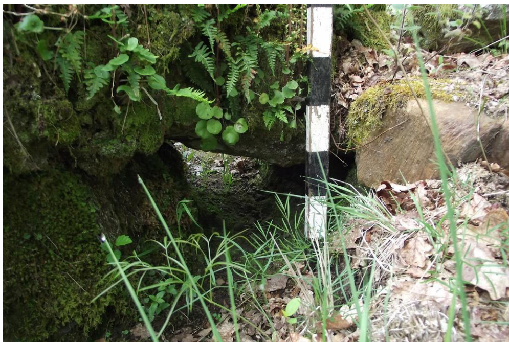
SET| Pormenor da levada sob um muro de propriedade.
