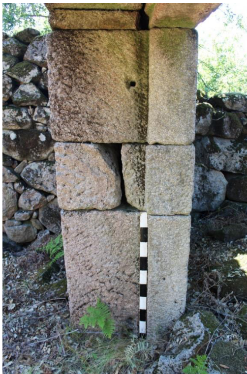
SET| Pormenor da moldura e orifícios de dobradiças da porta no alçado Norte, vista de Este.
