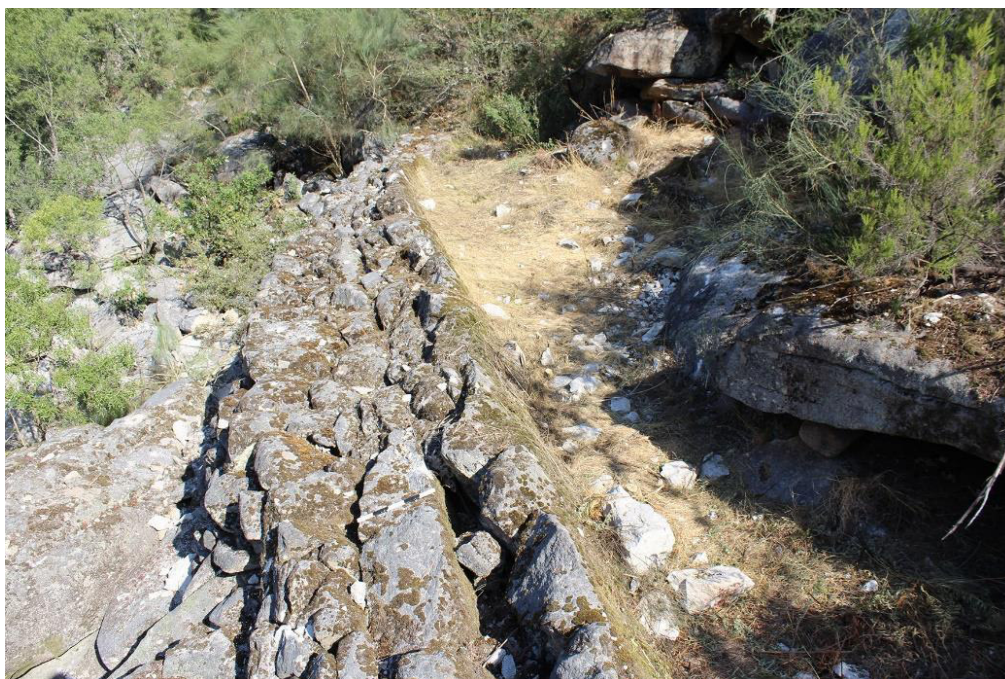
SET| Pormenor de um portentoso muro de sustentação da levada.
