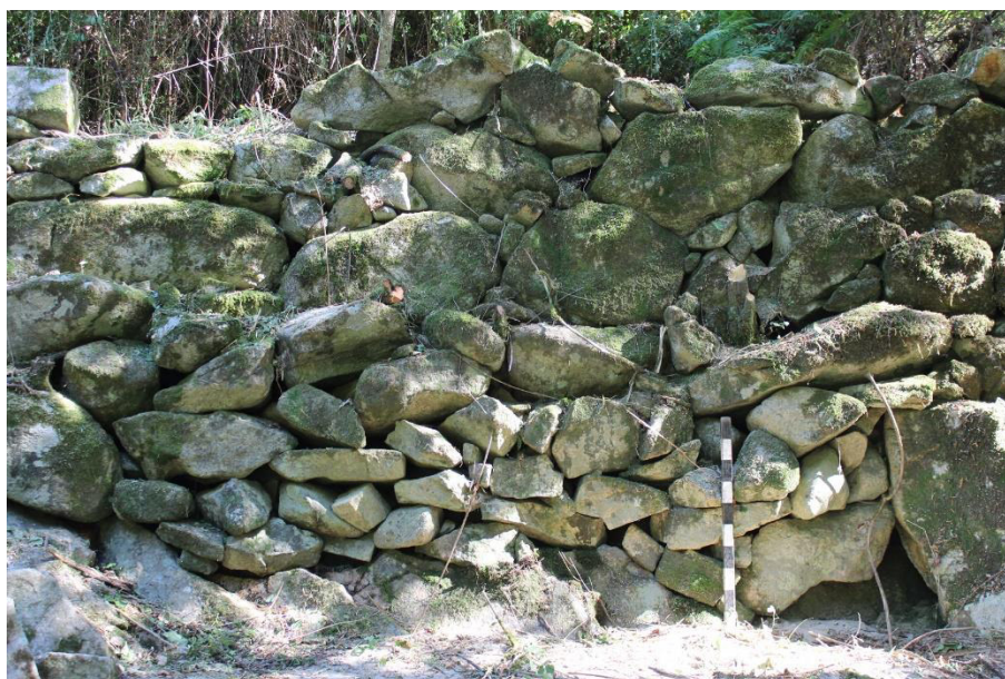
SET| Pormenor do aparelho pétreo do muro de socalco
