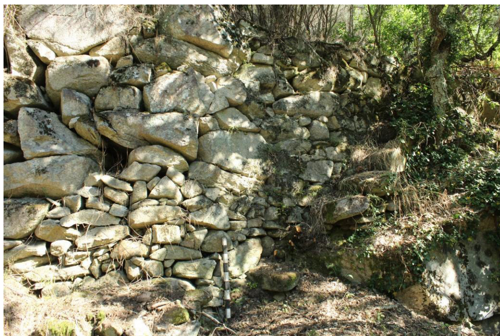
SET| Muro 5. Atente-se às escadas embutidas neste muro
