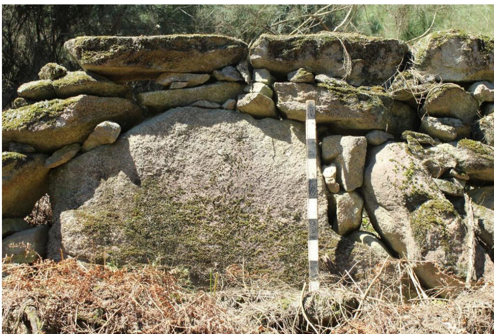
SET| Pormenor da face externa do muro no troço Norte
