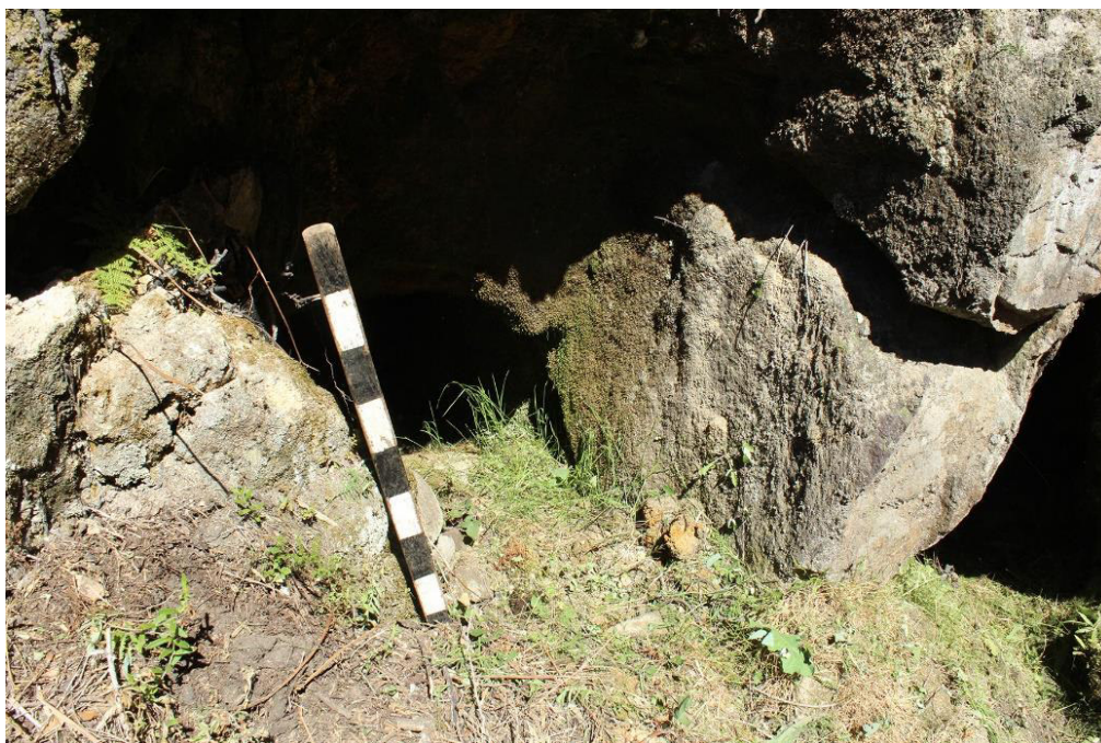
SET| Pormenor da galeria abandonada.
