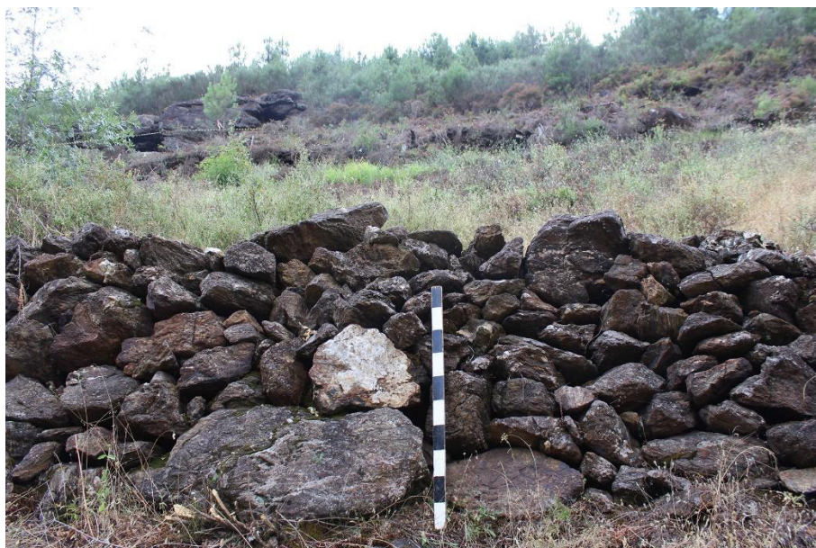
SET| Pormenor de um socalco ( nucleo de jusante).
