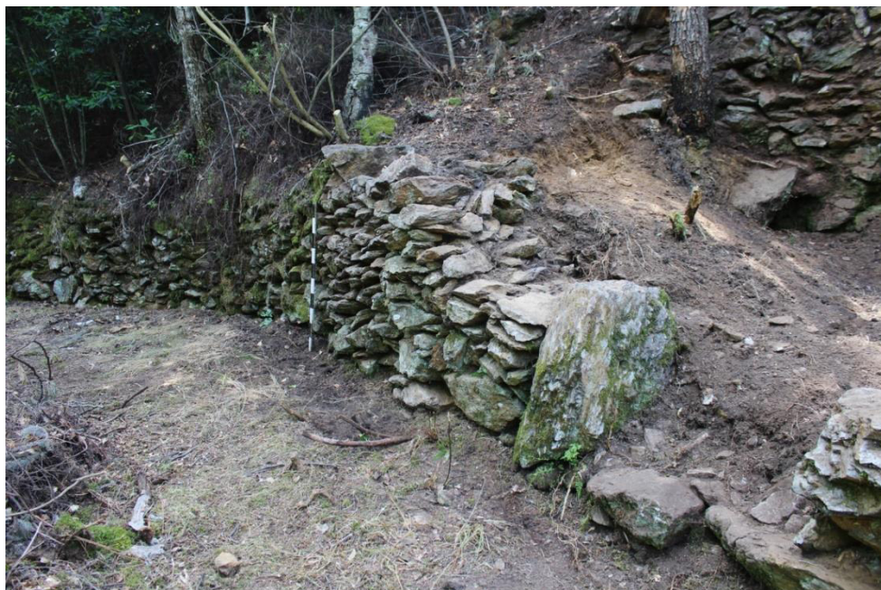
SET| Vista do alçado Este no alinhamento do muro de contenção , vista de Nordeste.
