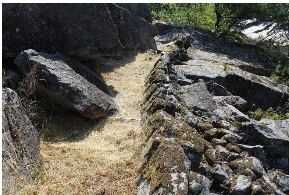
SET| Troço de levada murada, com lajes colocadas de cutelo, em posição oblíqua ao eixo da levada.
