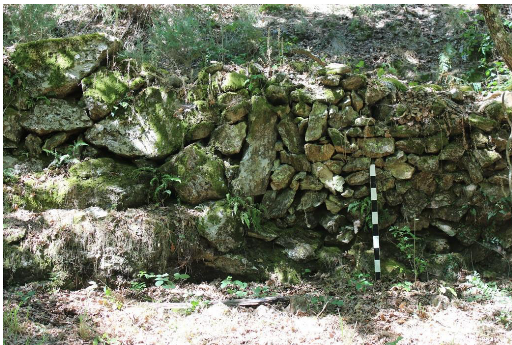
SET| Pormenor do aproveitamento do afloramento na constituição do pano murário.
