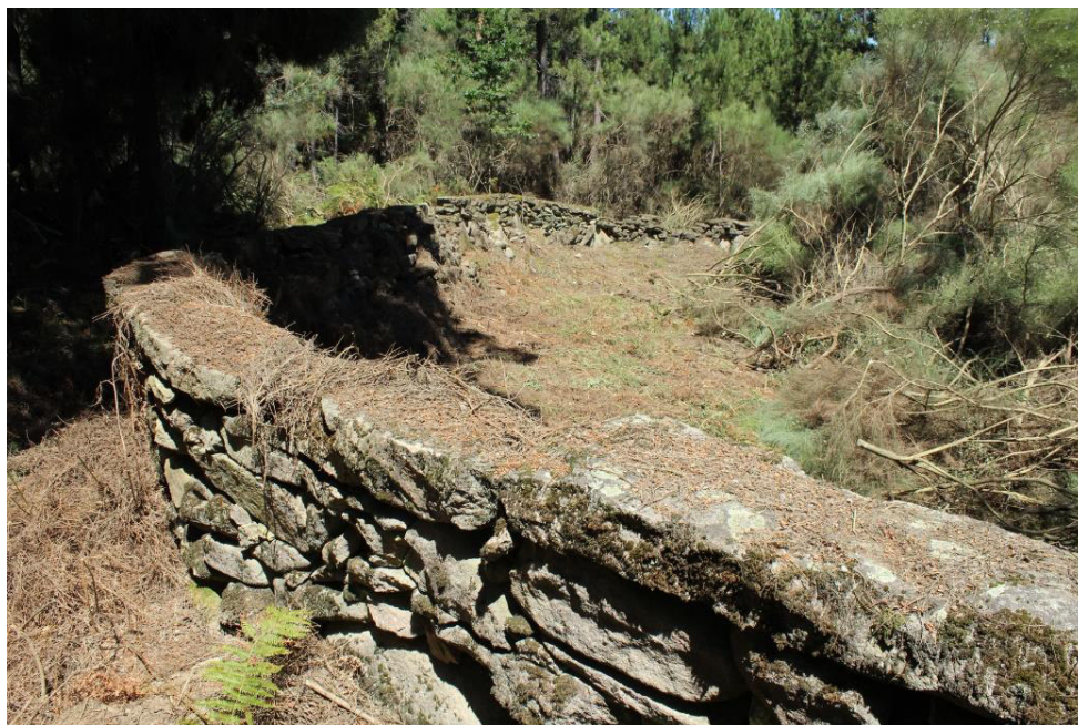
SET| Troço Norte do muro visto de ponte
