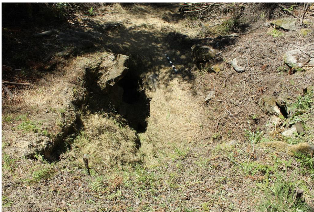
SET| Vista geral da primeira levada que parte de uma mina em direção à represa.
