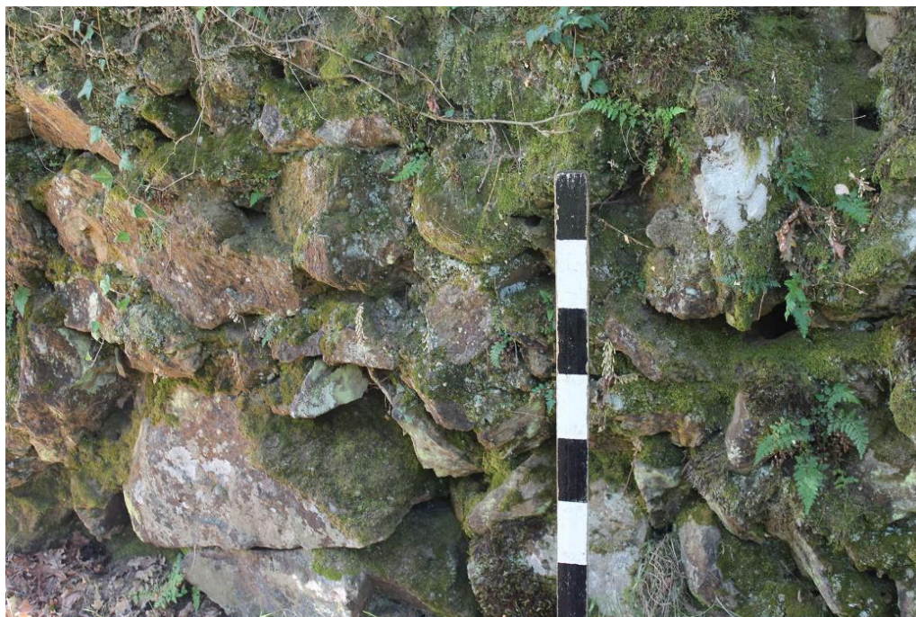
SET| Pormenor do aparelho do muro que suporta o socalco.
