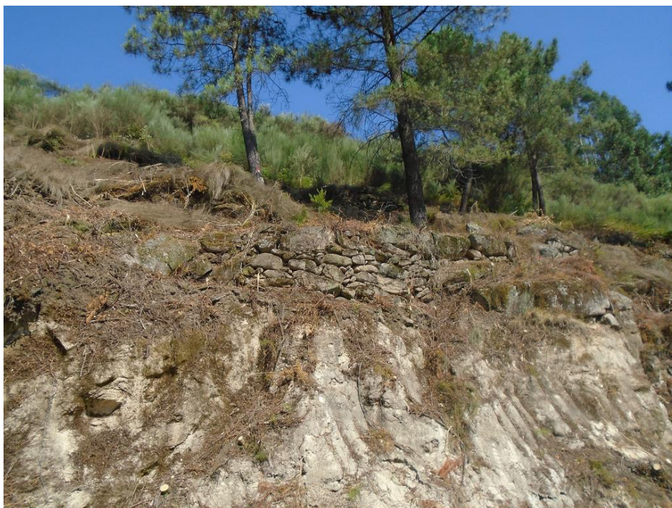
SET Área de encosta com declive mais acentuado.
