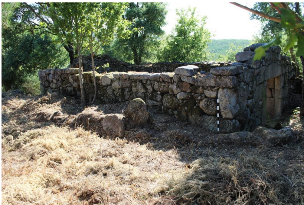
SET| Vista do pano de muro do alçado Este com ênfase na levada, vista de Nordeste.
