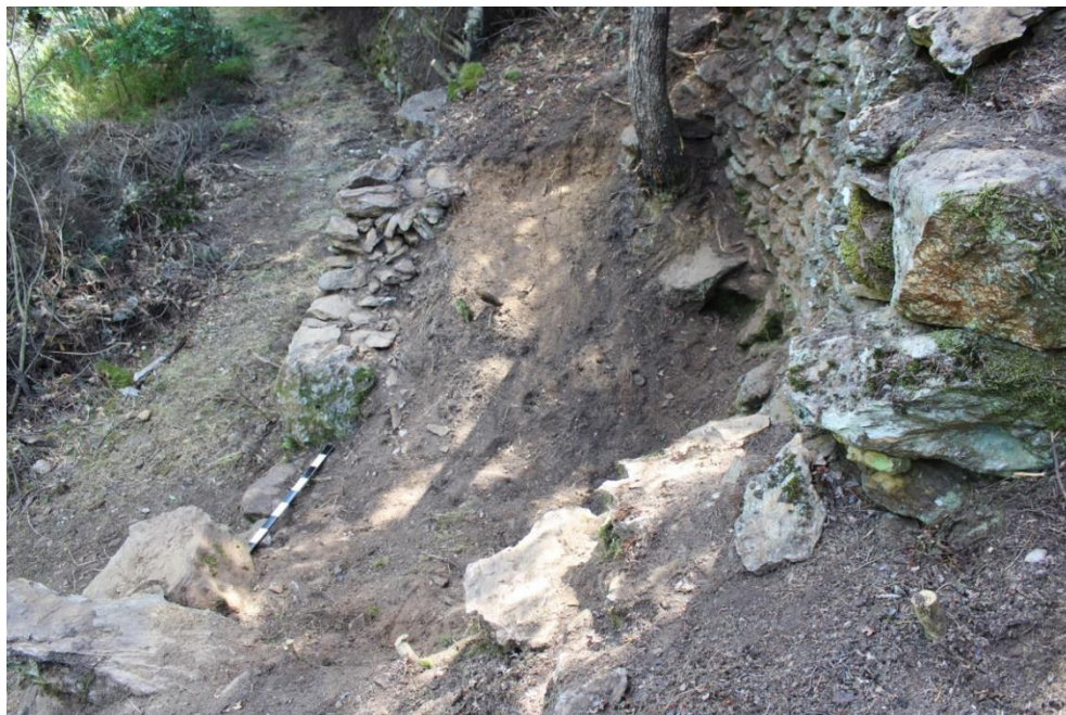
SET| Vista dos alçados Norte e Sul em ruína, vista de Norte.
