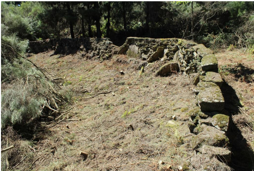
SET| Face interna do troço Norte vista de Nascente
