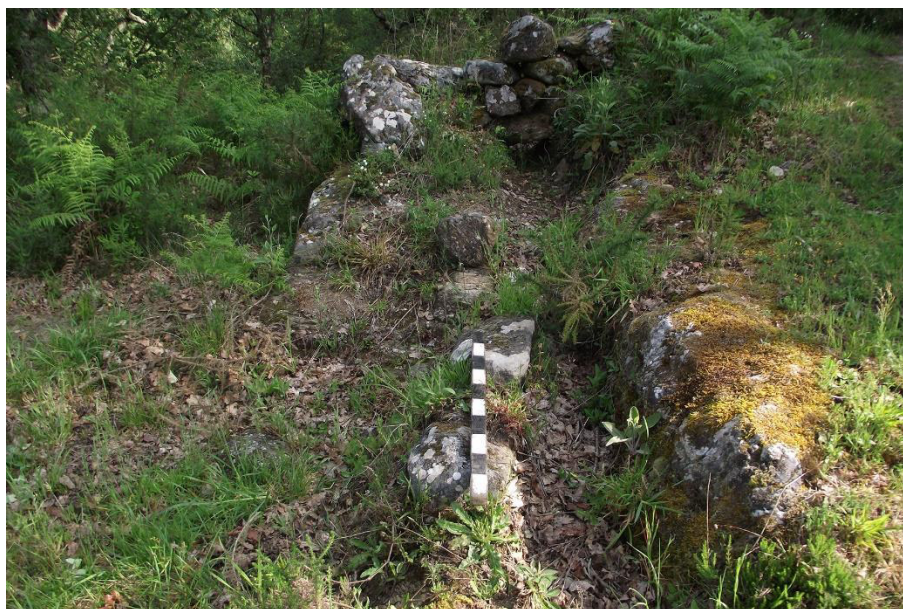
SET| Vista parcial da levada junto ao caminho de Mendreiras.
