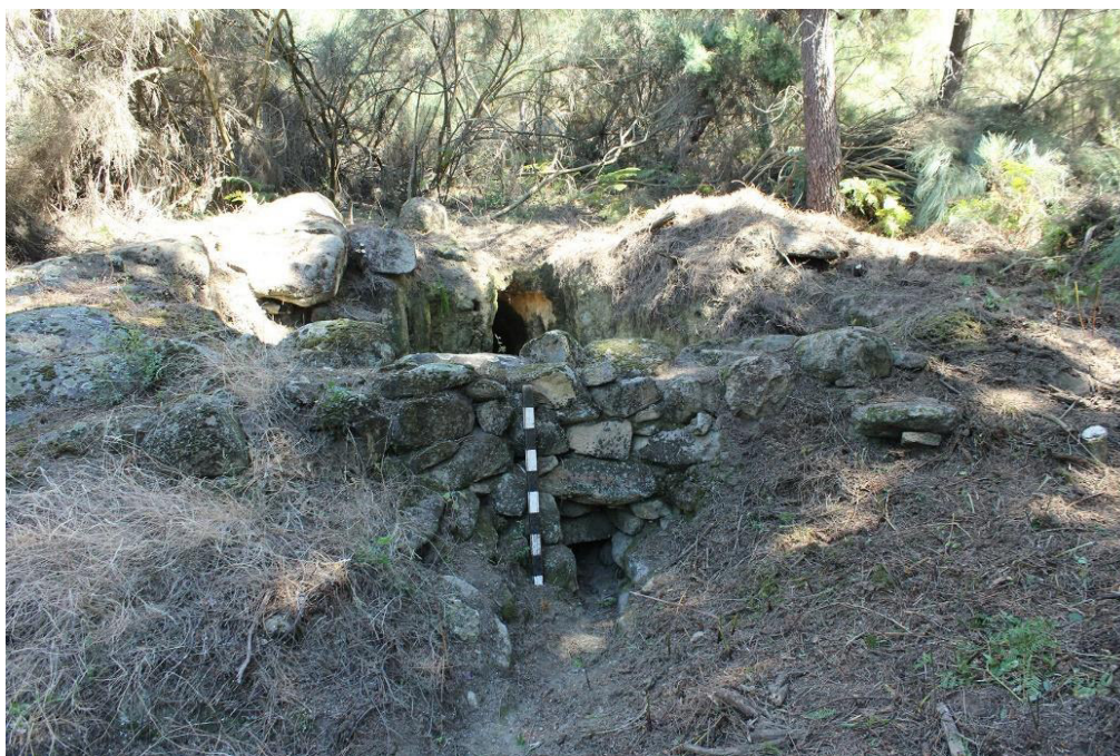
SET| Vista geral da represa.
