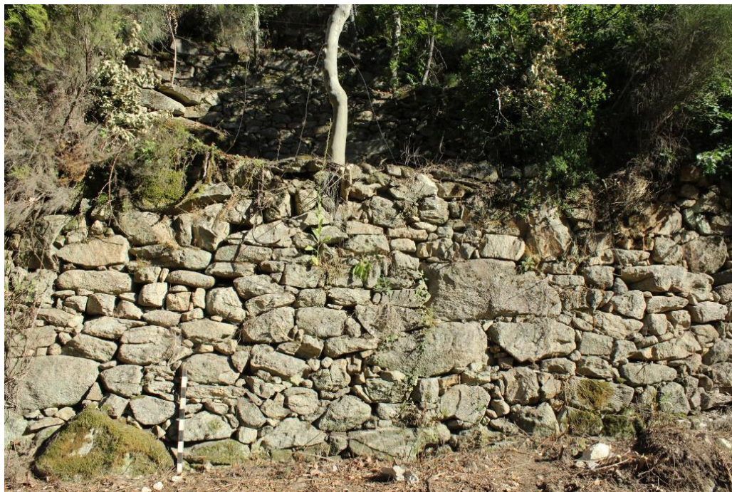
SET| Mancha de socalcos vista de Sul, com o Muro 1 em primeiro plano.
