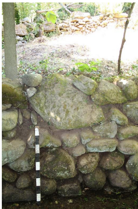
SET| Pormenor da implantação de um socalco.
