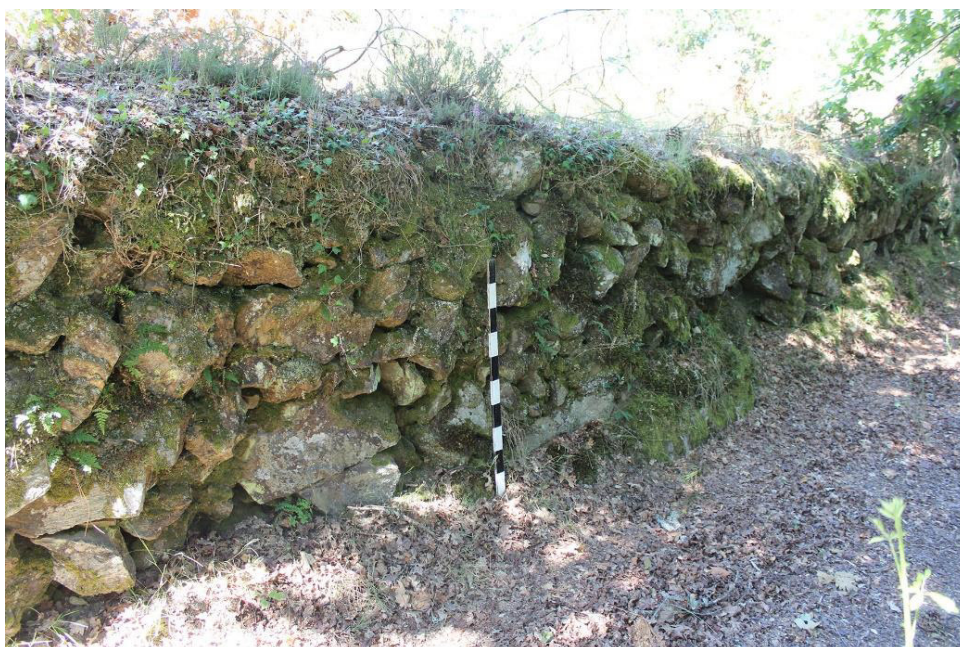
SET| Vista geral de um muro de sustentação de socalco que ladeia o caminho de Mendreiras.
