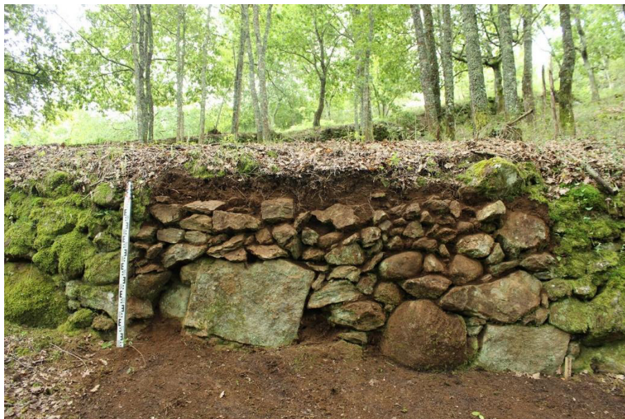
SET| Pormenor de um socalco após limpeza.
