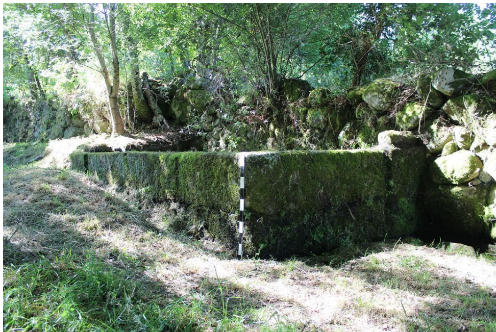
SET| Vista geral do tanque.
