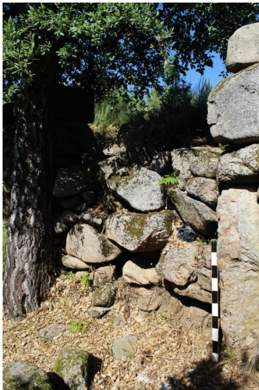
SET| Vista do portão Norte do muro de divisão de propriedade, vista de Sudoeste.
