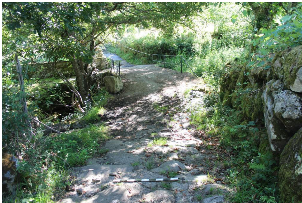
SET| Pormenor do lajeado original junto ao pontão de betão.
