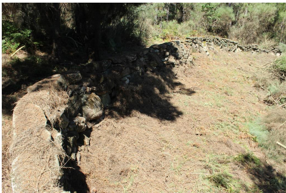
SET| Face interna do troço Norte vista de ponte
