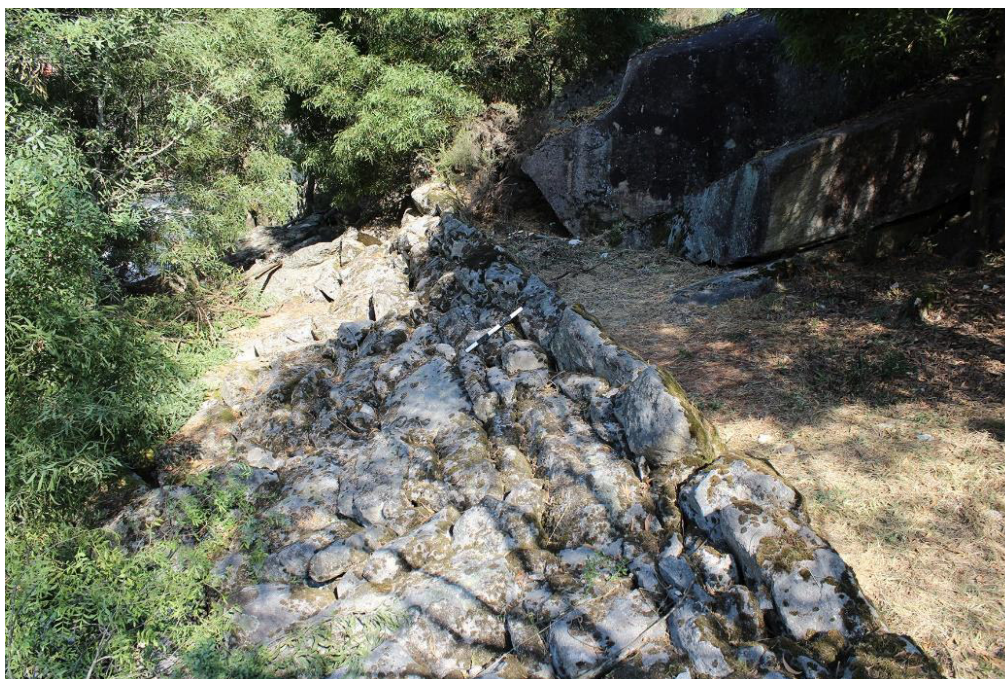
SET| Vista geral de um troço sustentado por um enorme aglomerado de blocos graníticos.
