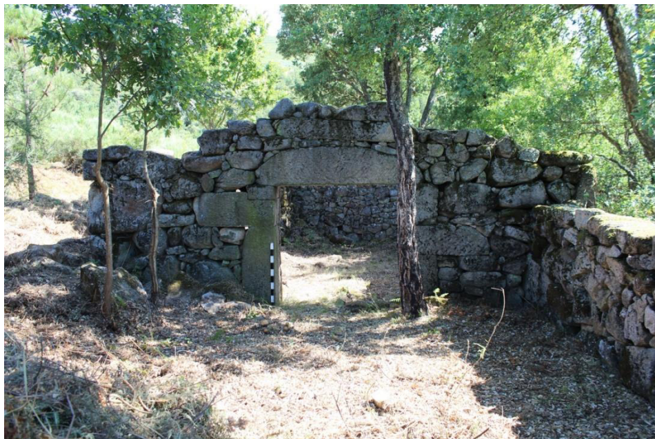
SET| Vista do alçado Norte da estrutura e muro de divisão de propriedade, vista de Norte.
