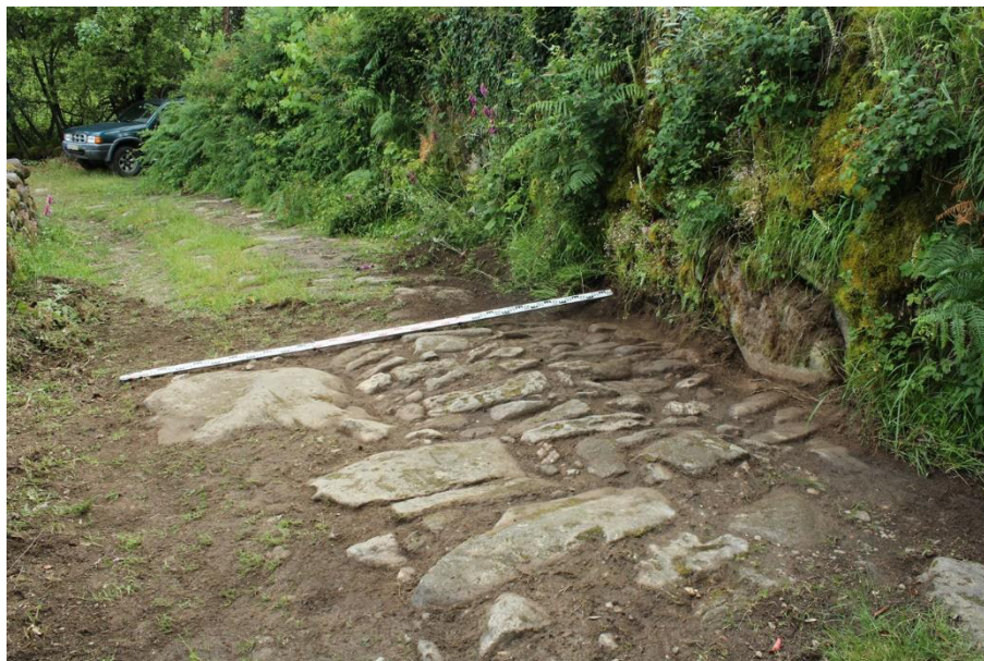
SET| Calçada vista de Sudoeste.
