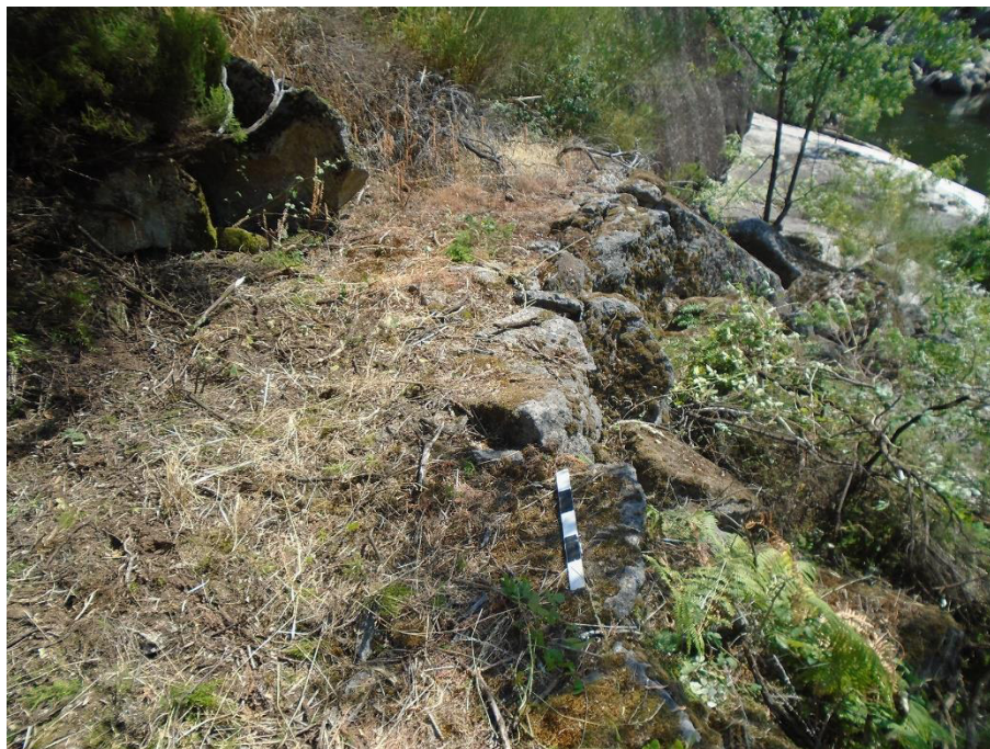
SET| Pormenor do ultimo troço preservado da levada (sentido jusante – montante).
