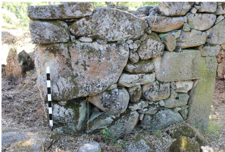
SET| Pormenor da localização do cruciforme no cunhal, vista de Norte.
