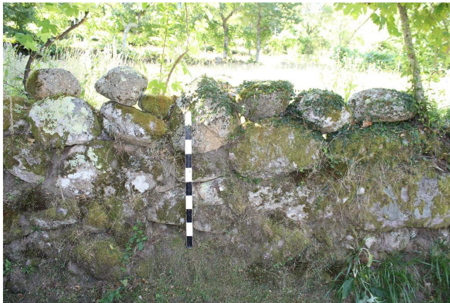
SET| Pormenor de um muro de socalco.
