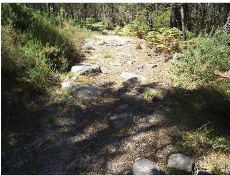
SET| Pormenor de lajeado em razoavel estado de conservação
