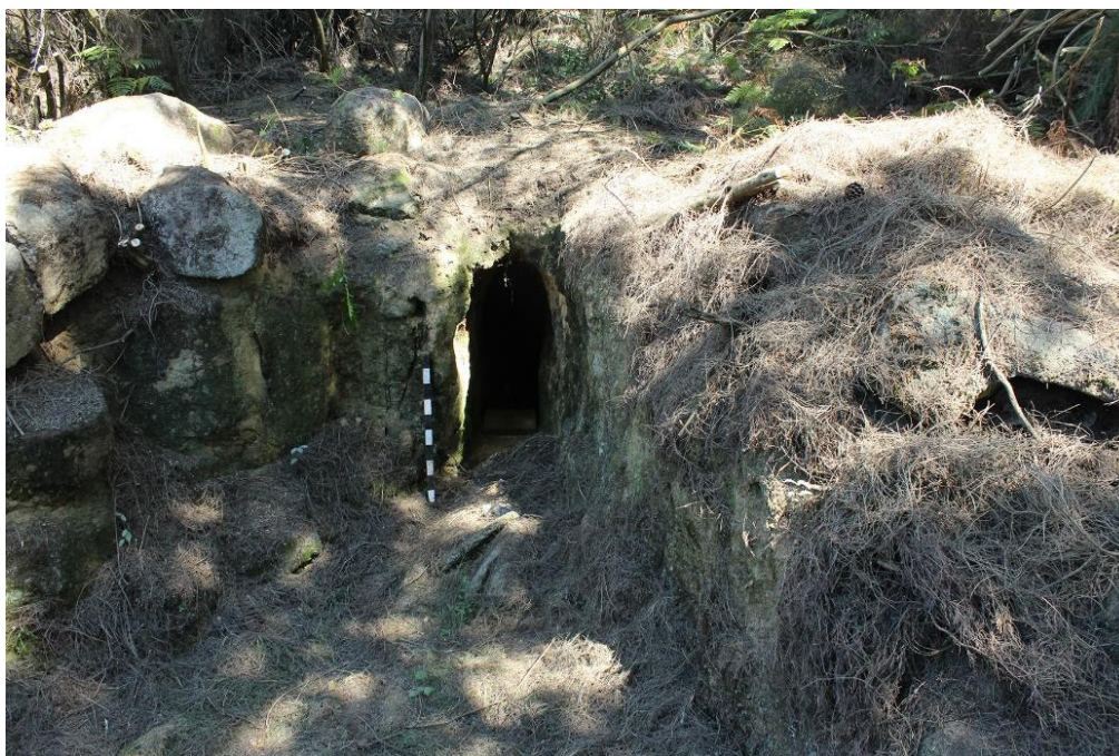
SET| Pormenor da galeria que trasnporta a água das minas até à represa.
