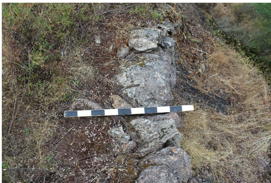
SET| Pormenor do capeamento de um socalco (nucleo de jusante)
