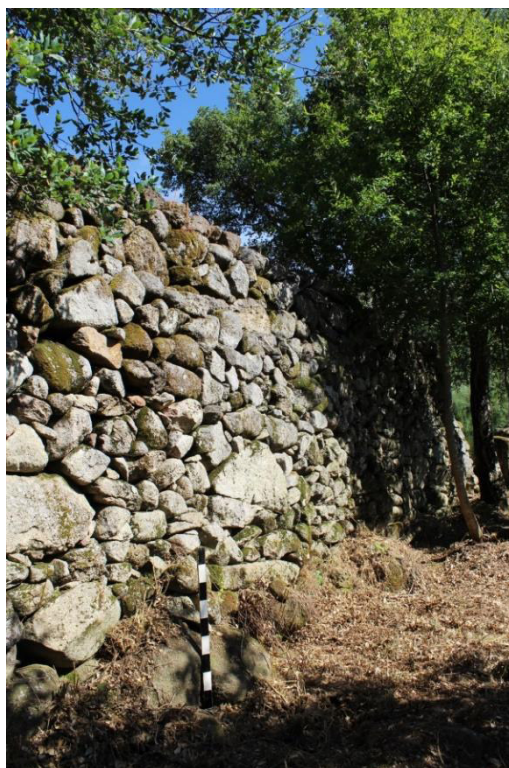
SET| Vista do alçado exterior Oeste, vista de Noroeste.
