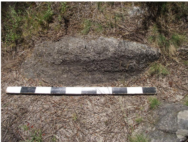
SET| Marca de desgaste de rodado sobre um afloramento granítico constituente da via.
