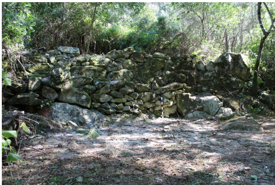
SET| Enquadramento do socalco, próximo da margem direita do rio Tâmega.
