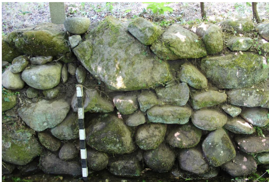
SET| Pormenor da contituição de um socalco.
