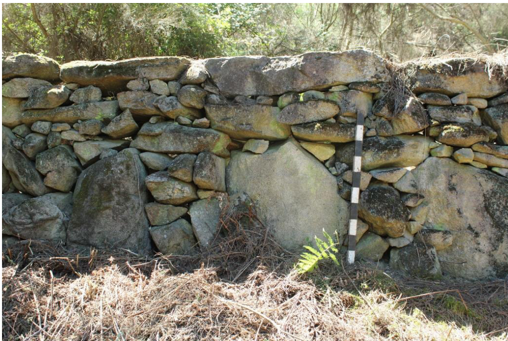
SET| Face externa do muro no troço Oeste
