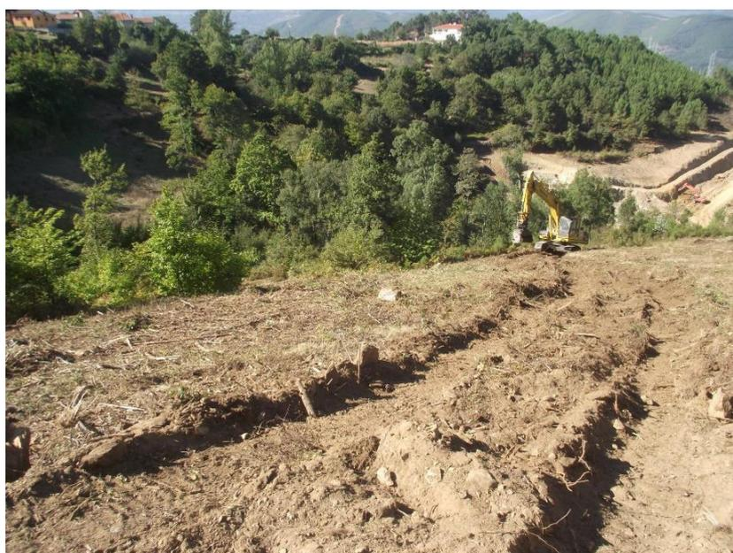
SET| Desmatação com destrojadora na encosta entre a subestação e a estrada nacional.
