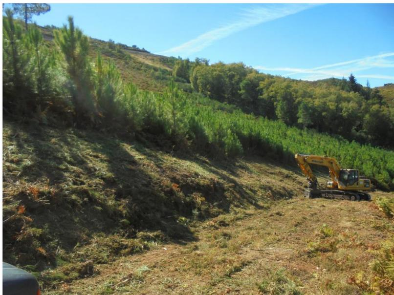
SET| Desmatação efectuada com giratória com trituradora.
