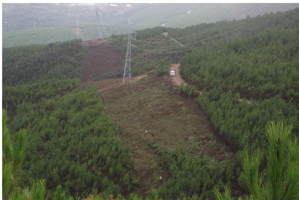
SET| Vista geral da abertura de faixa entre o Vão do Apoio 9 ao Apoio 10.
