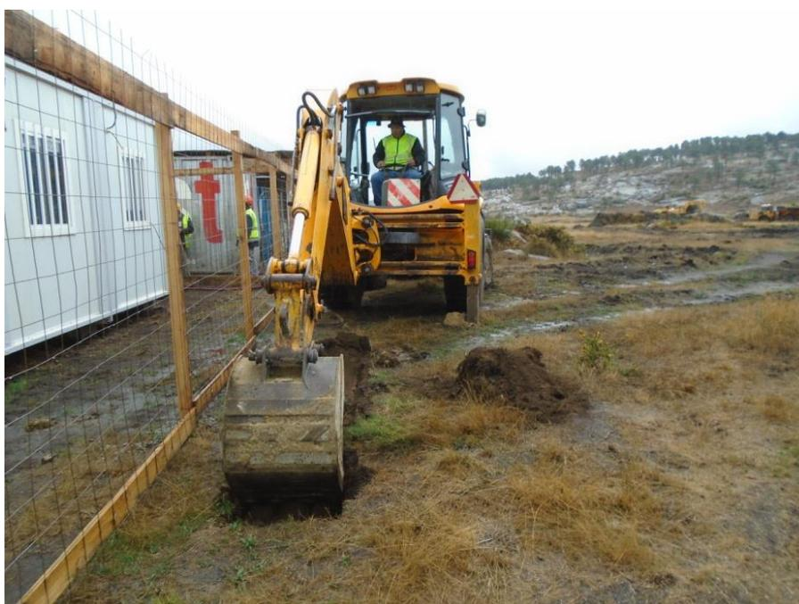
SET| Abertura de vala (8m x 0.50m x 0.40m) para instalação de cabos elétricos de suporte ao estaleiro de obra
