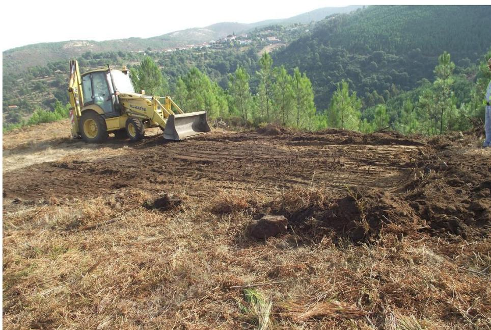
SET| Execução de plataforma no vão do Apoio 14 – Apoio 15
