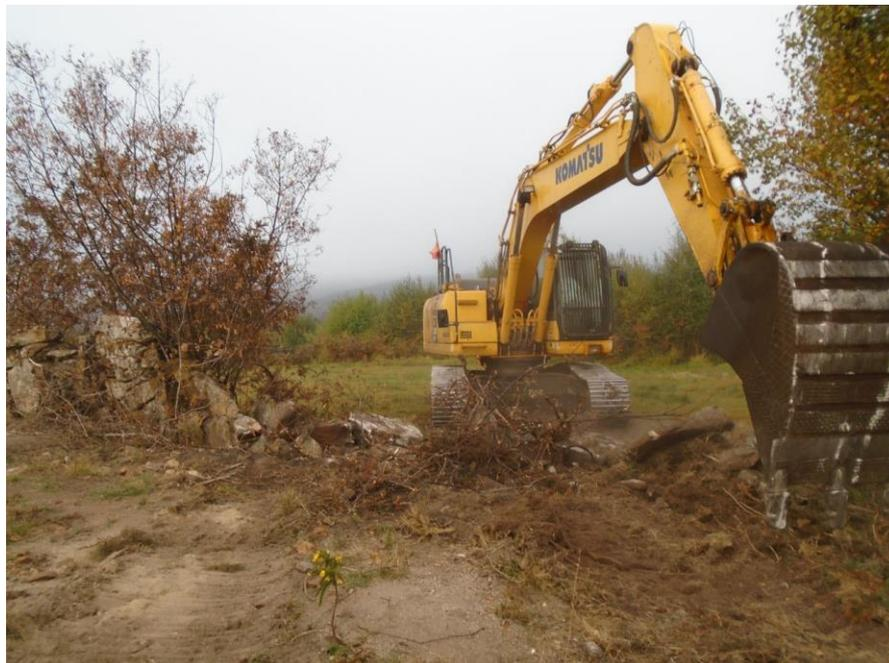
SET| Desconstrução de muro de propriedade no troço do acesso à pedreira (margem esquerda do Rio Torno)
