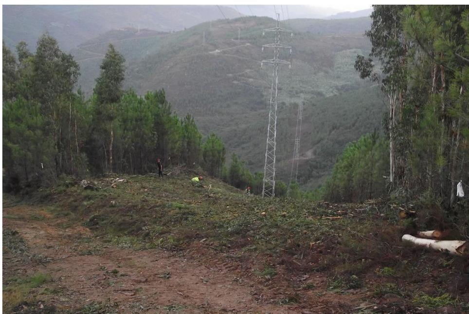
SET| Vista geral dos trabalhos de desmatamento entre o vão do Apoio 14 ao Apoio 15
