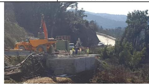
Figura 4 – Limpeza das bacias de decantação da ETAL associada ao ponto de descarga PV1
