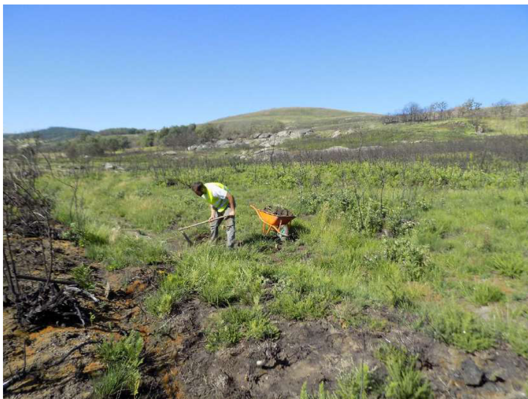
SET_OP455 - Foto 4: Trabalhos de limpeza da vegetação.
