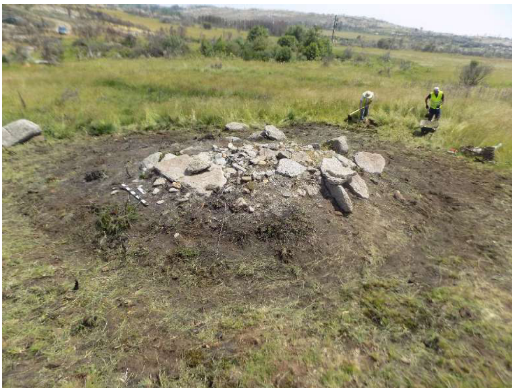
Foto 4: Trabalhos de limpeza da vegetação
