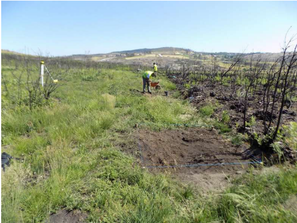
SET_OP455 - Foto 5: Limpeza do terreno, marcação de sondagens e levantamento topográfico.
