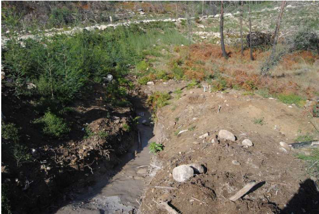
Foto 3 – Aspecto da vala e da área de implantação da sondagem, vista de S.
