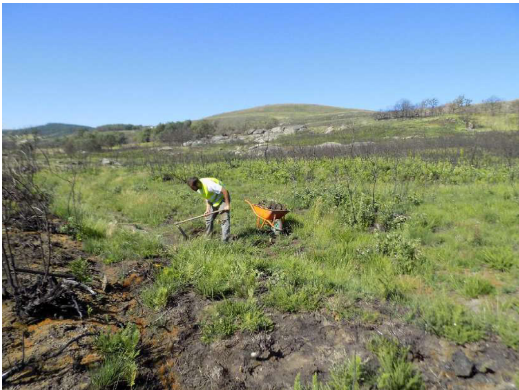
SET_OP455 - Foto 4: Trabalhos de limpeza da vegetação.
