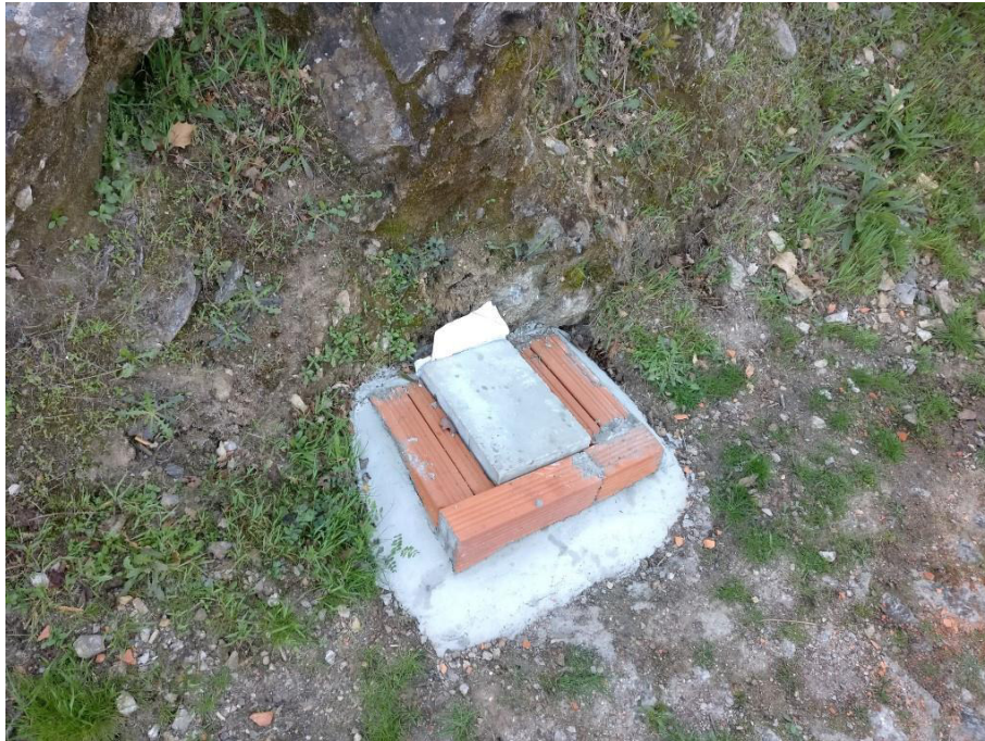
Figura 1 – Caixa estanque do SCIG-15 (março de 2017).
