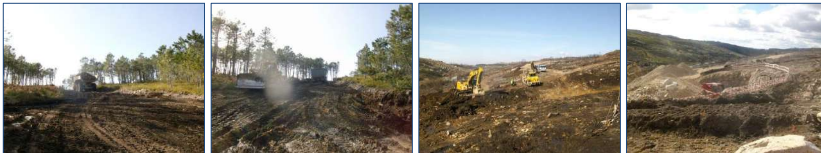
Acesso B13 e Boca de Tomada
