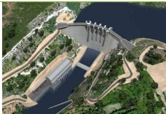
Figura 2: Barragem de Daivões
