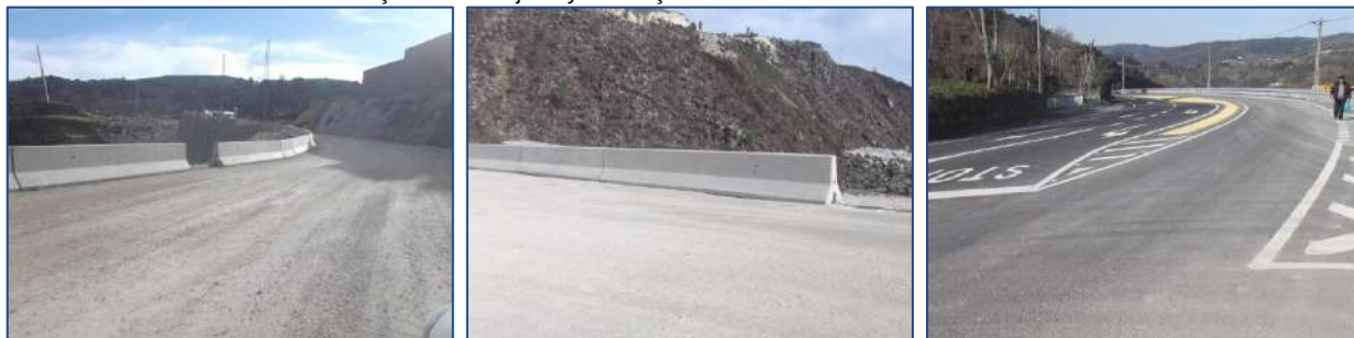
Colocação dos new jersey colocação de marcadores refletivos na EN 206
