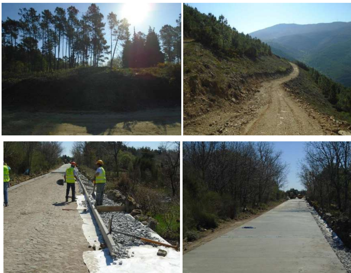
Figura 19: Evolução das obras na variante de Seirós e requalificação da estrada Pensalvos/Cabanes
