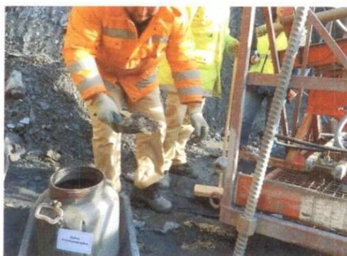
**Figura 5.** Colocação do solo contaminado no bidão de solos contaminados
