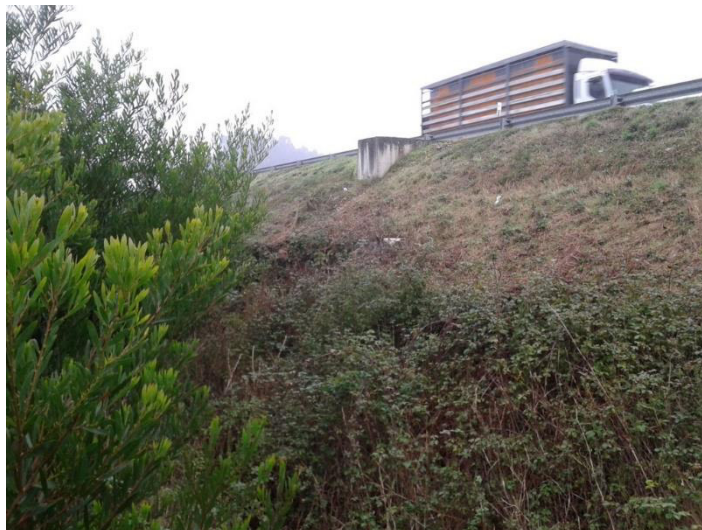
Figura 2 – S1M - Linha de água restituída pela PH 4.1, a montante da via.
