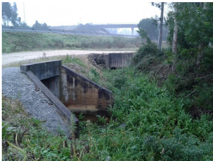
Figura 3 – S1J - Linha de água restituída pela PH 4.1, a jusante da via
