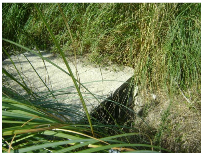
Figura 5 – S2J – Linha de água restituída pela PH 16.5, a jusante da via.
