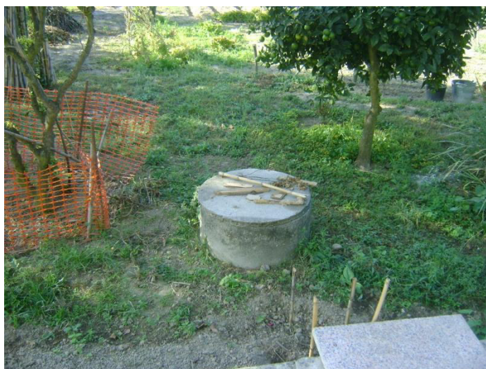
Figura 11 – P5 – Poço localizado ao km 1+440, a cerca de 12m da via.
