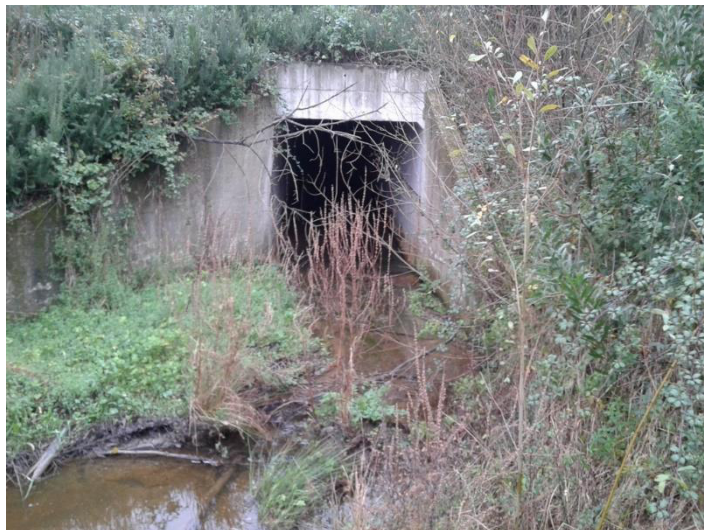
Figura 4 – S2M – Linha de água restituída pela PH 16.5, a montante da via.
