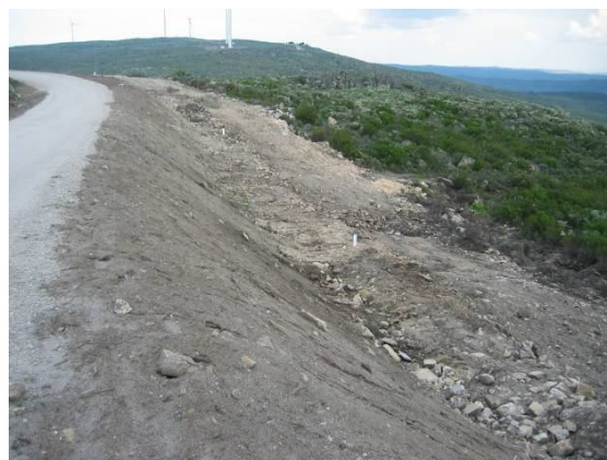
Fotografia 4 - Vala de cabos na via F, entre os aerogeradores AG10 e AG11, após a recuperação paisagística.
