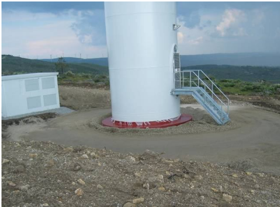
Fotografia 1 - Raquete do aerogerador AG02 após impermeabilização da fundação.
