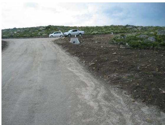
Fotografia 5 - Passagem hidráulica definitiva no início do acesso ao aerogerador AG07.
