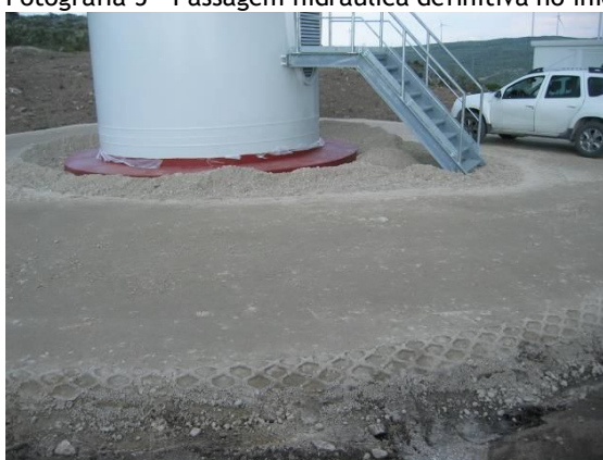
Fotografia 6 - Raquete do aerogerador AG10 durante os trabalhos de impermeabilização da fundação.
