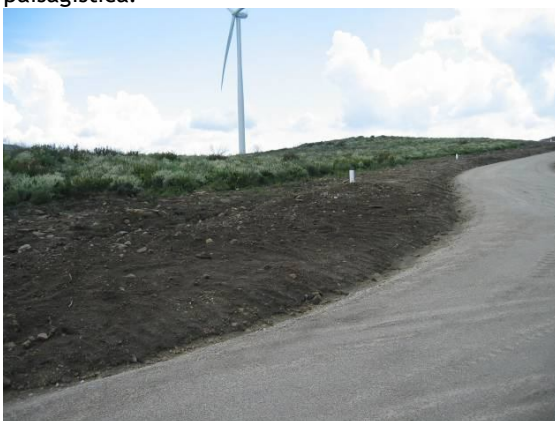
Fotografia 3 - Vala de cabos na via B, entre os aerogeradores AG08 e AG09, após a recuperação paisagística.
