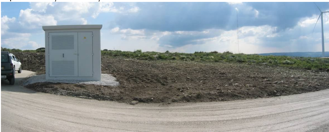
Fotografia 2 - Posto de transformação do aerogerador AG05 e área envolvente após a recuperação paisagística.
