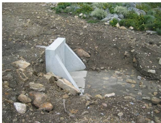
Fotografia 5 - Passagem hidráulica definitiva no início do acesso ao aerogerador AG07.
