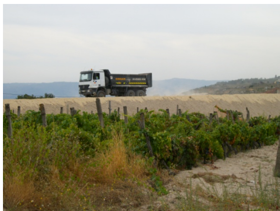
Fotografia da frente de obra na proximidade do local de medição R6 (15-09-2010)
