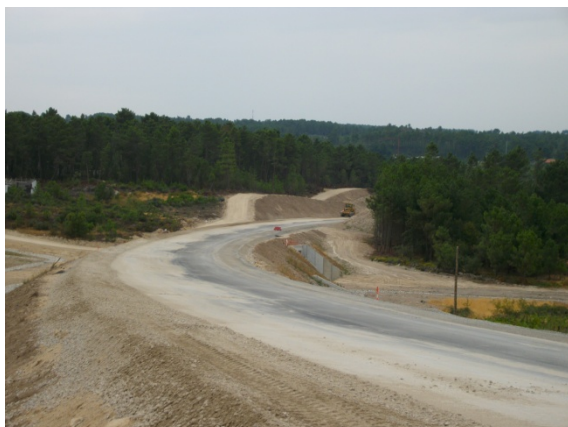
Fotografia da frente de obra na proximidade dos locais de medição R2 (15-09-2010)
