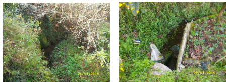
Local de monitorização S3M e S3J
