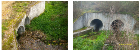
Local de monitorização S4M e S4J
