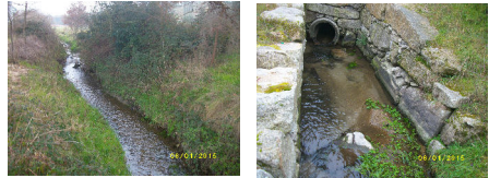
Local de monitorização S8M e S8J
