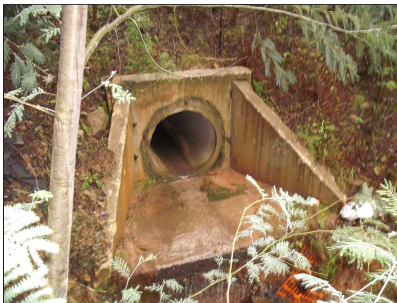
Figura 3.7 – Ponto de recolha 9 – Local de recolha de amostra das águas de escorrência da plataforma da via, antes de serem descarregadas no meio receptor (Rio Caima).
