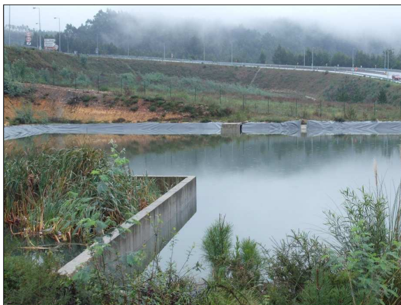
Figura 3.9 – Ponto de recolha 11 – local de saída da bacia de retenção/decantação projectada 1
