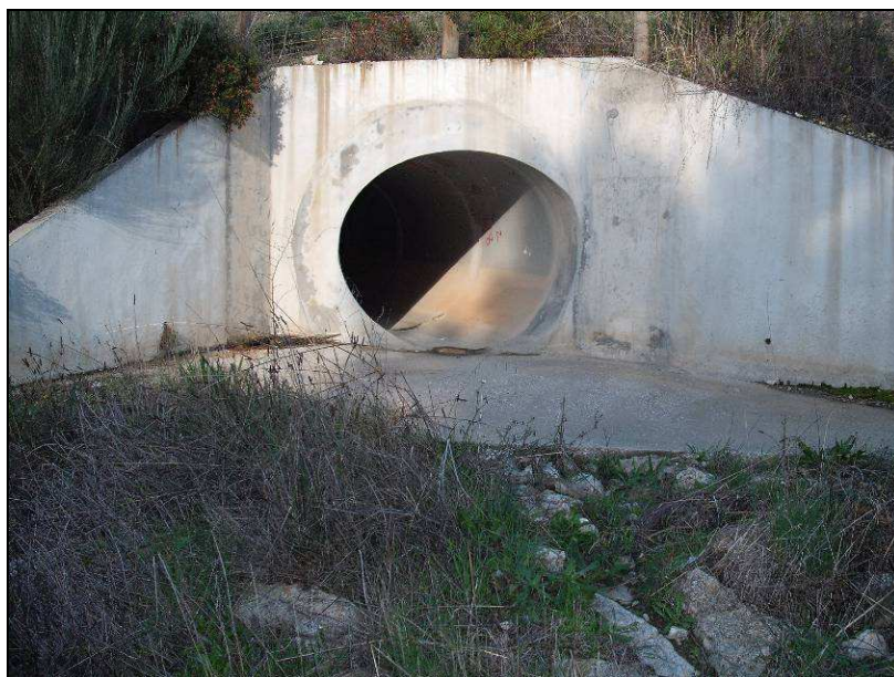
Figura 3.7 – Ponto de recolha 7 – Linha de água restituída pela PH 7.3 (Km 7+704), afluente da margem direita do Rio Mondego, que se considera representativa dos cursos de água receptores com menor dimensão.
