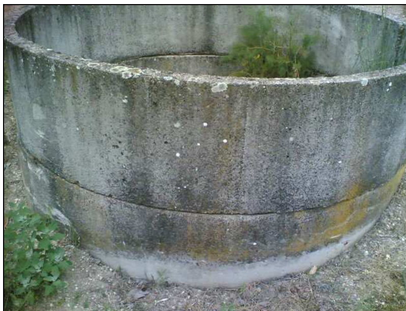
Figura 3.13 – Ponto de recolha 13 – Poço localizado junto ao Pk 17+700.
