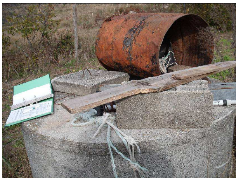
Figura 3.10 – Ponto de recolha 10 – Poço localizado junto da PH 10.3 ao Pk 10+600.
