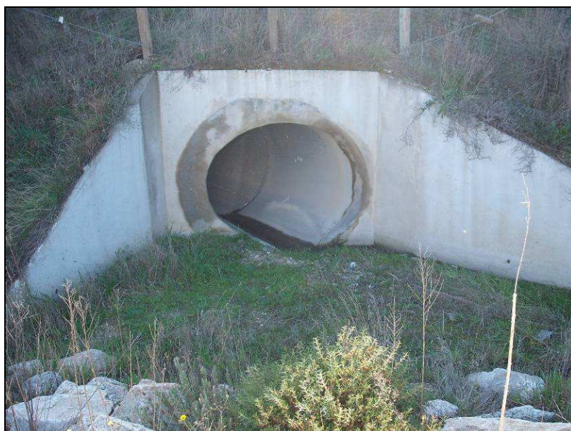
Figura 3.8 – Ponto de recolha 8 – Linha de água restituída pela PH 15.3 (Km 15+685).
