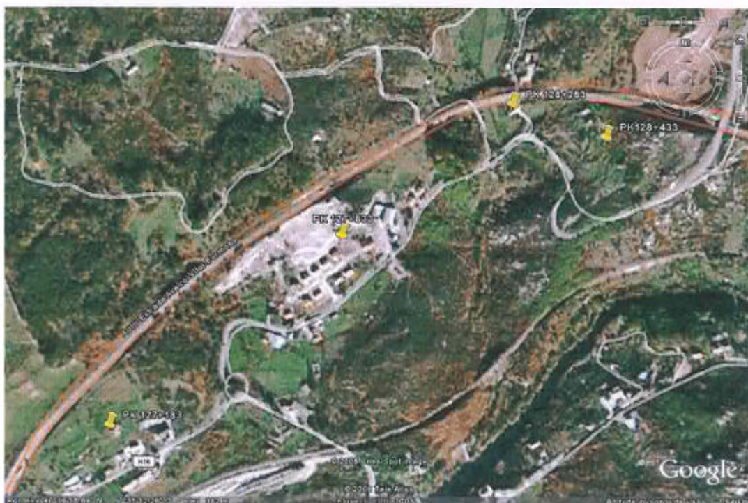
Figura 22 – Localização dos pontos situados ao PK 127+183, PK 127+833, PK 128+283 e PK 128+433
