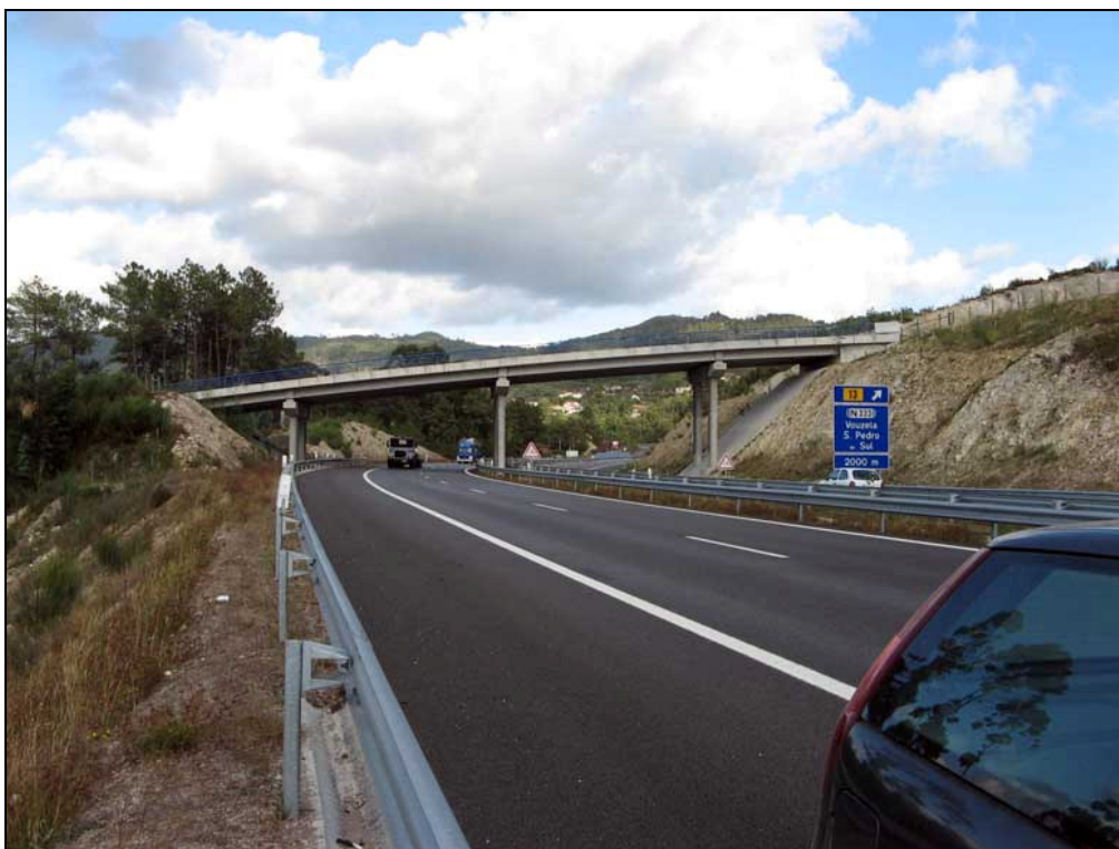
Figura AIII.55 – Ponto de amostragem 18/Passagem superior 14 do sublanço Talhadas-Vouzela na Primavera de 2006.
