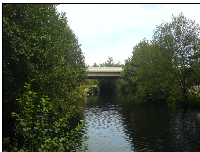
Figura 4.8 – Aspecto do ponto de amostragem.
