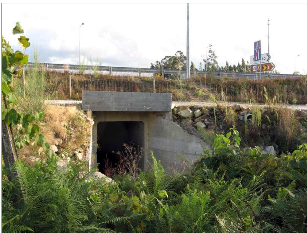
Figura AIII.34 – Ponto de amostragem 6/Passagem hidráulica 4-3 do sublanço Talhadas-Vouzela na Primavera de 2006.
