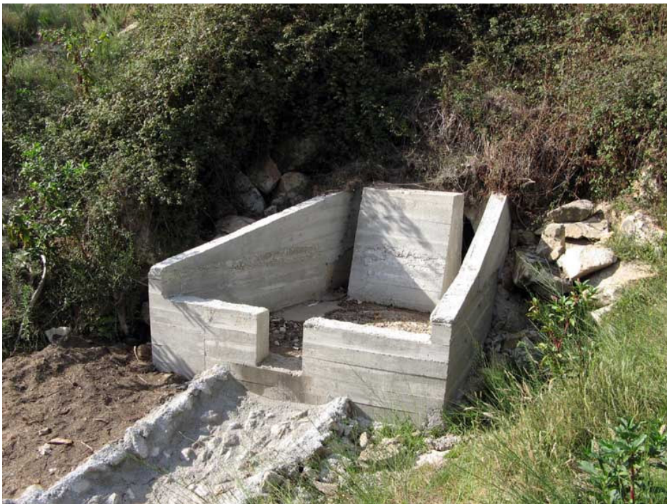
Figura AIII.27 – Ponto de amostragem 1/Passagem hidráulica 0-2 do sublanço Talhadas-Vouzela na Primavera de 2006.
