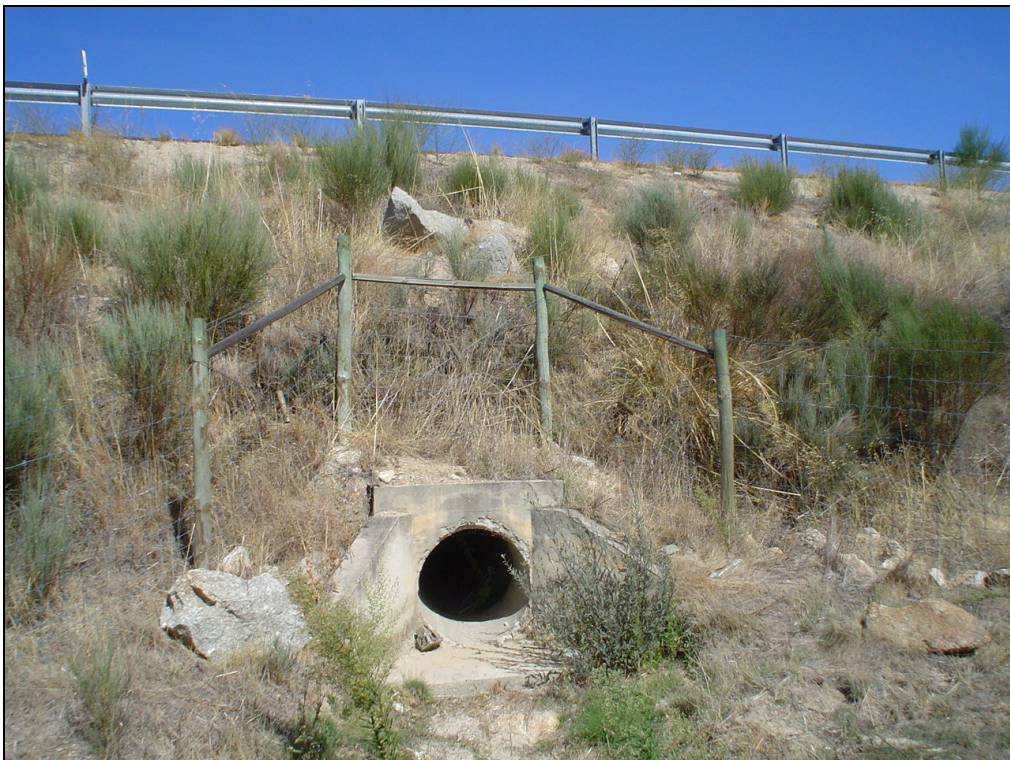
Figura AIII.100 – Ponto de amostragem 10/Passagem hidráulica 27-2 do sublanço Guarda-Vilar Formoso na Primavera de 2006.
