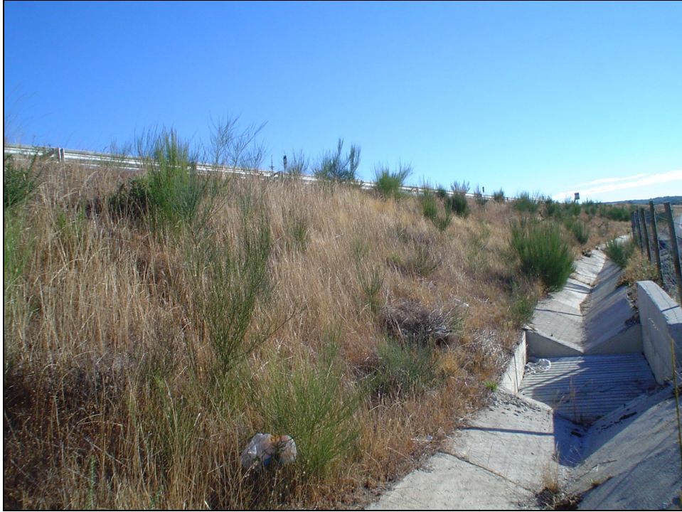
Figura AIII.82 – Ponto de amostragem 1/Passagem hidráulica 5-1 do sublanço Guarda-Vilar Formoso na Primavera de 2006.
