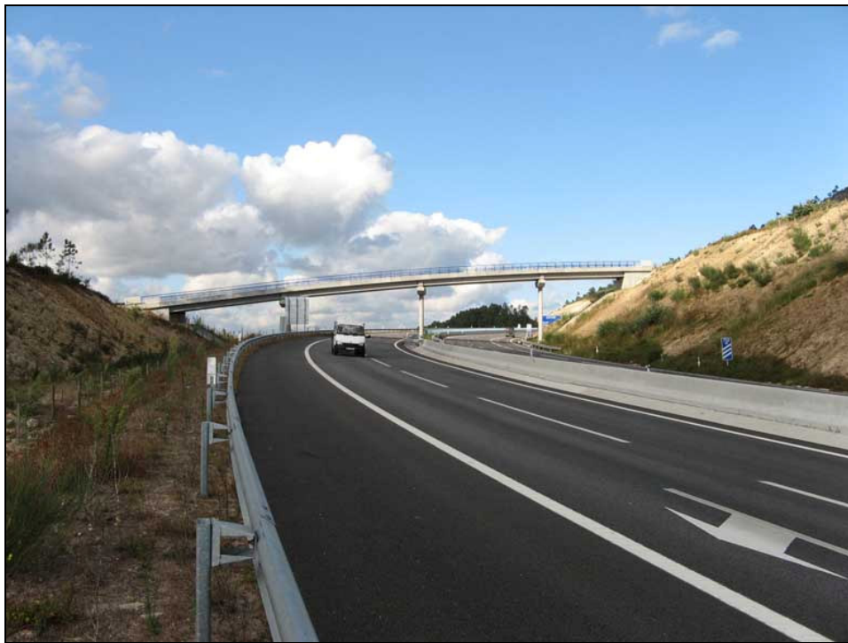
Figura AIII.58 – Ponto de amostragem 21/Passagem superior 17 do sublanço Talhadas-Vouzela na Primavera de 2006.
