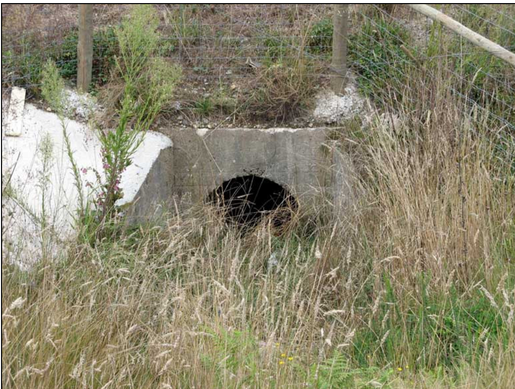
Figura AIII.51 – Ponto de amostragem 15/Passagem hidráulica 12-1 do sublanço Talhadas-Vouzela na Primavera de 2006.
