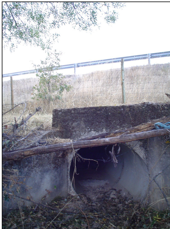
Figura AIII.94 – Ponto de amostragem 7/Passagem hidráulica 15-1 do sublanço Guarda-Vilar Formoso na Primavera de 2006.
