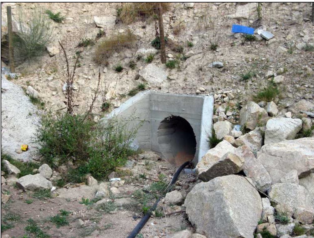
Figura AIII.65 - Ponto de amostragem 5/Passagem hidráulica 5-1 do sublanço Vouzela-Boa Aldeia na Primavera de 2006.
