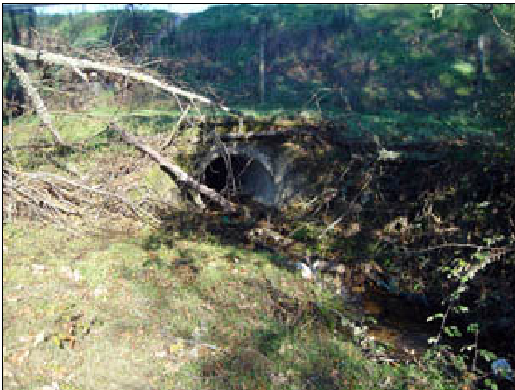
Figura AIII.95 – Ponto de amostragem 7/Passagem hidráulica 15-1 do sublanço Guarda-Vilar Formoso no Outono de 2006.
