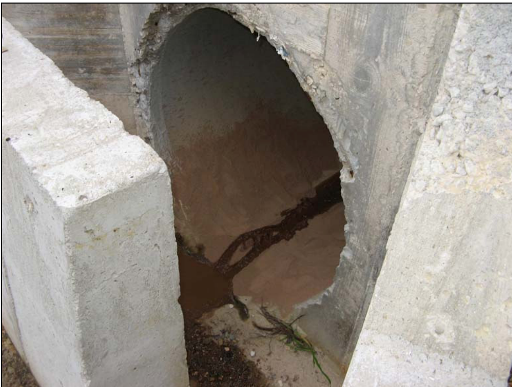
Figura AIII.21 – Ponto de amostragem 15/Passagem hidráulica 9-2 do sublanço IC2-Talhadas no Outono de 2006.
