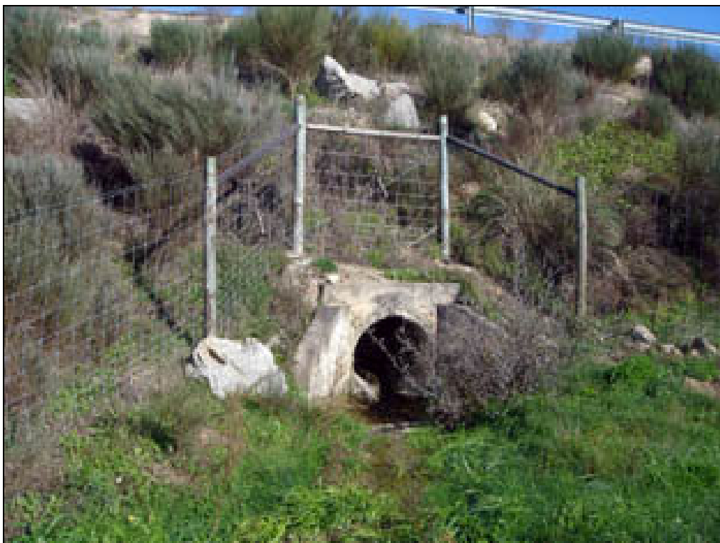
Figura AIII.101 – Ponto de amostragem 10/Passagem hidráulica 27-2 do sublanço Guarda-Vilar Formoso no Outono de 2006.
