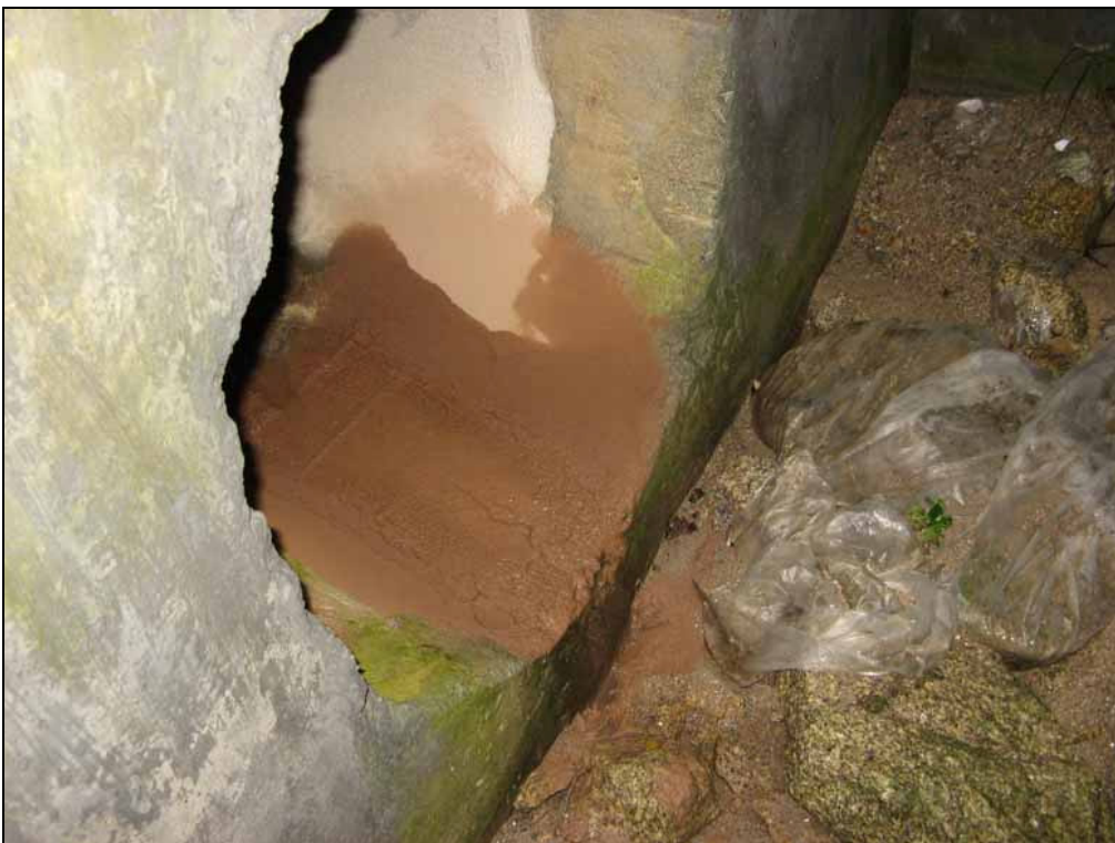
Figura AIII. 77 – Ponto de amostragem 12/Passagem hidráulica 9-3 do sublanço Vouzela-Boa Aldeia no Outono de 2006.
