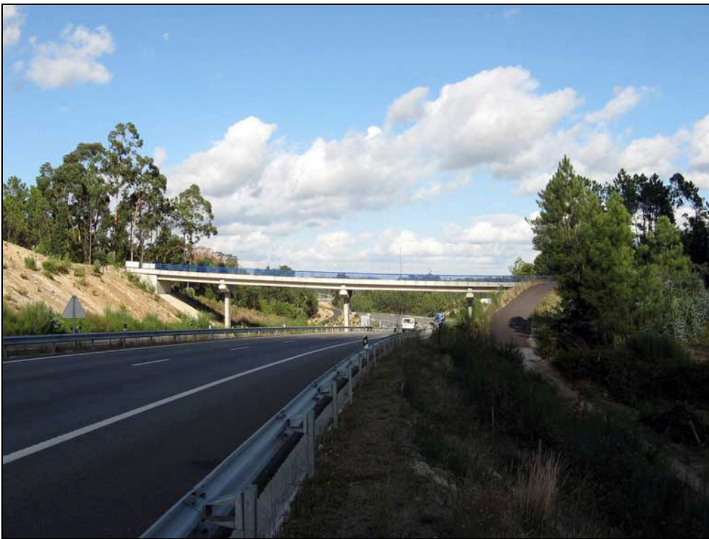
Figura AIII.32 – Ponto de amostragem 4/Passagem superior 4 do sublanço Talhadas-Vouzela na Primavera de 2006.
