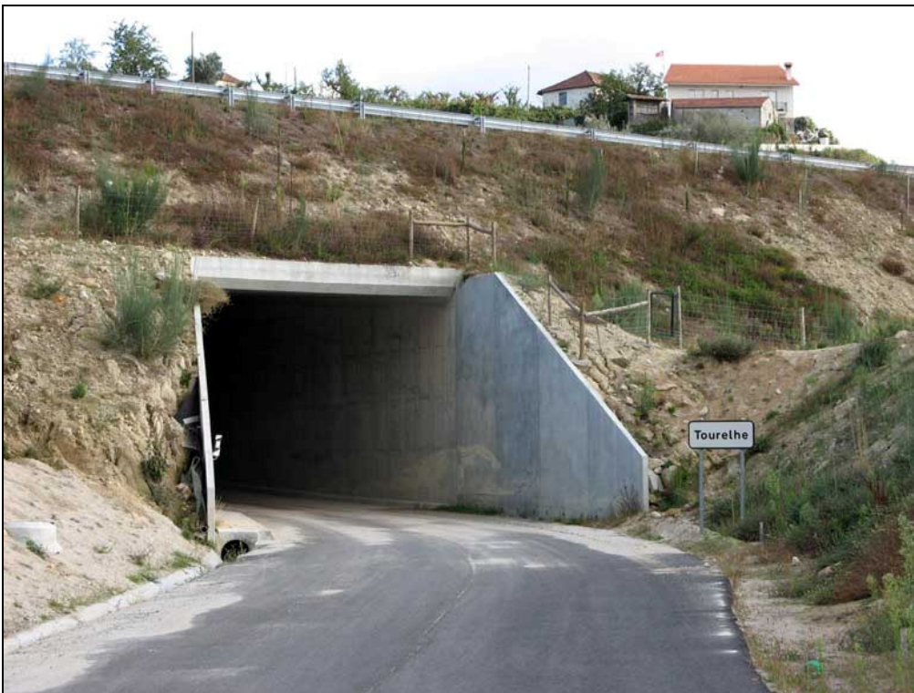
Figura AIII.56 – Ponto de amostragem 19/Passagem inferior 5 do sublanço Talhadas-Vouzela na Primavera de 2006.
