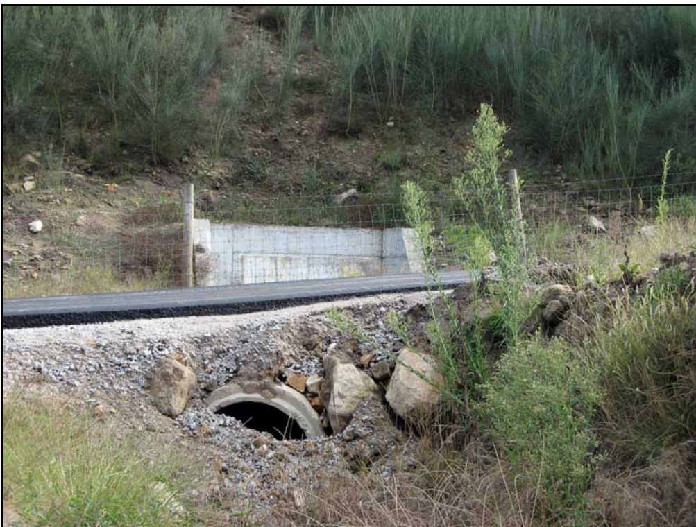
Figura AIII.41 – Ponto de amostragem 10/Passagem hidráulica 7-1 do sublanço Talhadas-Vouzela na Primavera de 2006.
