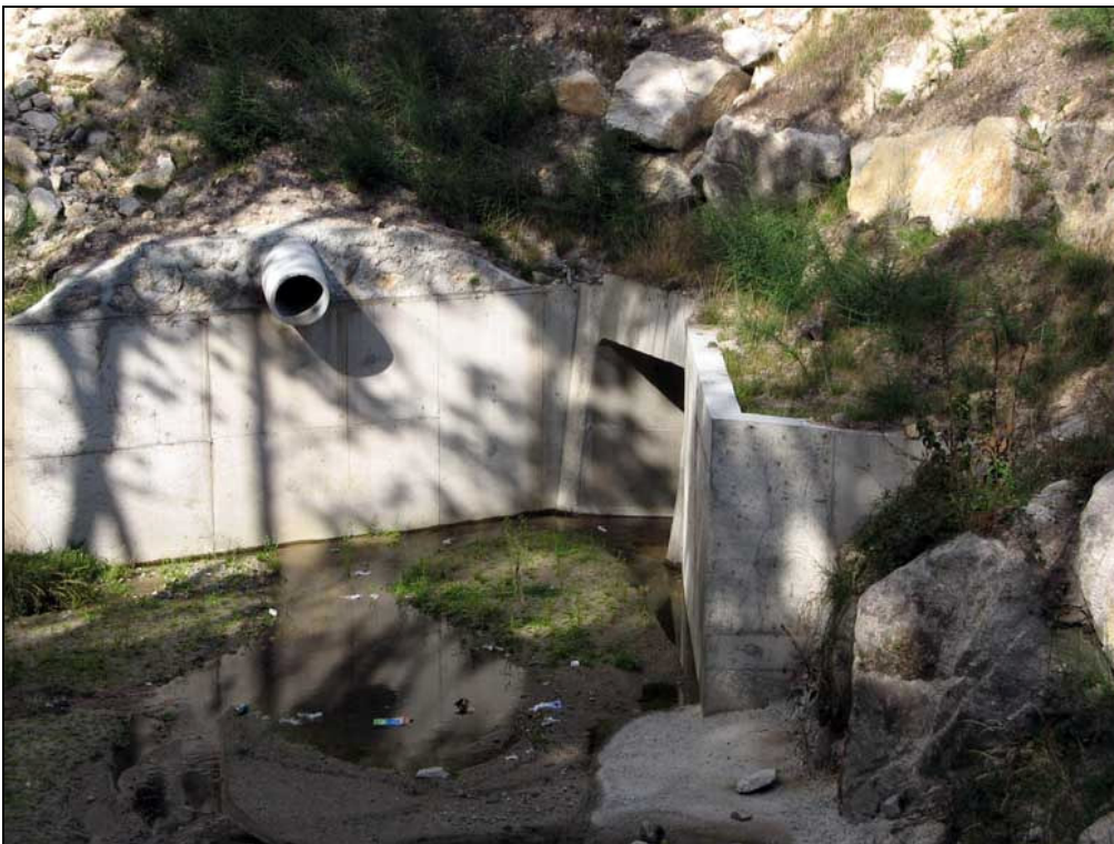
Figura AIII.72 – Ponto de amostragem 10/Passagem hidráulica 8-5 do sublanço Vouzela-Boa Aldeia na Primavera de 2006.
