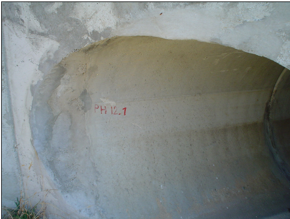
Figura AIII.90 – Ponto de amostragem 5/Passagem hidráulica 12-1 do sublanço Guarda-Vilar Formoso na Primavera de 2006.
