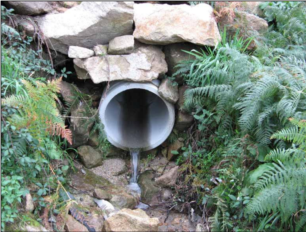
Figura AIII.62 - Ponto de amostragem 2/Passagem hidráulica 4-1 do sublanço Vouzela-Boa Aldeia no Outono de 2006.
