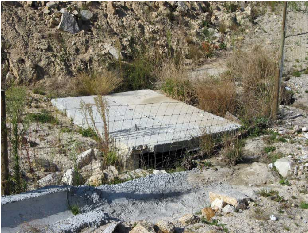
Figura AIII.68 – Ponto de amostragem 7/Passagem hidráulica 5-2 do sublanço Vouzela-Boa Aldeia na Primavera de 2006.
