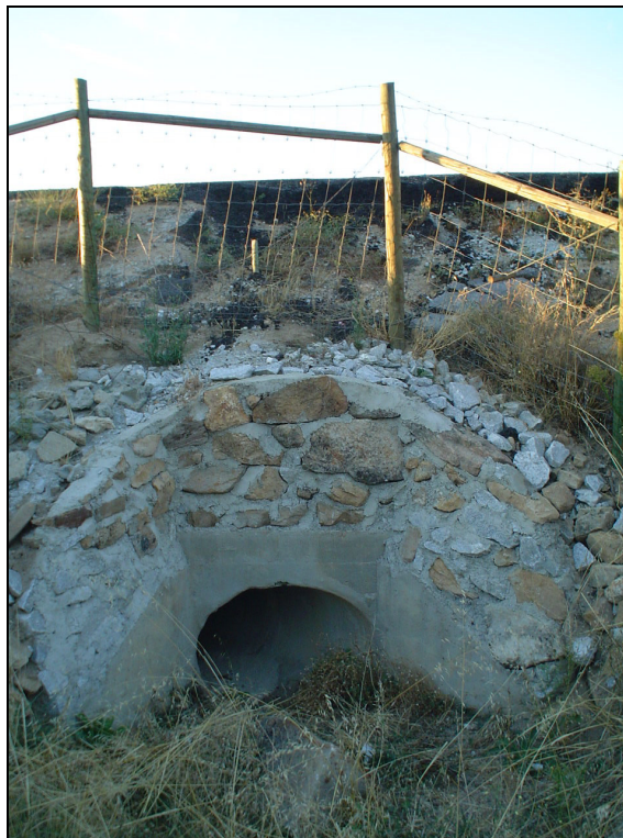
Figura AIII.96 – Ponto de amostragem 8/Passagem hidráulica 18-1 do sublanço Guarda-Vilar Formoso na Primavera de 2006.
