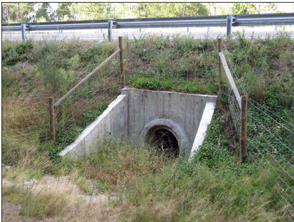
Figura AIII.53 – Ponto de amostragem 17/Passagem hidráulica 13-1 do sublanço Talhadas-Vouzela na Primavera de 2006.
