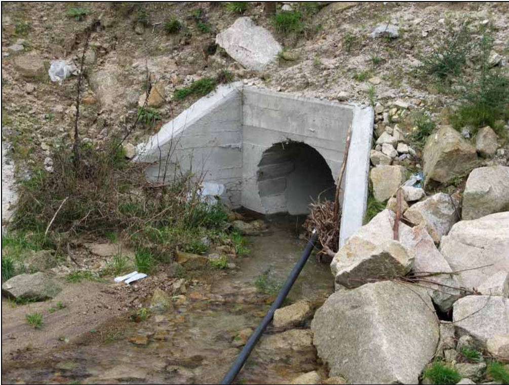
Figura AIII.66 – Ponto de amostragem 5/Passagem hidráulica 5-1 do sublanço Vouzela-Boa Aldeia no Outono de 2006.
