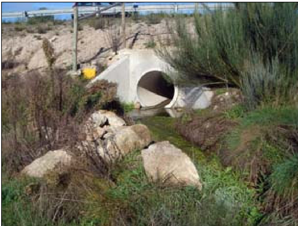
Figura AIII.85 – Ponto de amostragem 2/Passagem hidráulica 6-2 do sublanço Guarda-Vilar Formoso no Outono de 2006.
