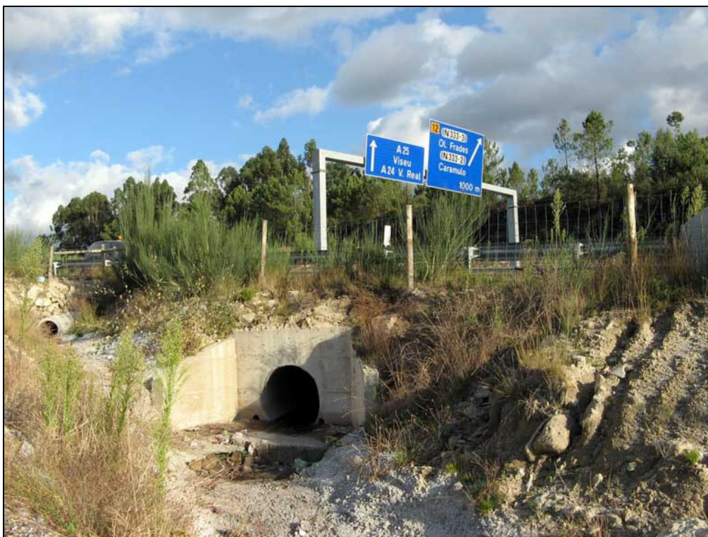
Figura AIII.43 – Ponto de amostragem 11/Passagem hidráulica 9-2 do sublanço Talhadas-Vouzela na Primavera de 2006.
