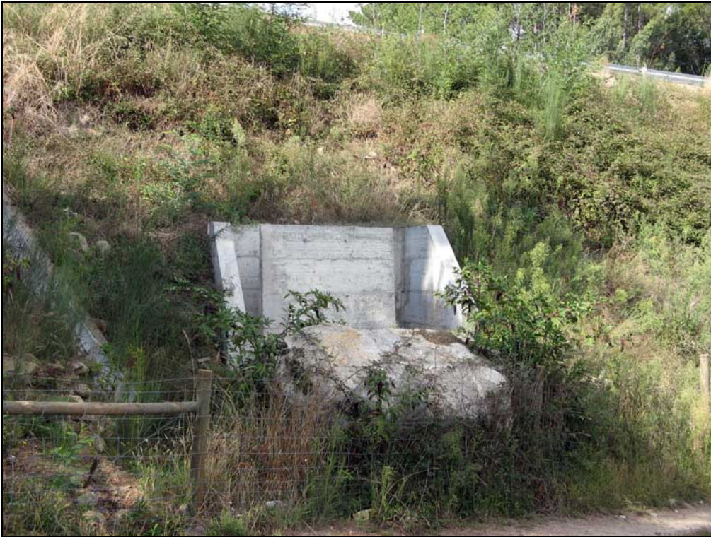
Figura AIII.30 – Ponto de amostragem 3/Passagem hidráulica 3-2 do sublanço Talhadas-Vouzela na Primavera de 2006.
