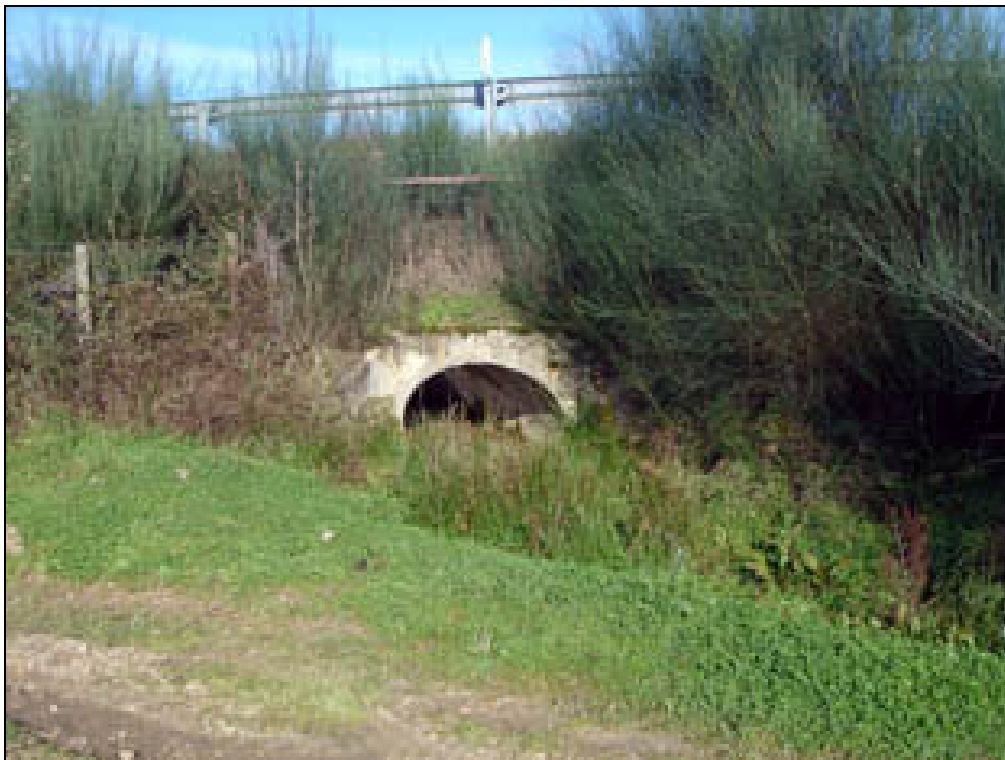
Figura AIII.89 – Ponto de amostragem 4/Passagem hidráulica 8-1 do sublanço Guarda-Vilar Formoso no Outono de 2006.
