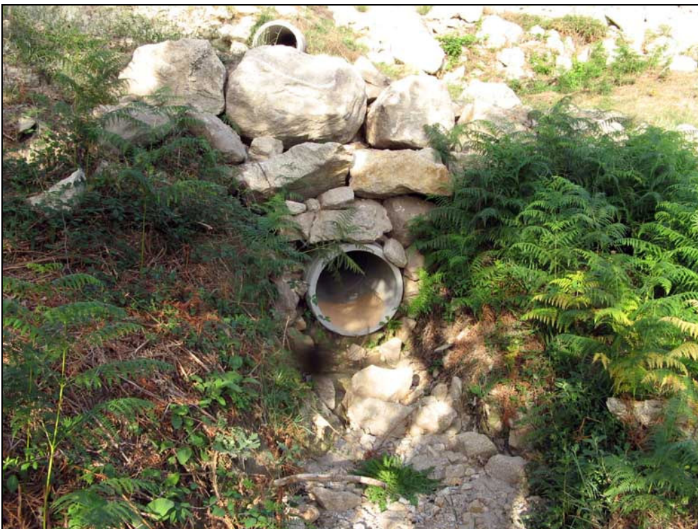
Figura AIII.61 – Ponto de amostragem 2/Passagem hidráulica 4-1 do sublanço Vouzela-Boa Aldeia na Primavera de 2006.
