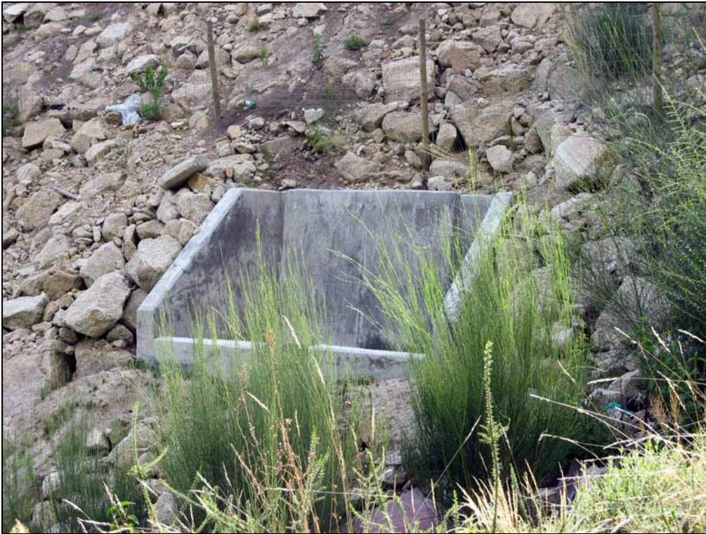
Figura AIII.76 – Ponto de amostragem 12/Passagem hidráulica 9-3 do sublanço Vouzela-Boa Aldeia na Primavera de 2006.
