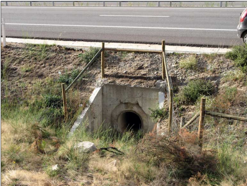
Figura AIII.52 – Ponto de amostragem 16/Passagem hidráulica 12-3 do sublanço Talhadas-Vouzela na Primavera de 2006.
