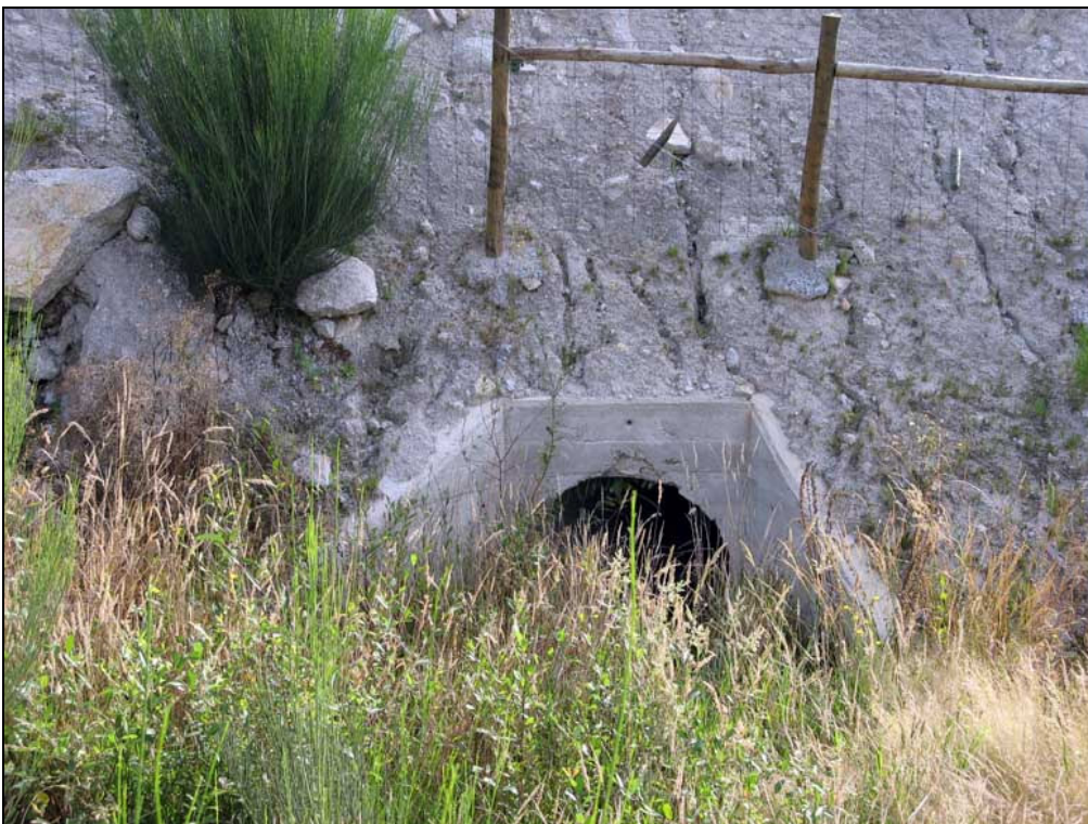
Figura AIII.71 – Ponto de amostragem 9/Passagem hidráulica 8-1 do sublanço Vouzela-Boa Aldeia na Primavera de 2006.
