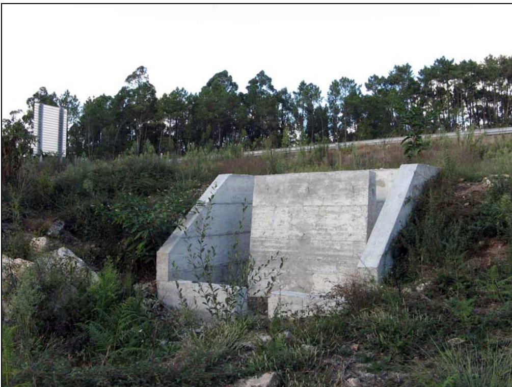
Figura AIII.39 – Ponto de amostragem 9/Passagem hidráulica 6-1 do sublanço Talhadas-Vouzela na Primavera de 2006.
