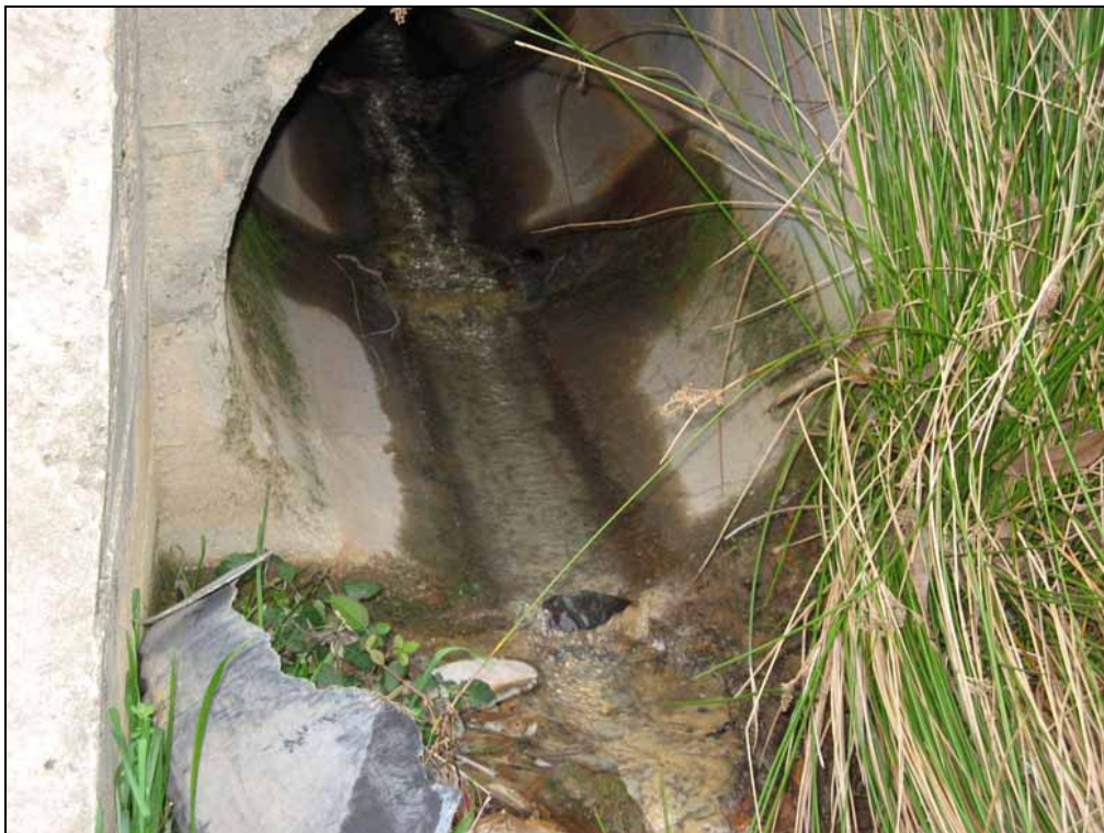
Figura AIII.16 - Ponto de amostragem 11/Passagem hidráulica 6-2 do sublanço IC2-Talhadas no Outono de 2006.
