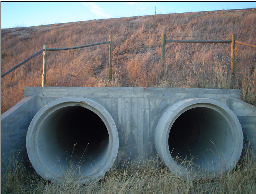
Figura AIII.98 – Ponto de amostragem 9/Passagem hidráulica 22-2 do sublanço Guarda-Vilar Formoso na Primavera de 2006.
