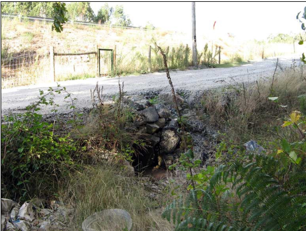
Figura AIII.47 - Ponto de amostragem 13/Passagem hidráulica 11-2 do sublanço Talhadas-Vouzela na Primavera de 2006.
