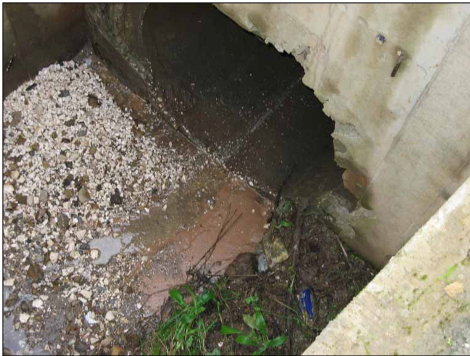
Figura AIII.26 – Ponto de amostragem 19/Passagem hidráulica 13-1 do sublanço IC2-Talhadas no Outono de 2006.
