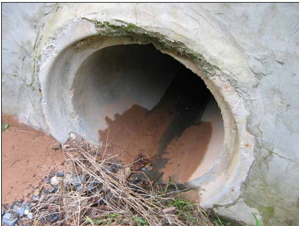
Figura AIII.5 – Ponto de amostragem 3/Passagem hidráulica 0-4 do sublanço IC2-Talhadas no Outono de 2006.
