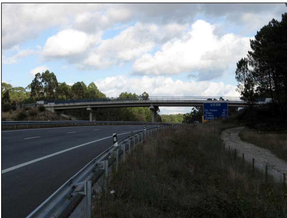
Figura AIII.36 – Ponto de amostragem 7/Passagem superior 6 do sublanço Talhadas-Vouzela na Primavera de 2006.
