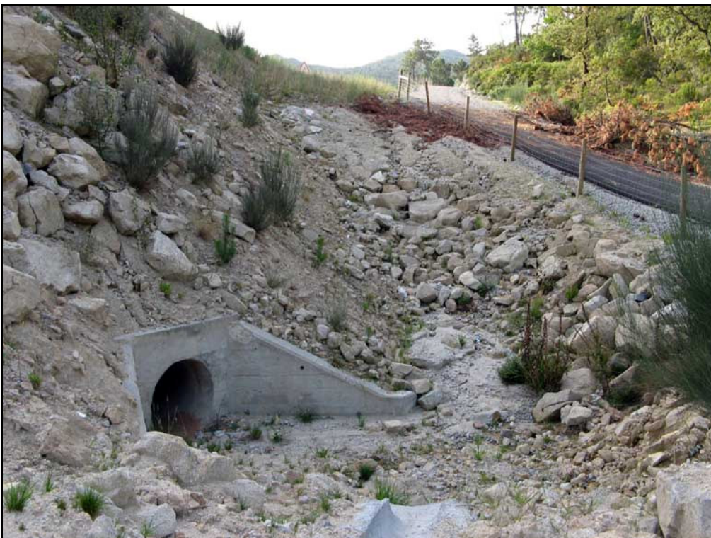
Figura AIII.63 - Ponto de amostragem 3/Passagem hidráulica 4-2 do sublanço Vouzela-Boa Aldeia na Primavera de 2006.
