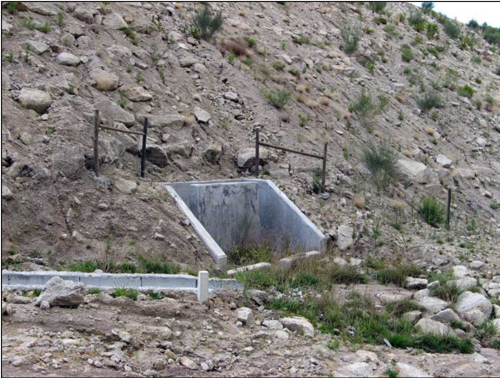
Figura AIII.74 – Ponto de amostragem 11/Passagem hidráulica 9-2 do sublanço Vouzela-Boa Aldeia na Primavera de 2006.
