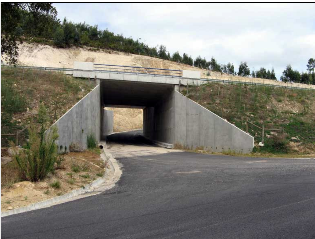
Figura AIII.29 – Ponto de amostragem 2/Passagem inferior 1 do sublanço Talhadas-Vouzela na Primavera de 2006.
