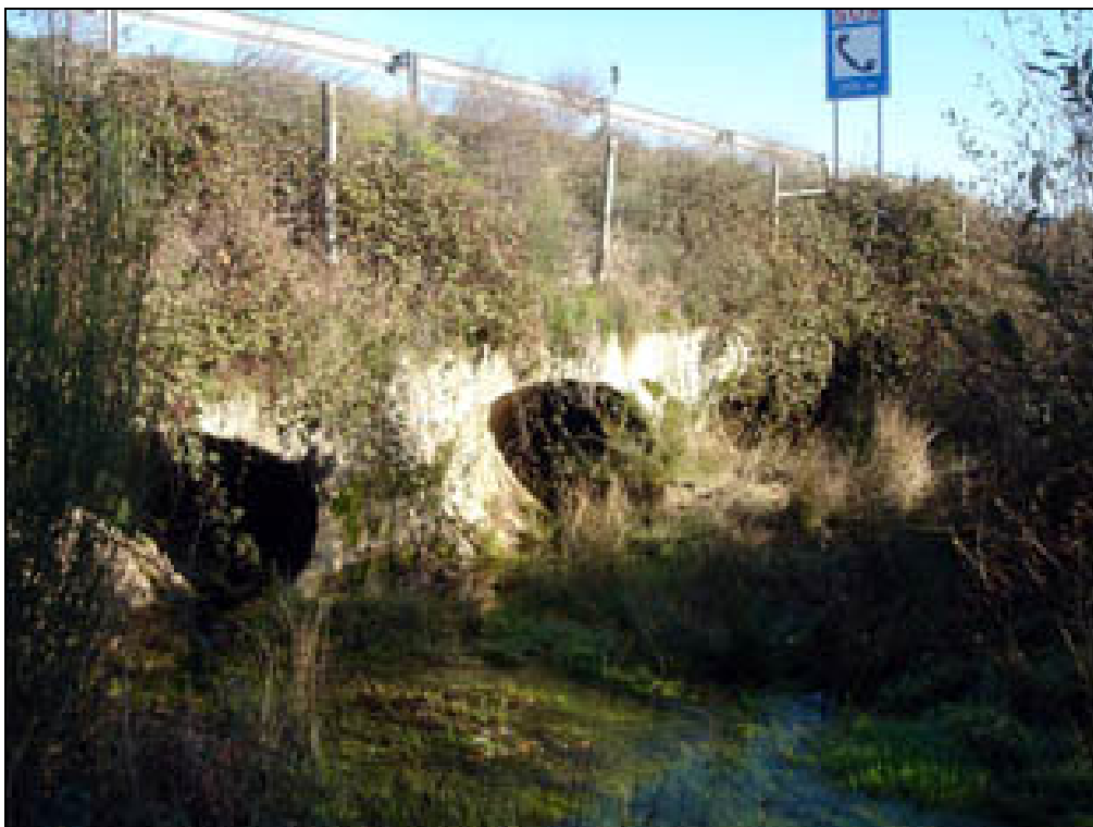
Figura AIII.91 – Ponto de amostragem 5/Passagem hidráulica 12-1 do sublanço Guarda-Vilar Formoso no Outono de 2006.
