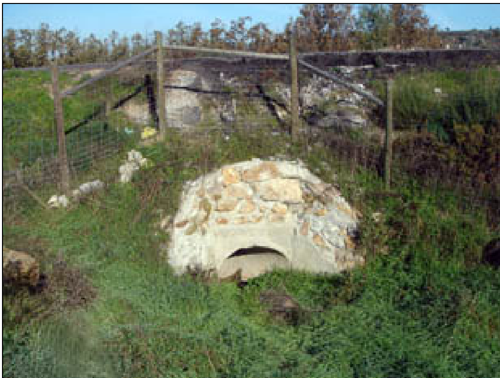
Figura AIII.97 – Ponto de amostragem 8/Passagem hidráulica 18-1 do sublanço Guarda-Vilar Formoso no Outono de 2006.
