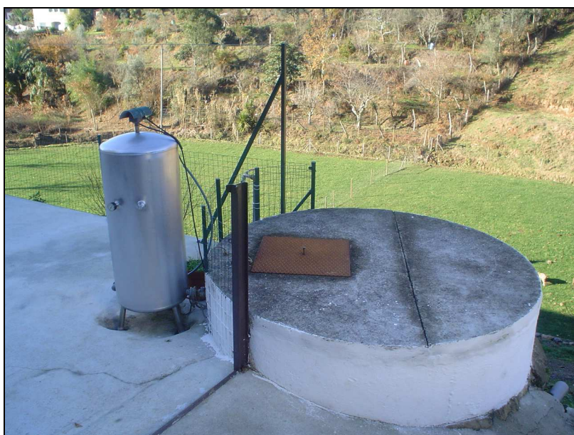
Figura 3.7 – Ponto de recolha 7 – Poço.a cerca do Km 1+500, a Norte de Sernada do Vouga.
