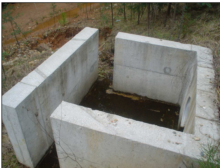
Figura 3.11 – Ponto de recolha 11 – ponto à saída da bacia de retenção/decantação projectada 1
