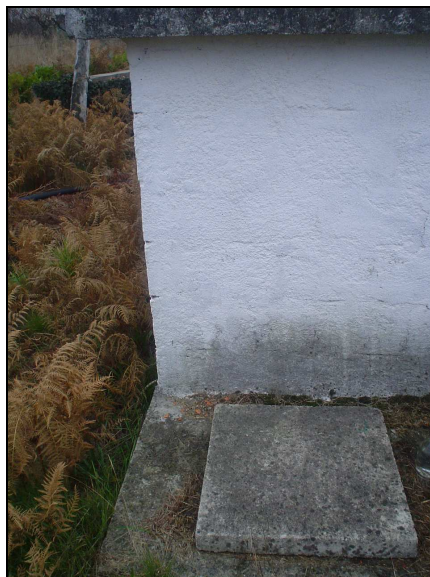
Figura 3.10 – Ponto de recolha 10 – Poço a cerca do Km 10+900, próximo de Cambarinho.
