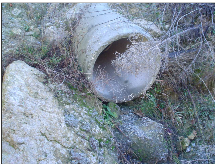
Figura 3.14 – Ponto de recolha 14 – Local de recolha de amostra das águas de descarga da plataforma antes destas serem descarregadas no meio receptor (Rio Couto).
