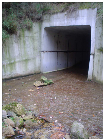
Figura 3.7 – Ponto de recolha 7 - Linha de água restituída pela PH 11.2 ao Km 11+475, tributária da albufeira de uma pequena barragem, na Ribeira de Carvalho Redondo, integrada no Aproveitamento Hidroagrícola da Vasconha – montante.
