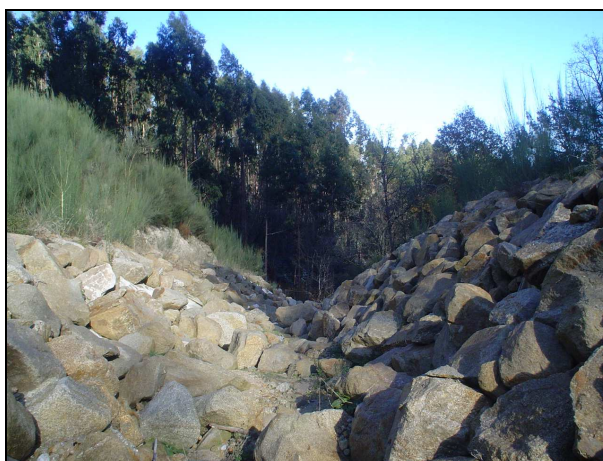
Figura 3.2 – Ponto de recolha 2 – Afluente da margem esquerda do Rio Zela atravessada pelo Viaduto 1 ao Km 3+555 e 3+755, para onde serão encaminhadas as águas da plataforma e respectivo Viaduto – jusante.
