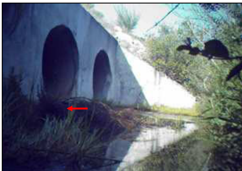
Figura 4.2 – Coruja-das-torres detectada na PH 12-1 do lote IP2 – EN332.
