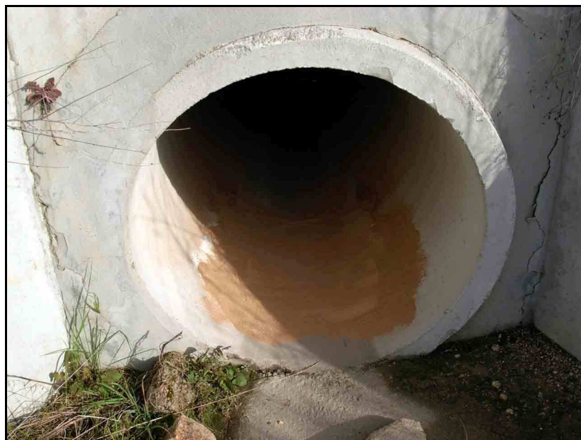
Figura 3.1 – Exemplo da utilização de pó de pedra para impressão de pegadas e rastros dos animais (Passagem hidráulica 6-2 no lote IP2 - EN332).
