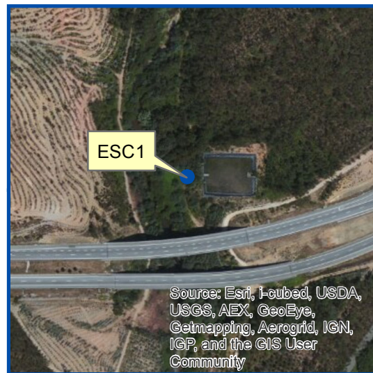
Local de monitorização ESC 1
