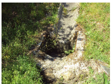
Local de monitorização ESC 3
