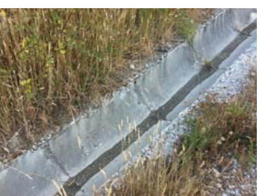
LOCAL DE MONITORIZAÇÃO ESC3
