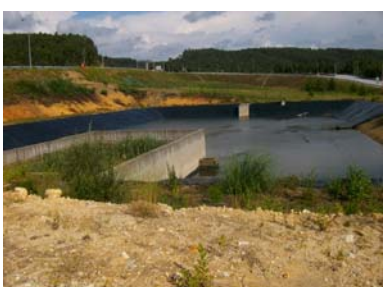
LOCAL DE MONITORIZAÇÃO ESC2
