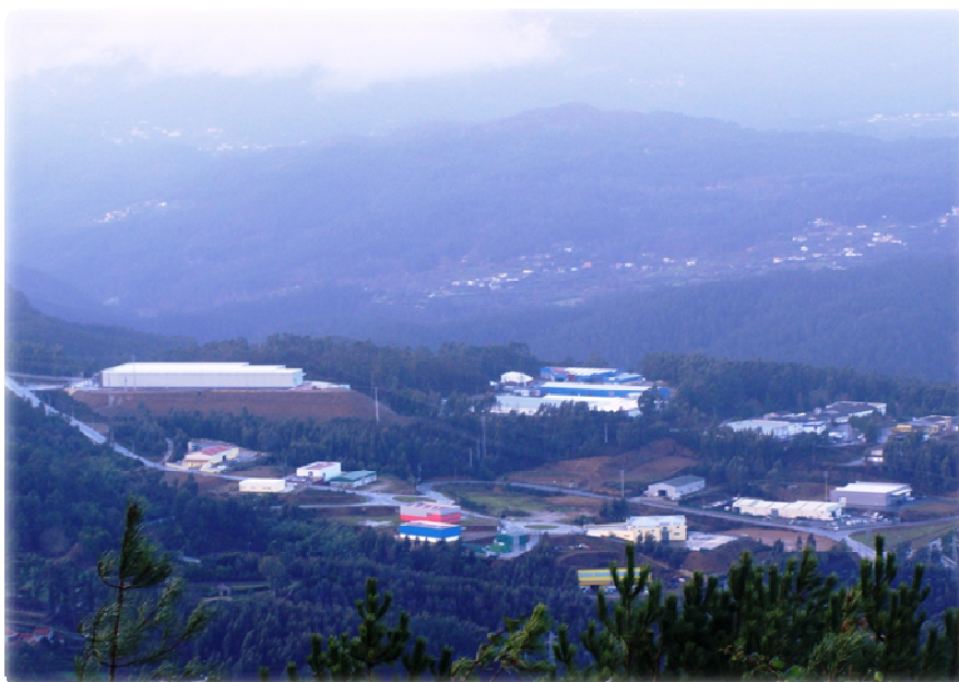
Fotografia 6 – Panorâmica geral da zona industrial de Monte Cavallo (Lote 3)
