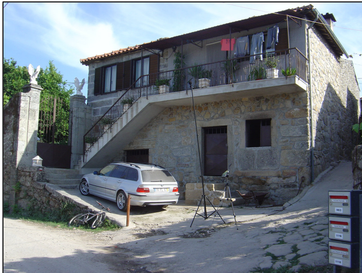
Foto 3. Ponto de medição acústica P4, localizado junto a habitação unifamiliar com dois pisos (a 4m da fachada), situado a Norte/Poente da Subestação (a cerca de 300m).
