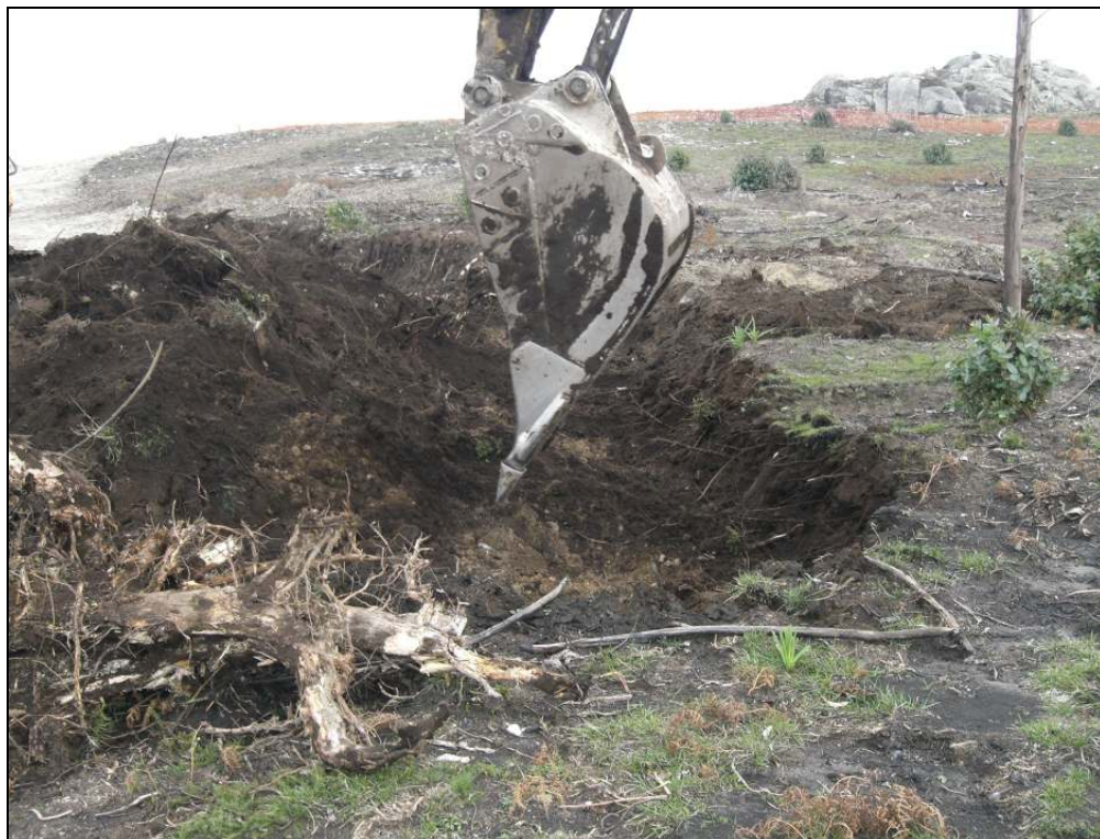
Intervenção na área da futura estrada definitiva de acesso
