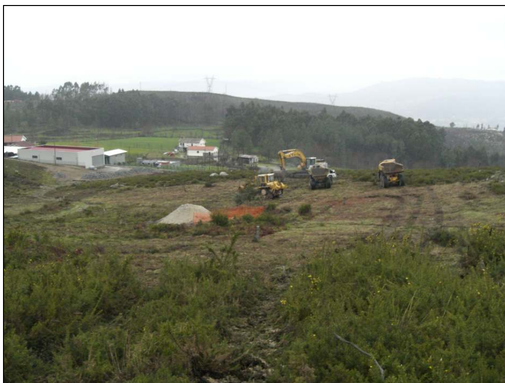
Início da intervenção na vertente Norte da plataforma.
