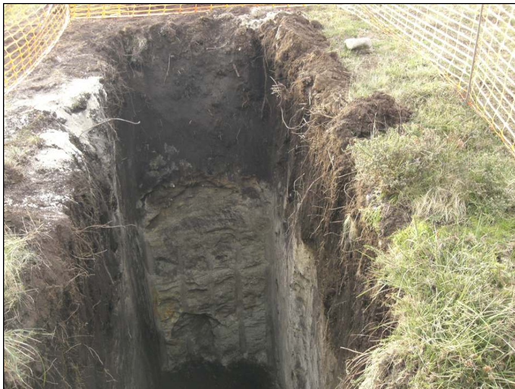
Abertura de poços de sondagem para verificação de material ao lado Norte da plataforma
