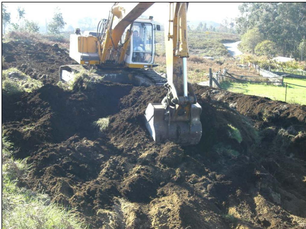
Abertura de vala para escoamento de águas pluviais na vertente suave do lado Norte
