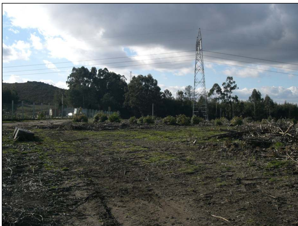
Área correspondente à futura estrada de acesso antes da intervenção
