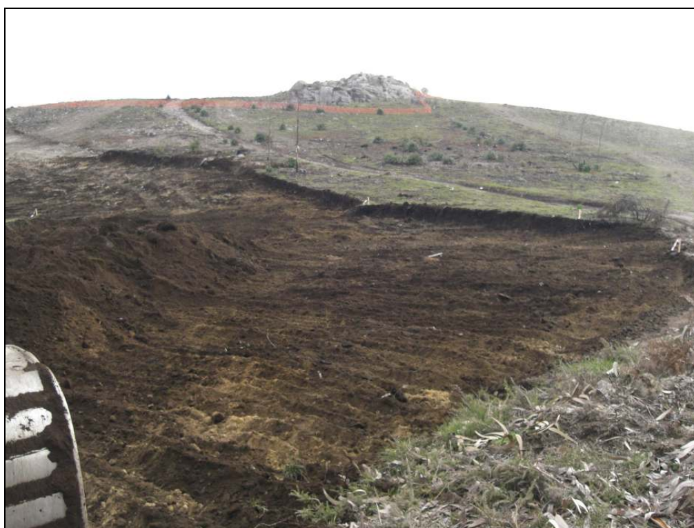
Desmatção a finalizar na área da estrada de acesso
